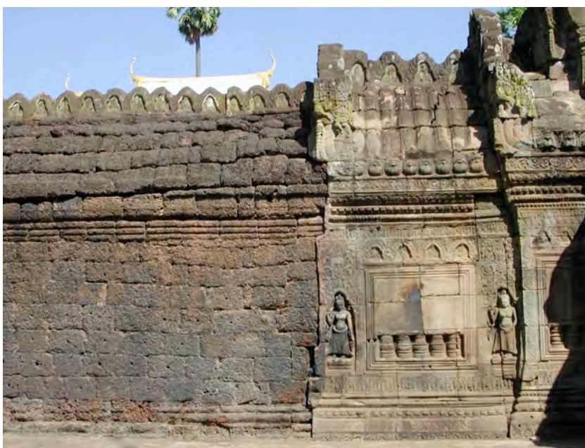
Ph. 32 : Exemple de la confrontation de la latérite avec le grès à la première enceinte de Vat Nokor, Cambodge, fin du XII e siècle
