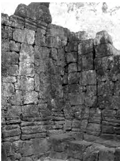
Ph. 940 : Angle Sud-Ouest du pavillon d'angle Nord-Est MS.17 de la première enceinte
