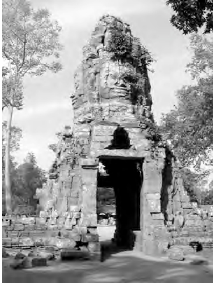
Ph. 90 : Face Est de la porte Ouest TP.220 de l'enceinte de domaine de Ta Prohm
