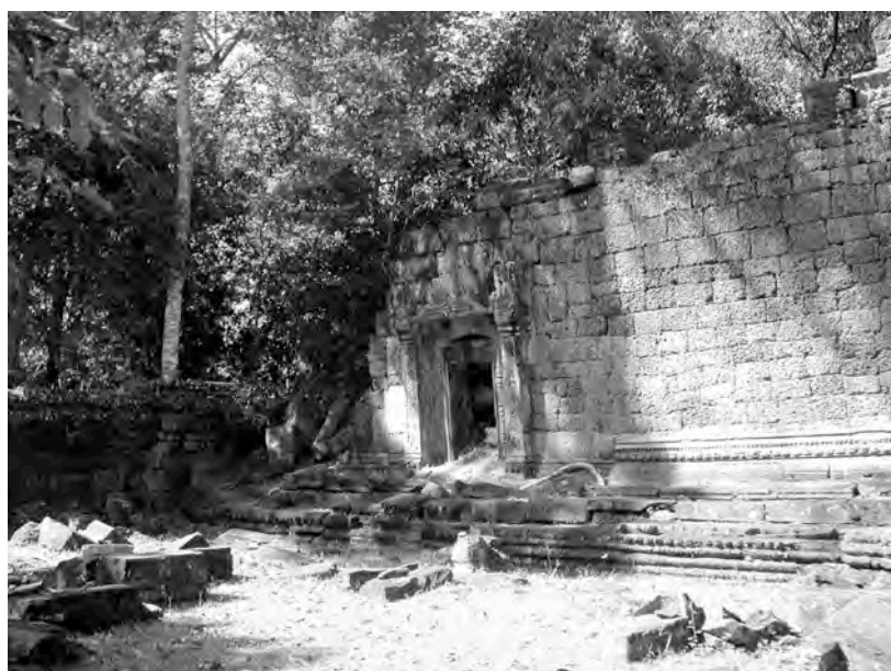
Ph. 103 : Entrée latérale Sud du pavillon d'entrée occidental TP.211 de la quatrième enceinte de Ta Prohm
