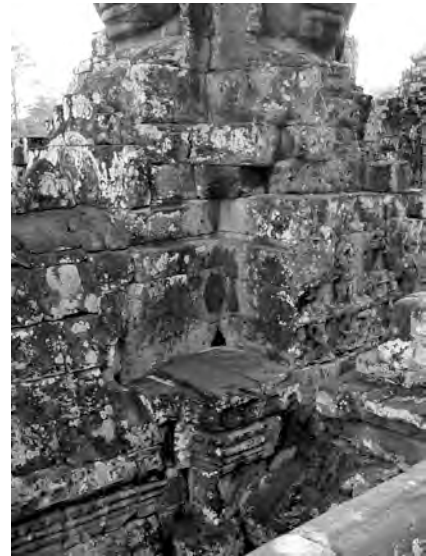
Ph. 934 : Angle Nord-Est de la tour BY.40 du second étage du Bayon
