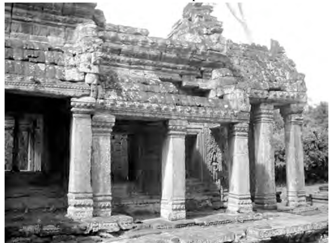
Ph. 296 : Demi-galerie courant le long du bras et de l'avant-corps Nord du pavillon PK.160 de l'enceinte du temple
