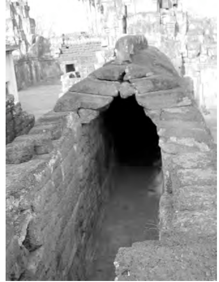
Ph. 498 : Exemple de tronçon de galerie de la première enceinte de Vat Nokor
