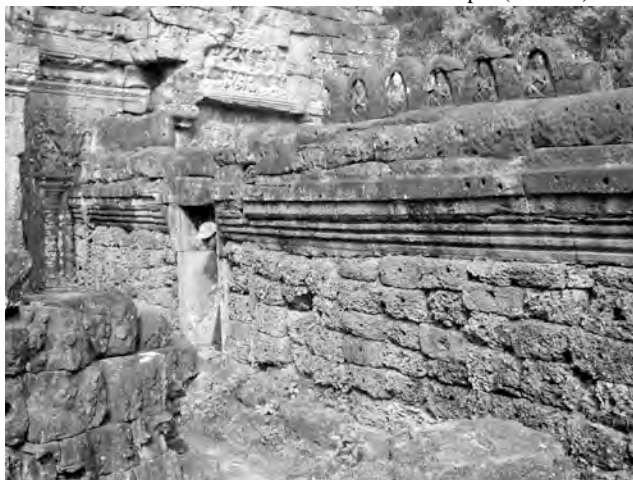
Ph. 310 : Mur Nord PK.116 entre le pavillon d'entrée Ouest PK.157 de l'enceinte du temple et le pavillon d'angle Nord-Ouest de l'enceinte du “ cloître ” occidental
