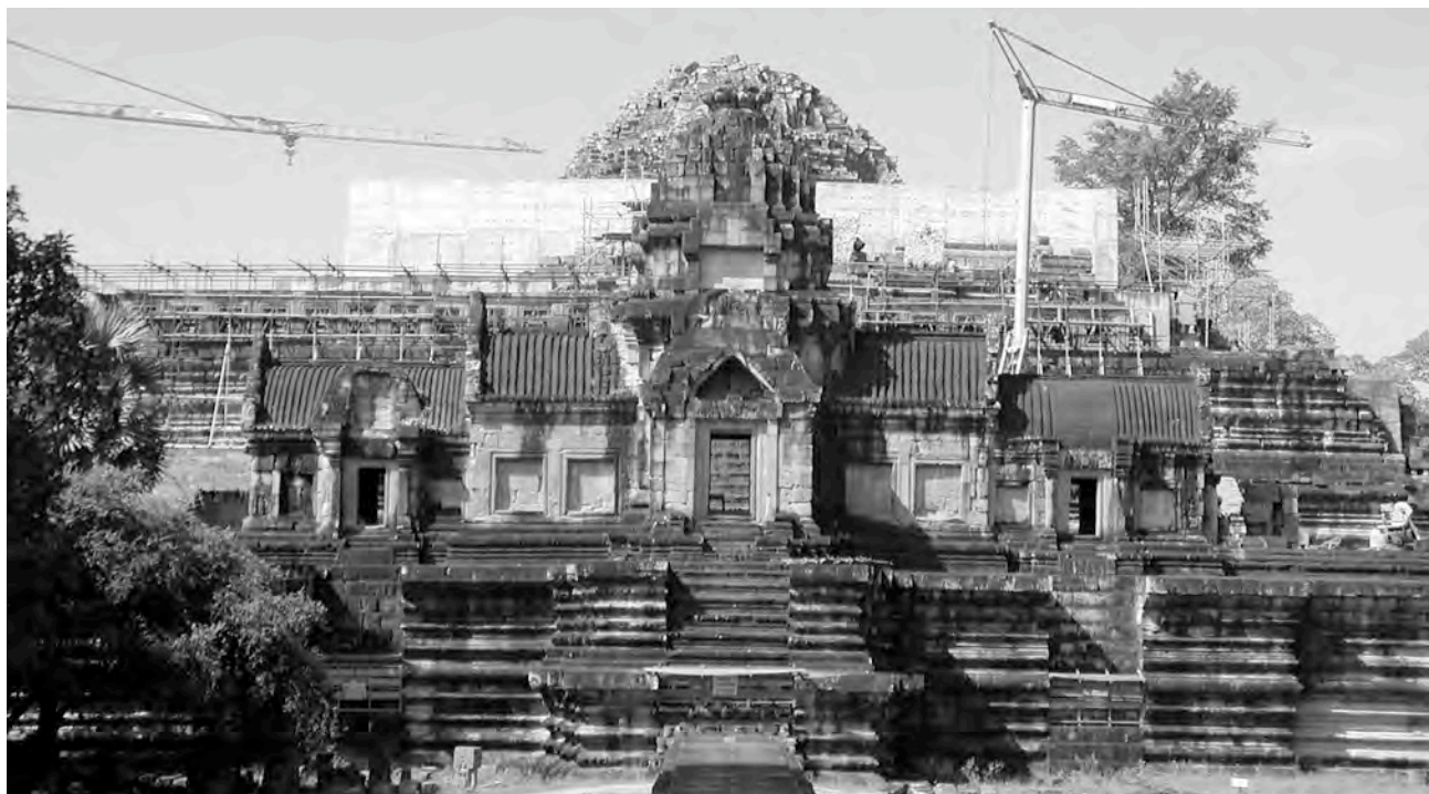
Ph. 6 : Face orientale du Baphuon (restauration effectuée par l'EFEO)
