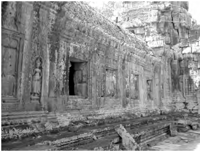
Ph. 217 : Vue extérieure du tronçon Nord BK.27 de la première enceinte
