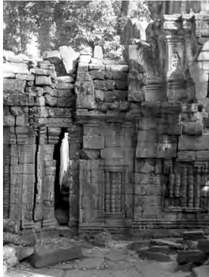
Ph. 142 : Passage couvert entre l'entrée Sud du tronçon Est de la galerie TP.37 du “ cloître ” oriental (à gauche) et l'entrée Ouest de l'édifice TP.48 (à droite)
