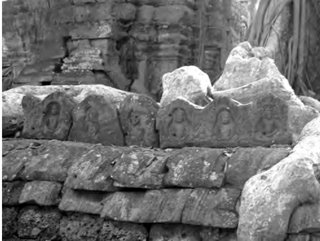
Ph. 967 : Faîtages du cloître oriental TP.37 de Ta Prohm
