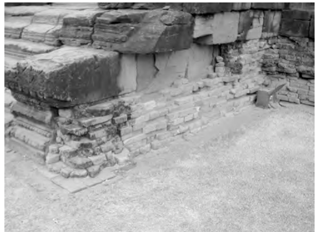
Ph. 604 : Vestiges d'une enceinte en briques englobés dans le soubassement du pavillon d'entrée oriental de la première enceinte de Phimai
