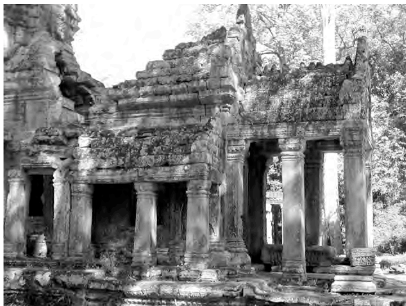
Ph. 288 : Avant-corps oriental du pavillon central PK.148 de l'entrée orientale de l'enceinte du temple et son porche après restauration par le WMF
