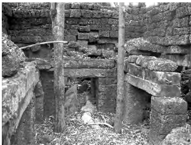
Ph. 123 : Patio de l'annexe TP.51
