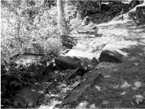
Ph. 179 : Vestiges de l'escalier du bras Nord de la douve Sud BK.52 de l'enceinte du temple
