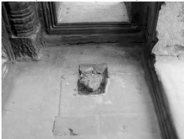
Ph. 339 : Avant-corps Ouest du pavillon d'entrée Est PK.36 de la première enceinte où prenait place la stèle du monument
