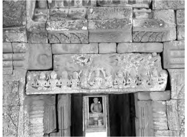
Ph. 931 : Linteau de l'avant-corps Ouest du pavillon axial occidental VN.15 de la première enceinte de Vat Nokor
