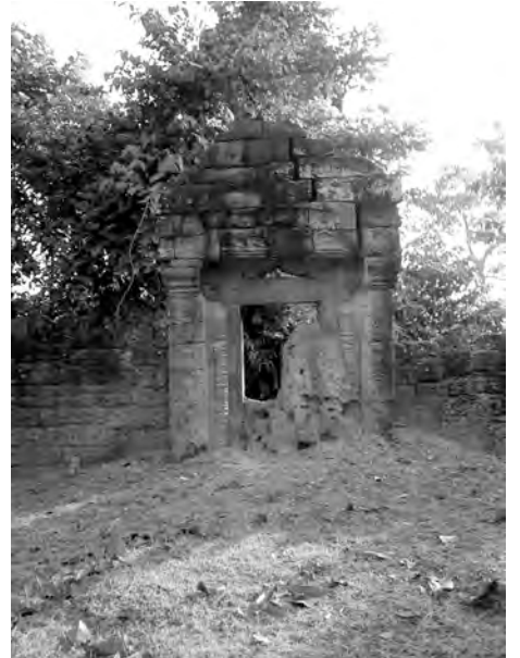
Ph. 444 : Porte occidentale PPP.4 de l'enceinte de Prasat Prei Prasat
