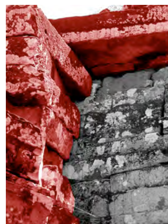
Ph. 611 : Extrados de la "bibliothèque" Sud de Banteay Kdei (Les maçonneries ajoutées sont en rouge)
