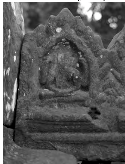
Ph. 642 : Faîtage de type 4 à niche avec Lokeçvara partiellement bûché au Neak Pean
