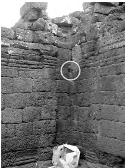
Ph. 920 : Angle Sud-Ouest du pavillon d’angle VN.22
