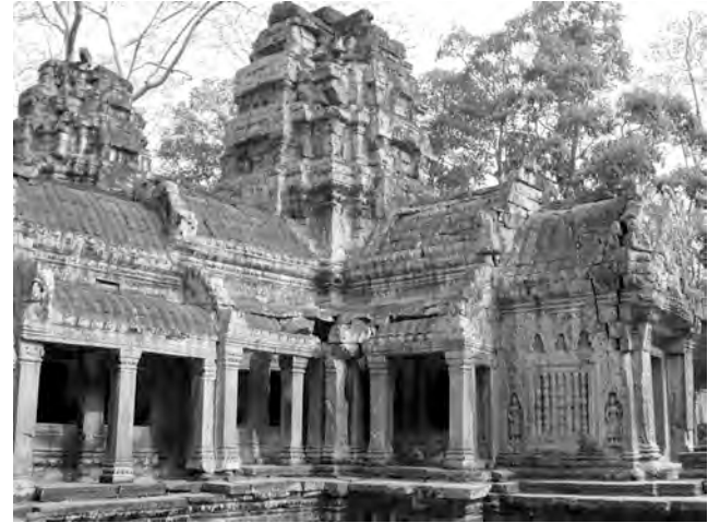
Ph. 117 : Pavillon d'entrée occidental TP.93 de la troisième enceinte de Ta Prohm (vue de l'angle Nord-Ouest)
