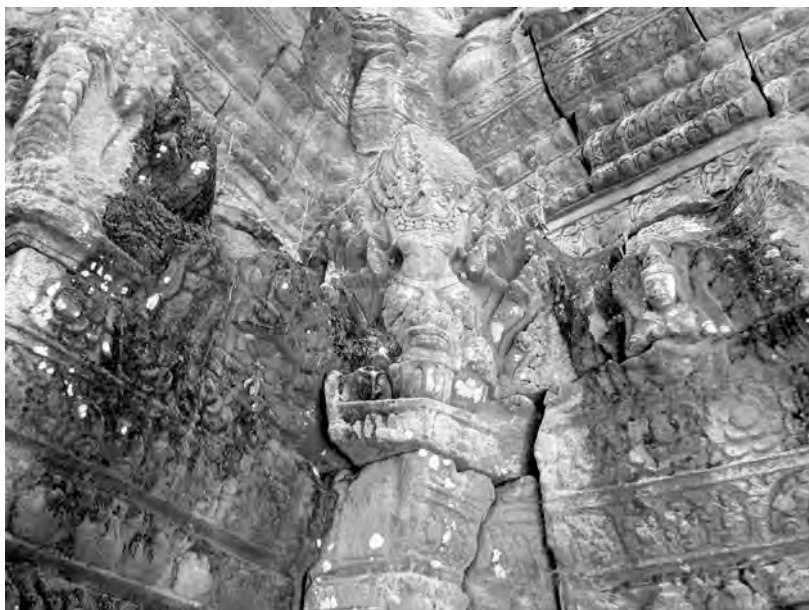
Ph. 669 : Angle formé par les faux bas-côtés des avant-corps du sanctuaire central de Ta Prohm de Bati
