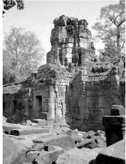
Ph. 385 : Pavillon d'entrée Sud BP.7 de la première enceinte de Banteay Kdei
