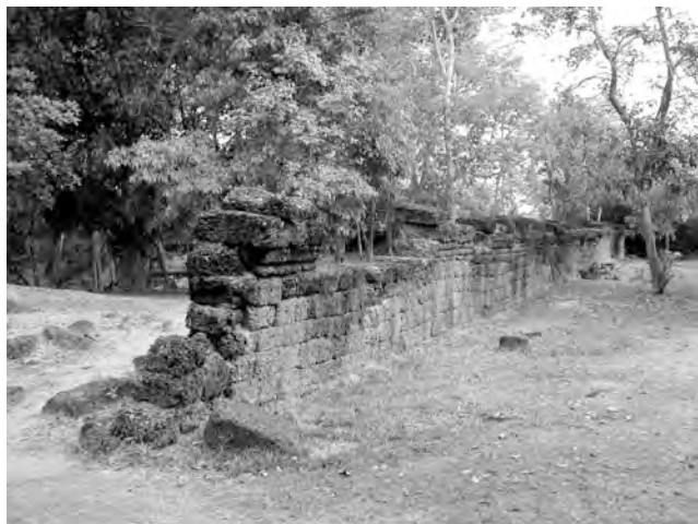
Ph. 401 : Mur de la deuxième enceinte de Krol Kô
