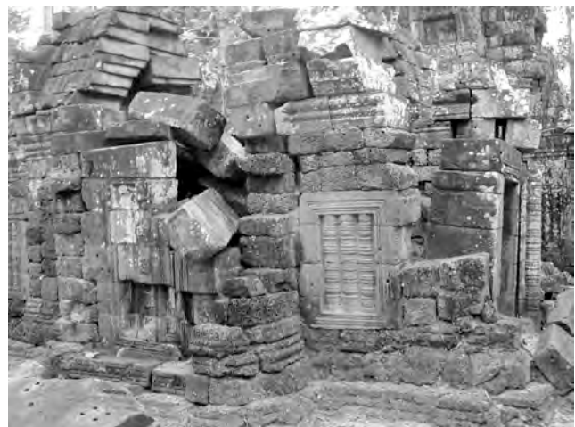
Ph. 262 : Pavillon d'angle Nord-Ouest TN.19 de la première enceinte de Ta Nei
