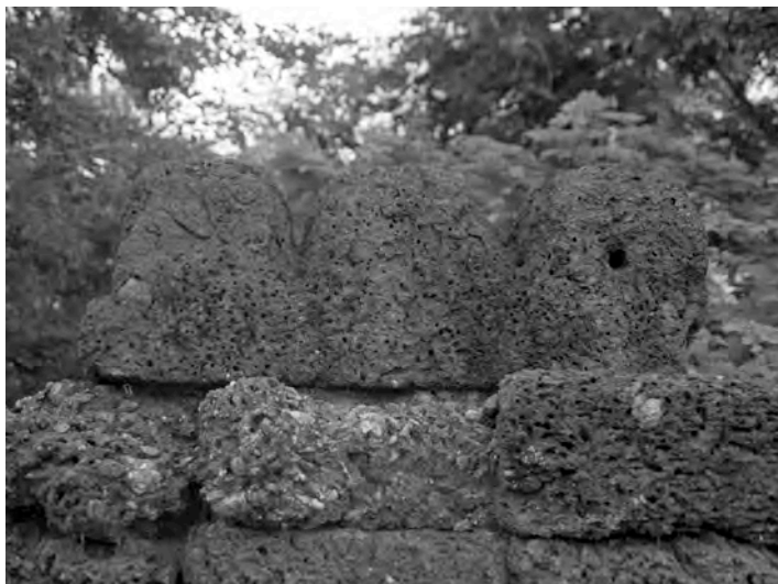
Ph. 643 : Faîtage de type 4 en latérite de la 1 ère enceinte de Prasat Prei
