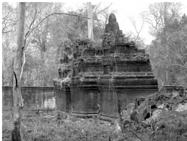
Ph. 550 : Tours PKKS.31, 32, 33 et vestiges de la tour PKKS.34
