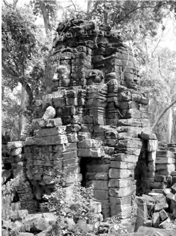
Ph. 478 : Vue d'ensemble de la " bibliothèque " Sud-Est BC.64 du complexe occidental
