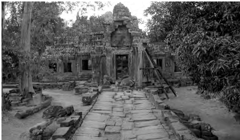
Ph. 190 : Chaussée BK.40 reliant le pavillon d'entrée occidental BK.49 de l'enceinte du temple au pavillon d'entrée occidental BK.33 de la seconde enceinte
