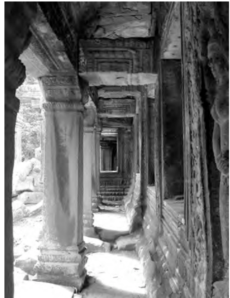
Ph. 115 : Demi-galerie contribuant la face Sud de l'avant-corps Est du pavillon d'entrée Sud TP.87 de la troisième enceinte de Ta Prohm
