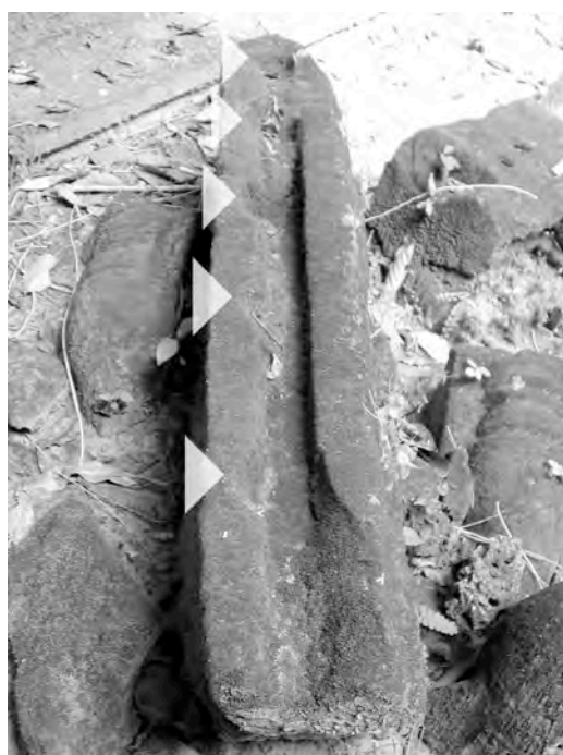
Ph. 633 : Embarrure présentant des vestiges de mortaise située au pied de la galerie TP.79 du cloître Nord de Ta Prohm
