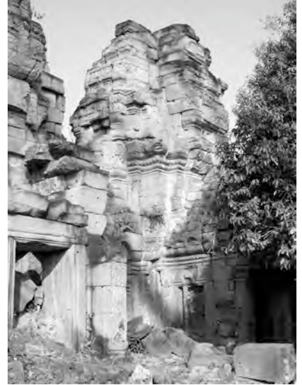
Ph. 440 : Tour-sanctuaire latérale Nord BT.3
