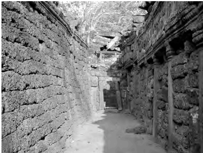
Ph. 205 : Vue intérieure du tronçon Nord de la galerie-enceinte BK.32 de la seconde enceinte
