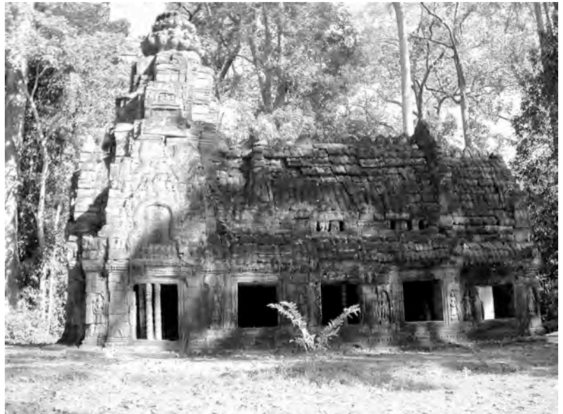
Ph. 57 : Face Sud du gîte d'étape du Preah Khan d'Angkor
