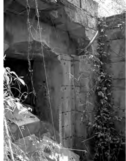
Ph. 945 : Aspect des murs de la cella du sanctuaire central du grand Preah Khan
