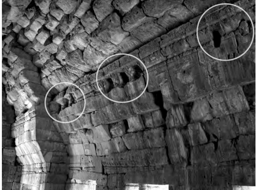
Ph. 56 : Système d'aérations vu de l'intérieur dans le mur Sud du Preah Khan d'Angkor
