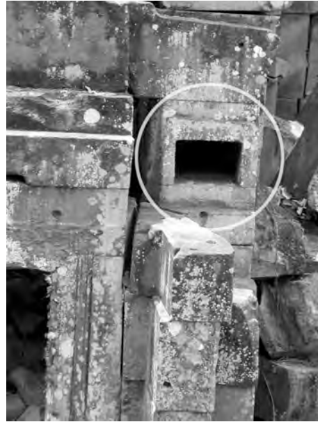
Ph. 975 : Logement de poutre dans la maçonnerie de l'avant-corps oriental du pavillon axial PKKS.5 de la première enceinte du complexe central du Preah Khan de Kompong Svay
