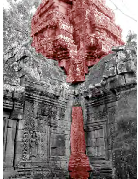
Ph. 879 : Adjonction d'un pilastre monologique à l'angle Nord-Ouest du pavillon d'angle Sud-Ouest BY.20
