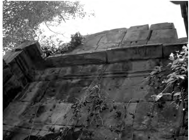
Ph. 947 : Aspect des murs de la cella du sanctuaire central du grand Preah Khan
