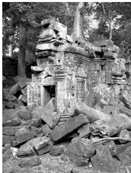
Ph. 125 : Tour TP.50 (vue du trois-quarts Nord-Est)
