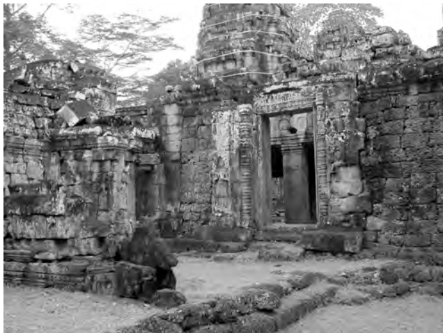
Ph. 207 : Entrée latérale orientale de la galerie-enceinte BK.32 au Nord du pavillon d'entrée Est BK.30 de la seconde enceinte
