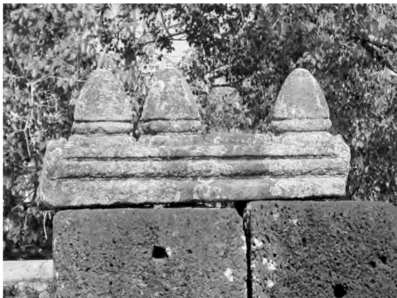
Ph. 647 : Faîtage de la deuxième enceinte de Vat Nokor
