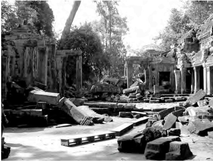
Ph. 118 : Moitié Nord de la terrasse TP.105 située entre la " salle aux danseuses " TP.109 et le pavillon d'entrée oriental TP.81 de la troisième enceinte de Ta Prohm
