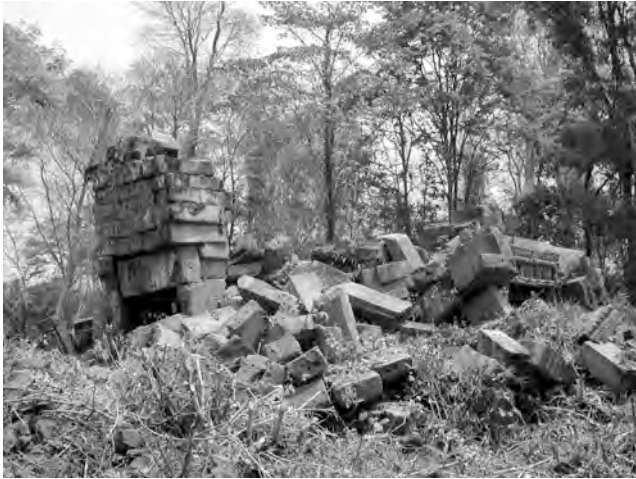
Ph. 554 : Vestiges de la tour-sanctuaire PKKS.19
