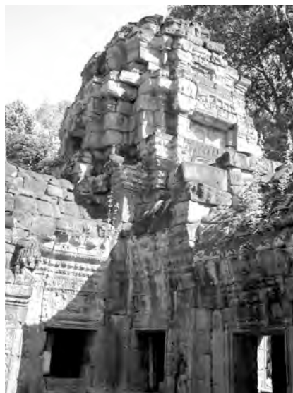
Ph. 306 : Pavillon d'entrée oriental PK.124 du “ cloître ” Nord
