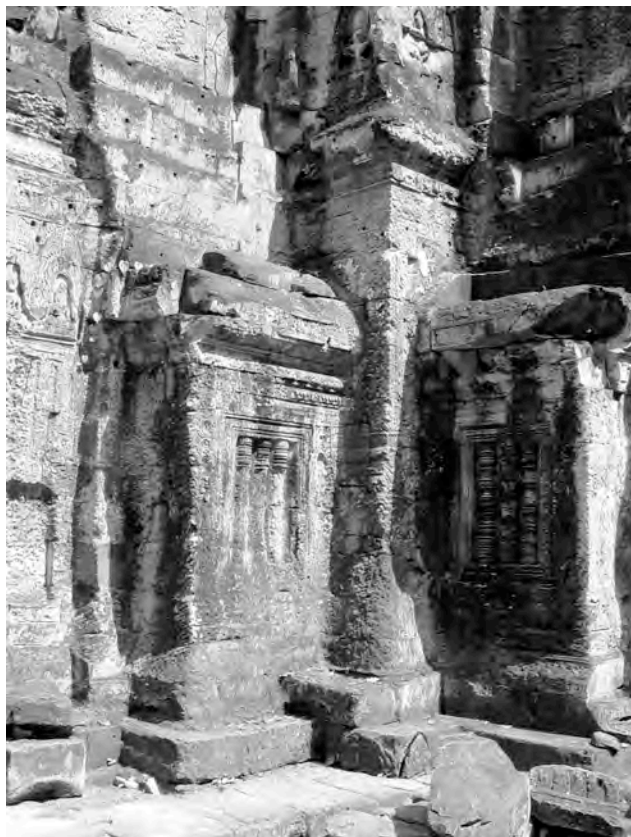
Ph. 342 : Fausses loggias d'angle du sanctuaire central PK.1
