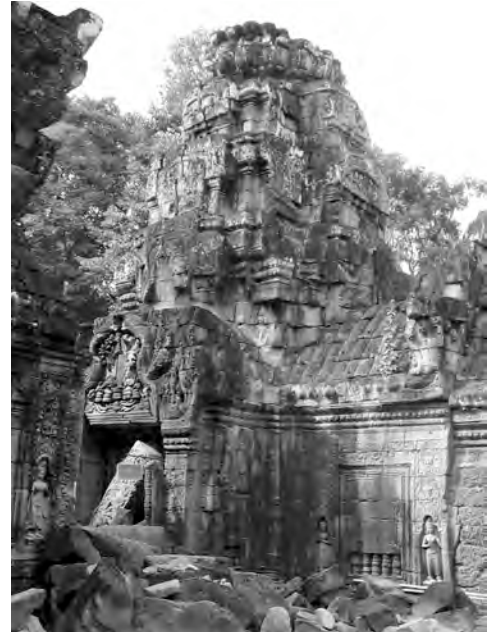
Ph. 420 : Pavillon d'entrée Nord TS.18 de la première enceinte de Ta Som (vue de l'angle Sud-Est)
