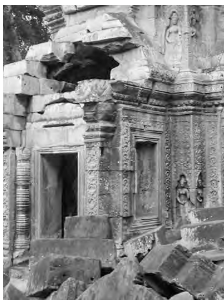
Ph. 703 : Fausse-fenêtre à balustres de la face Nord de l'avant-corps Est de la tour TP.49
