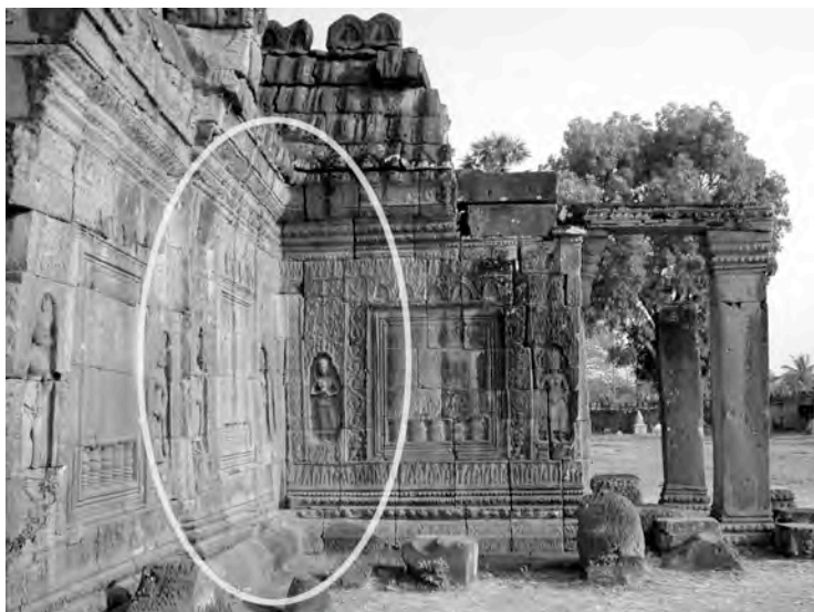
Ph. 932 : Angle Sud-Est du pavillon occidental VN.47 de la quatrième enceinte de Vat Nokor
