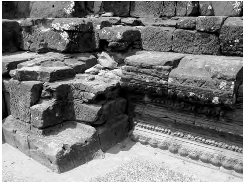
Ph. 606 : Raccord entre le soubassement du Prang Hin Daeng (à gauche) et la plateforme (à droite) faisant liaison avec le Ho Brahma
