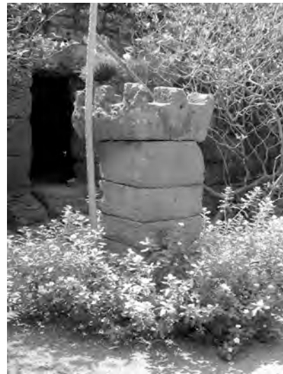
Ph. 514 : Pilier isolé Sud-Est TPB.3
