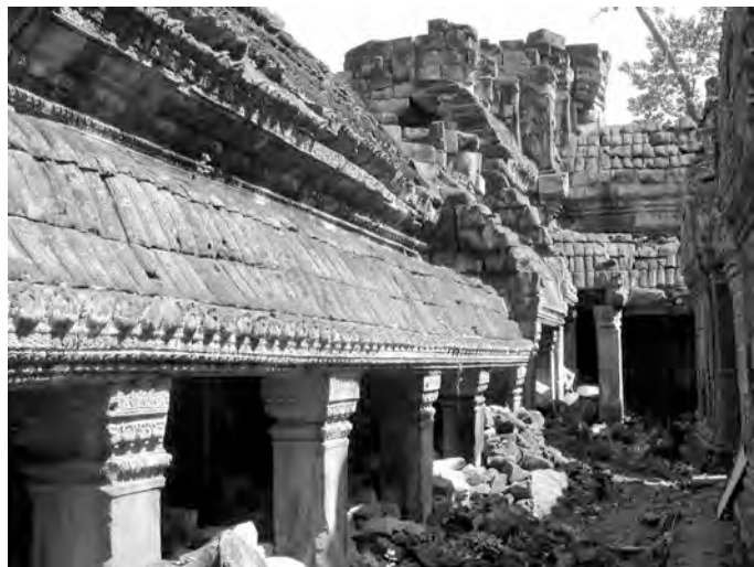
Ph. 336 : Galerie Nord PK.48 se raccordant à l'avant-corps occidental du pavillon d'entrée Nord PK.49 de la première enceinte
