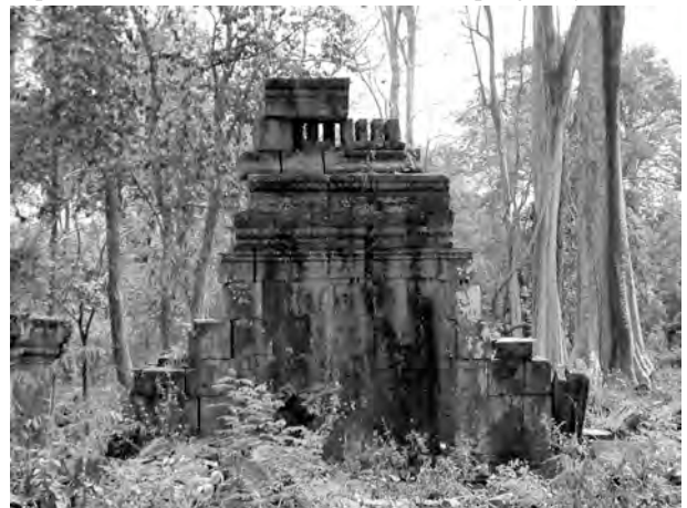
Ph. 561 : Vestiges de la "bibliothèque" Sud-Est PKKS.3
