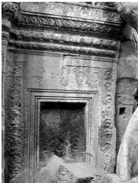
Ph. 705 : Fausse-fenêtre à balustres de la face Sud de l'avant-corps Est de la tour TP.56
