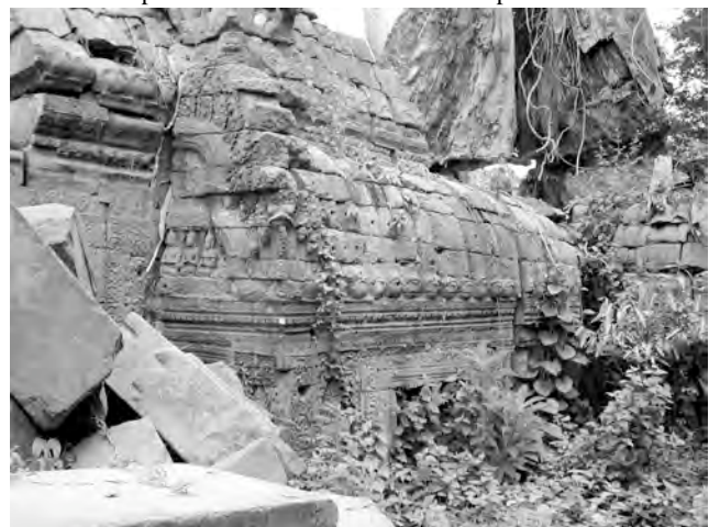
Ph. 332 : "Salle-passage" Sud PK.58 connectée à l'avant-corps oriental du pavillon d'angle Sud-Est PK.39 de la première enceinte du Preah Khan d'Angkor
