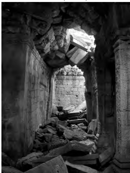
Ph. 159 : Galerie Sud-Est de la deuxième enceinte de Ta Prohm contenant l'entrée de la " salle-passage " TP.34 (à droite)
