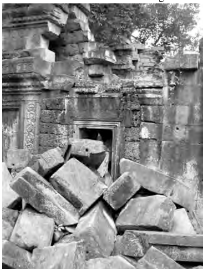
Ph. 130 : “ Salle-passage ” TP.59 entre la tour TP.47 (à gauche) et le pavillon d'entrée oriental TP.81 de la troisième enceinte de Ta Prohm (à droite)
