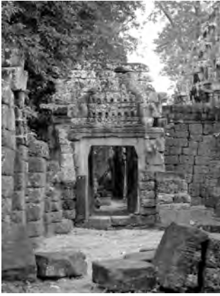
Ph. 209 : Porche de l'entrée Sud-Est de la galerie-enceinte BK.32
