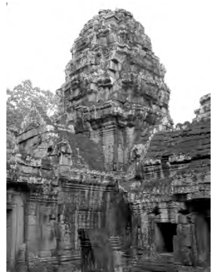
Ph. 221 : Pavillon d'entrée Ouest BK.22 de la première enceinte du temple
