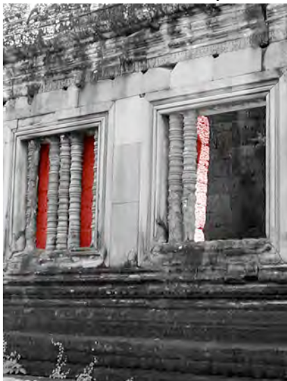
Ph. 677 : Fausses-fenêtres au Khleung Nord
