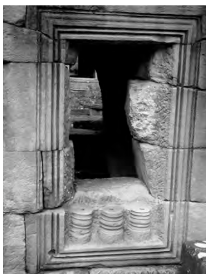
Ph. 696 : Fausse-fenêtre de type 2 du "cloître" Ouest du Preah Khan d'Angkor à balustres mixtes
