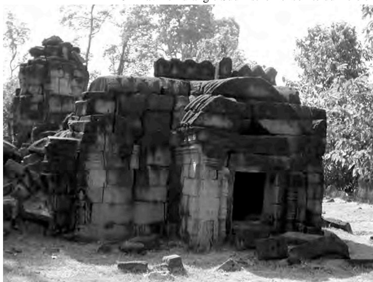
Ph. 53 : Pavillon d'angle Nord-Est de la première enceinte de Ta Som
