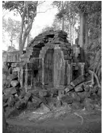
Ph. 121 : Pavillon d'angle Sud-Ouest TP.89 de la troisième enceinte de Ta Prohm
