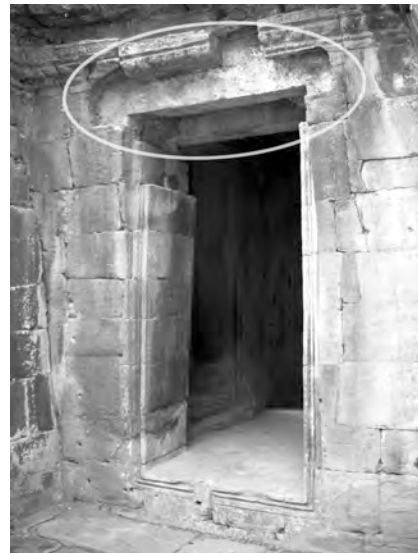
Ph. 620 : Exemple de poutre en béton mise en place dans des logements de poutres en bois d'une porte ouverte dans un mur à la galerie du second étage du Bayon
