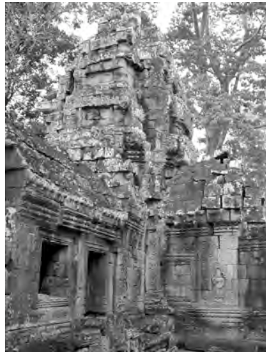
Ph. 226 : Pavillon d'angle Sud-Ouest BK.20 de la première enceinte du temple
