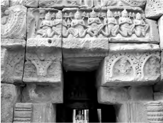
Ph. 930 : Linteau de l'avant-corps Nord du pavillon axial Nord VN.20 de la première enceinte de Vat Nokor
