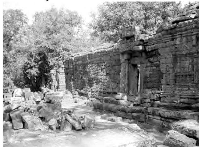
Ph. 208 : Entrée latérale occidentale de la galerie-enceinte BK.32 au Nord du pavillon d'entrée Ouest BK.33 de la seconde enceinte
