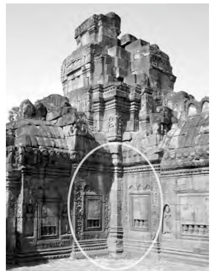
Ph. 933 : Angle Nord-Ouest du pavillon axial Nord VN.20 de la première enceinte de Vat Nokor
