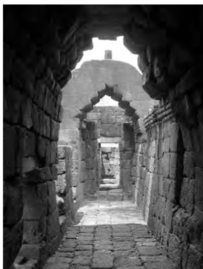
Ph. 570 : Tronçon de galerie de la première enceinte de Muang Sing
