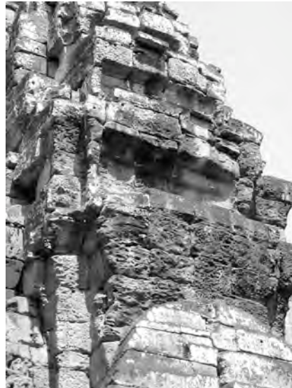
Ph. 961 : Face Est de la superstructure du sanctuaire central du Banteay Kdei
