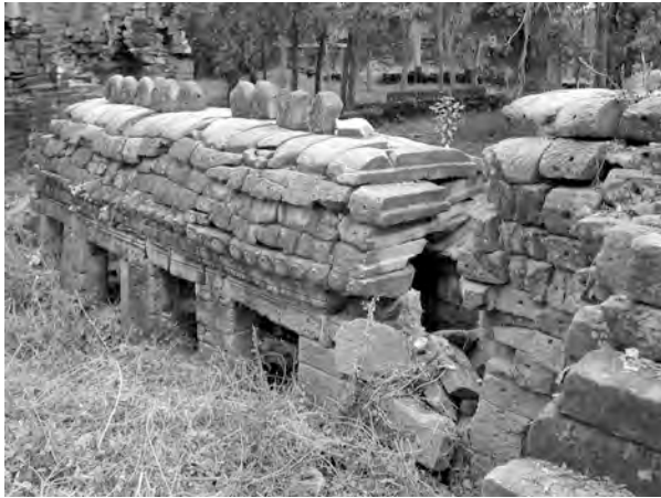
Ph. 464 : Tronçon de galerie Sud BC.129 de l'enceinte du second complexe occidental
