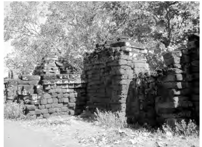
Ph. 494 : Face Sud de l'excroissance formée par la chapelle Sud VN.26 de la deuxième enceinte de Vat Nokor
