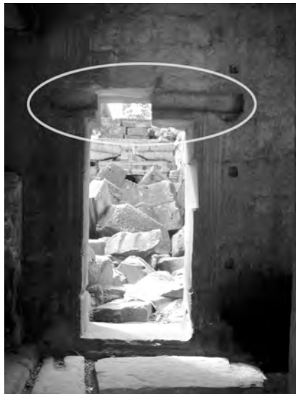
Ph. 619 : Exemple de logement de poutre intérieur d'une porte ouverte dans un mur à la troisième enceinte de Ta Prohm
