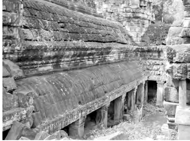
Ph. 334 : Demi-galerie courant le long de la face intérieure du tronçon de galerie Sud PK.40 de la première enceinte
