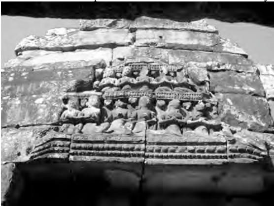
Ph. 815 : Fronton du premier avant-corps Est de la tour BY.16 du Bayon
