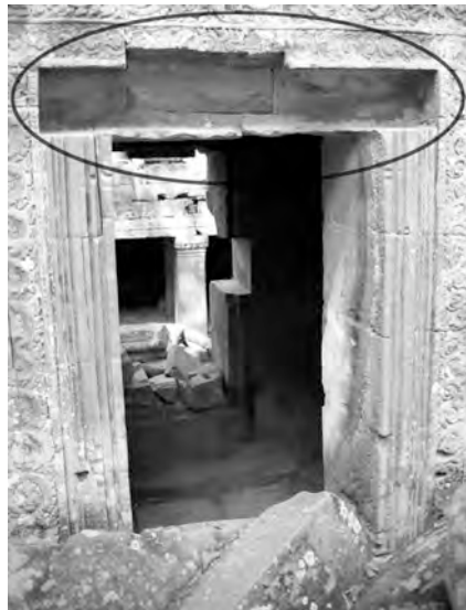
Ph. 618 : Exemple de logement de poutre extérieur d'une fenêtre ouverte dans une fausse-fenêtre à la première enceinte de Ta Prohm
