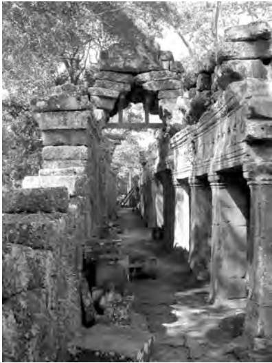
Ph. 203 : Vestiges de la nef centrale de la galerie-enceinte BK.32 de la seconde enceinte
