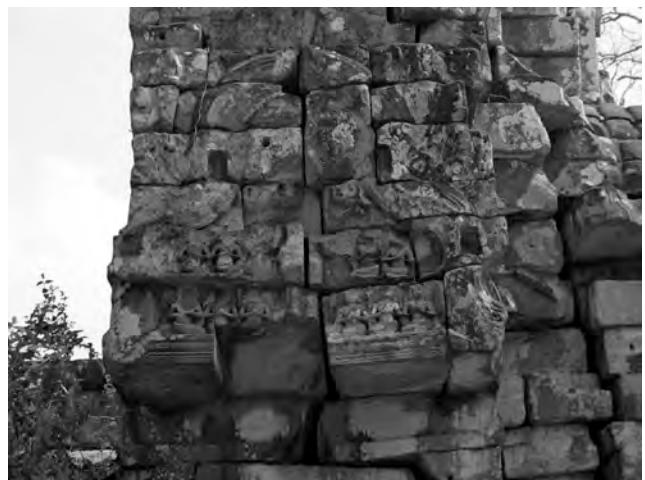
Ph. 543 : Fronton de l'entrée occidentale du gîte d'étape PKKS.76 du Preah Khan de Kompong Svay
