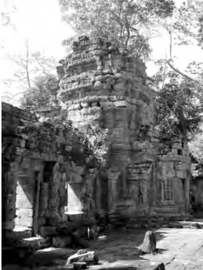
Ph. 301 : Sanctuaire central PK.120 du “ cloître ” Nord de la troisième enceinte du temple
