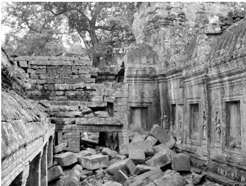
Ph. 158 : Connexion entre la deuxième enceinte de Ta Prohm (à gauche) et le pavillon d'entrée Nord TP.23 (à droite) de la première enceinte de Ta Prohm
