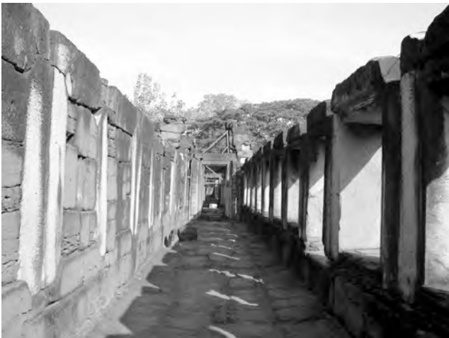
Ph. 597 : Exemple de tronçon de galerie de la première enceinte de Phimai
