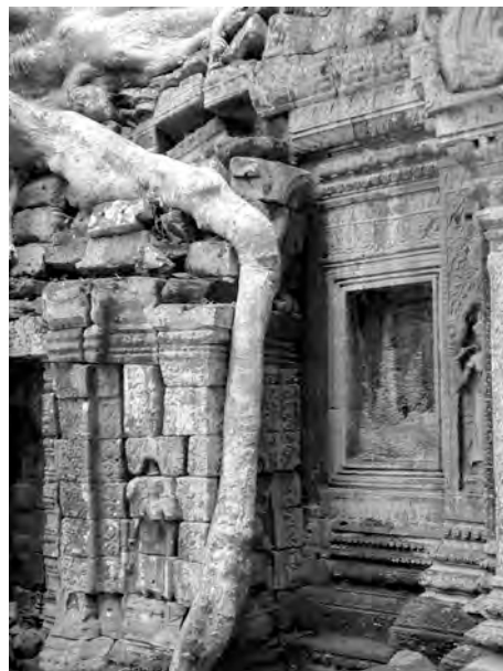
Ph. 706 : Fausse-fenêtre à balustres de la face Nord de l'avant-corps Est de la tour TP.56
