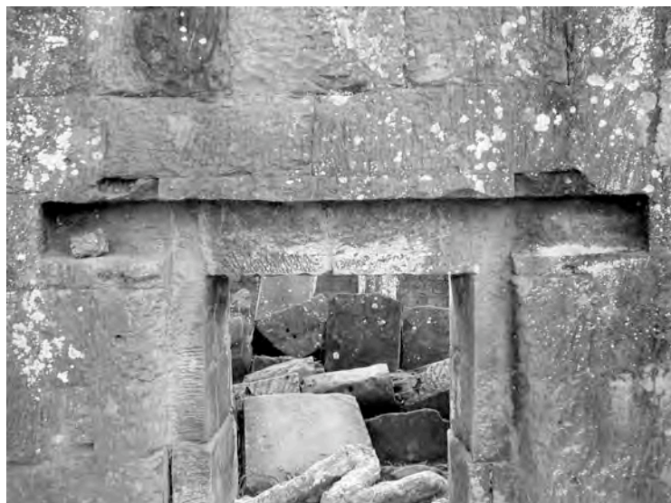
Ph. 786 : Exemple d'ouverture d'une porte dans le mur (face extérieure) de la galerie TP.98 de la troisième enceinte de Ta Prohm
