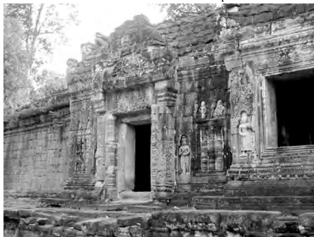
Ph. 300 : Entrée latérale PK.158 du pavillon d'entrée occidentale PK.157 de l'enceinte du temple
