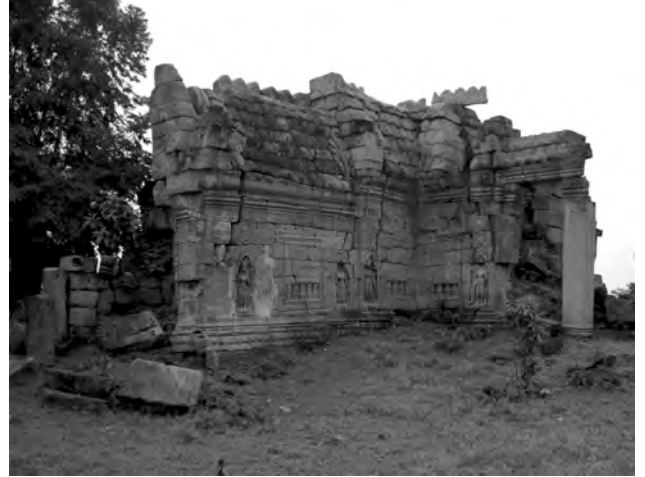
Ph. 429 : Face occidentale du pavillon d'entrée oriental BT.16 de la deuxième enceinte de Banteay Thom
