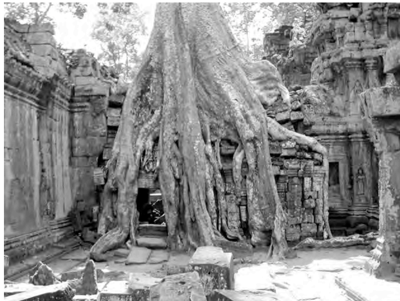
Ph. 133 : "salle-passage" TP.80 entre la tour TP.57 (à droite) et l'entrée latérale Nord TP.103 de la troisième enceinte de Ta Prohm (à gauche)
