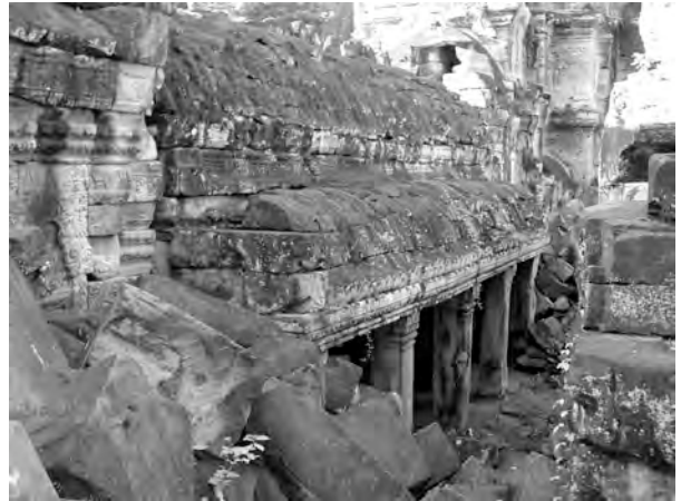
Ph. 338 : Face orientale de la galerie PK.11 entre le sanctuaire central et le pavillon d'entrée Sud PK.41 de la première enceinte
