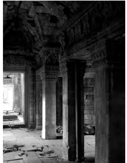
Ph. 330 : Tronçon axial de la galerie oriental PK.54 de la deuxième enceinte connecté à la tour PK.63 et au pavillon d'entrée Est PK.36 de la première enceinte
