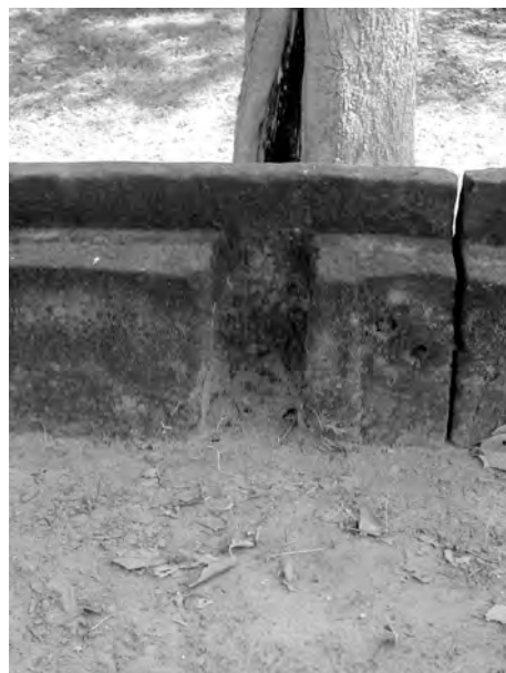
Ph. 876 : Détail de la "margelle" en grès du pourtour de la première plateforme du Preah Pithu X
