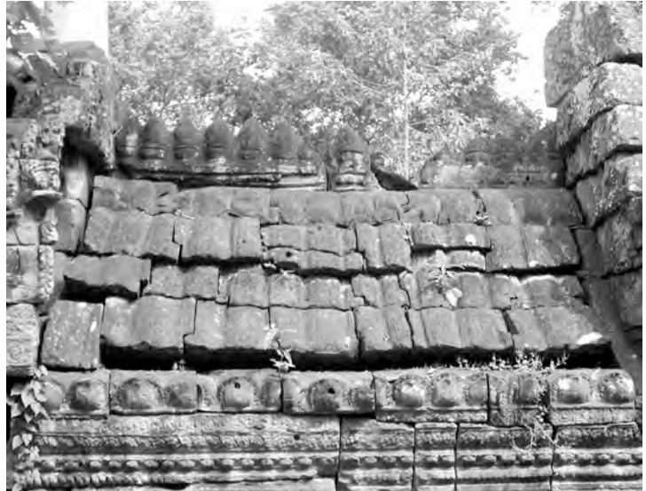
Ph. 635 : Faitage de type 3 monolithique à Ta Nei
