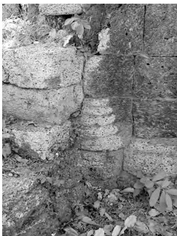
Ph. 918 : Vestige de pilastre d'angle au pavillon d'angle Nord-Est TPB.24 de la première enceinte de Ta Prohm de Bati
