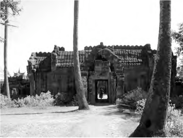
Ph. 489 : Face orientale du pavillon d'entrée Ouest (VN.41) de la troisième enceinte de Vat Nokor
