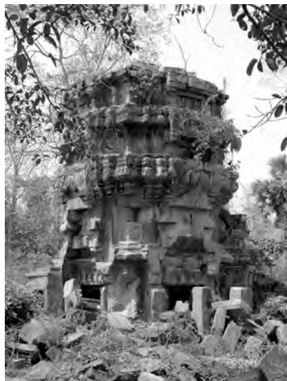
Ph. 563 : Pavillon d'entrée Ouest PKKS.10 de la première enceinte du Preah Khan de Kompong Svay
