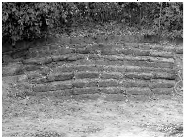
Ph. 250 : Gradins de la berge Nord du bassin Nord TN.34
