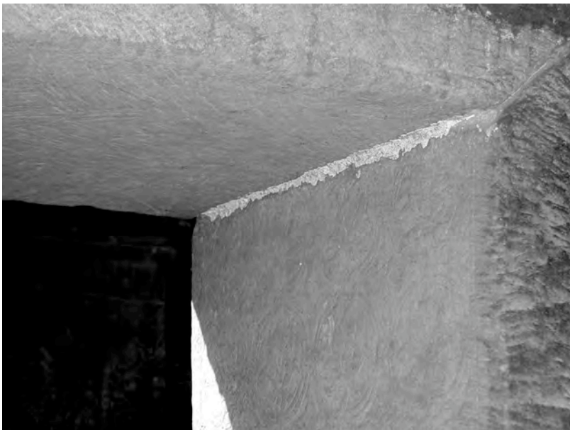
Ph. 725 : Vestige d'enduit dans la porte Sud de la tour TP.57 de Ta Prohm
