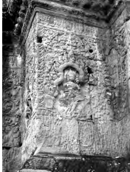
Ph. 958 : Apsara (?) partiellement bûchée au premier faux-étage du sanctuaire central du Preah Khan d'Angkor
