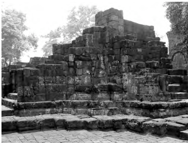
Ph. 574 : Vestiges du sanctuaire central de Muang Sing
