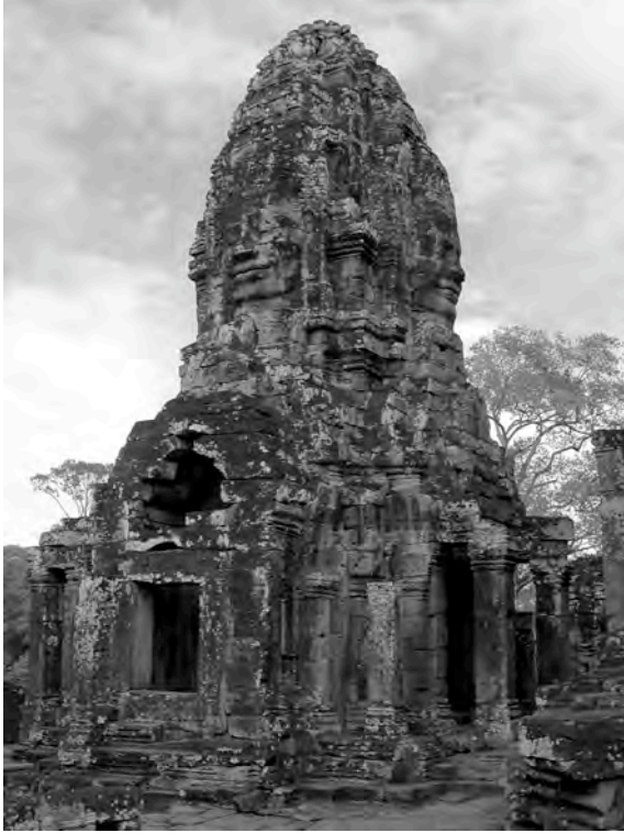
Ph. 86 : Tour n° 20 à petites loggias angle du troisième étage du Bayon
