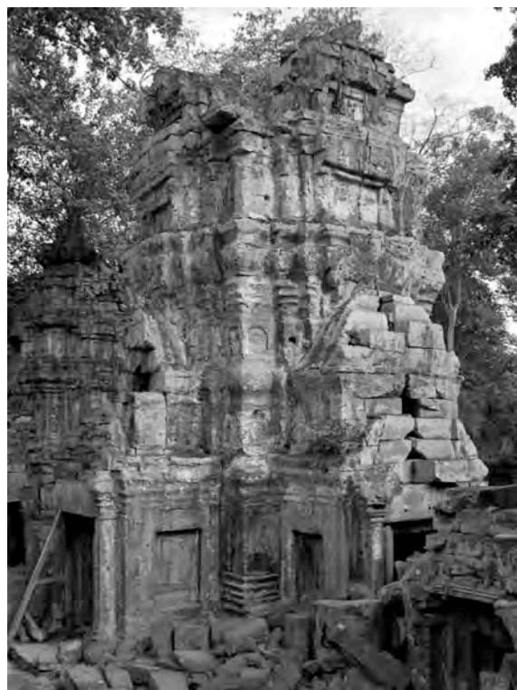
Ph. 164 : Sanctuaire central TP.1 de Ta Prohm (Vue de l'angle Nord-Ouest)
