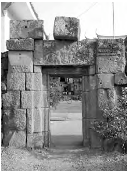
Ph. 487 : Porte Sud (VN.39) de la troisième enceinte de Vat Nokor
