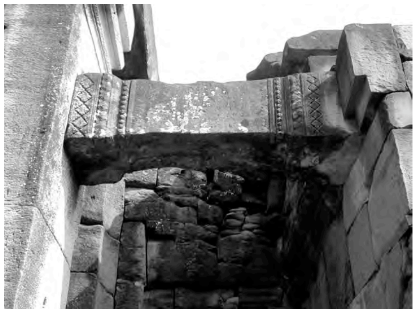
Ph. 792 : Détail d'un étrésillon au pavillon axial Sud de la deuxième enceinte de Phimai
