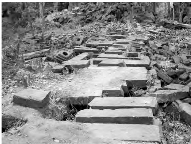
Ph. 544 : Vestiges de la chaussée sur colonnes PKKS.59
