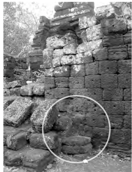
Ph. 922 : Angle Nord-Ouest du pavillon d’angle VN.22
