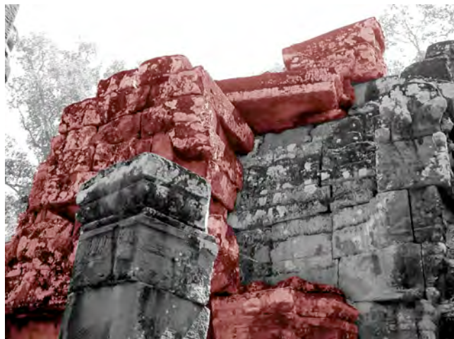
Ph. 882 : Adjonctions de contreforts et d’une tour à la “bibliothèque” Sud BK.7
