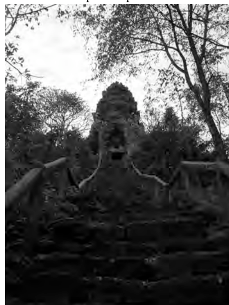
Ph. 520 : Pavillon d'entrée Est de Vat Banon
