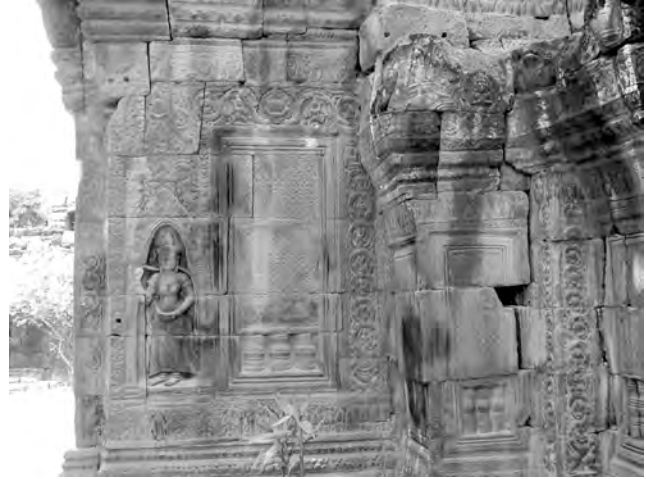
Ph. 85 : Fausses loggias d'angle du sanctuaire central de Ta Prohm de Bati
