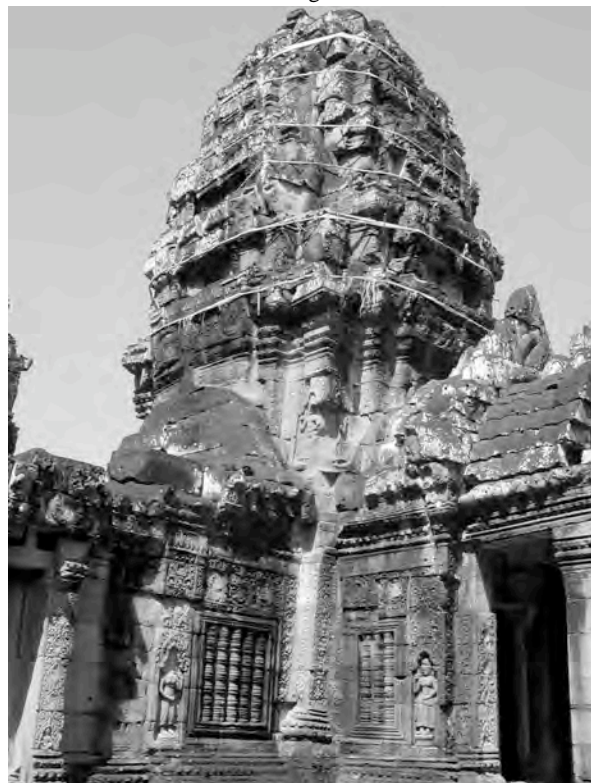
Ph. 881 : Pavillon axial BK.14 avec tour en superstructure originelle
