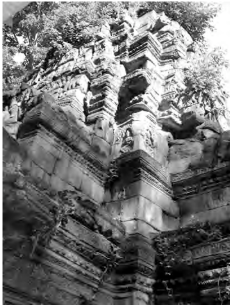
Ph. 139 : Tour PK.40 (vue de l’angle Sud- Ouest)
