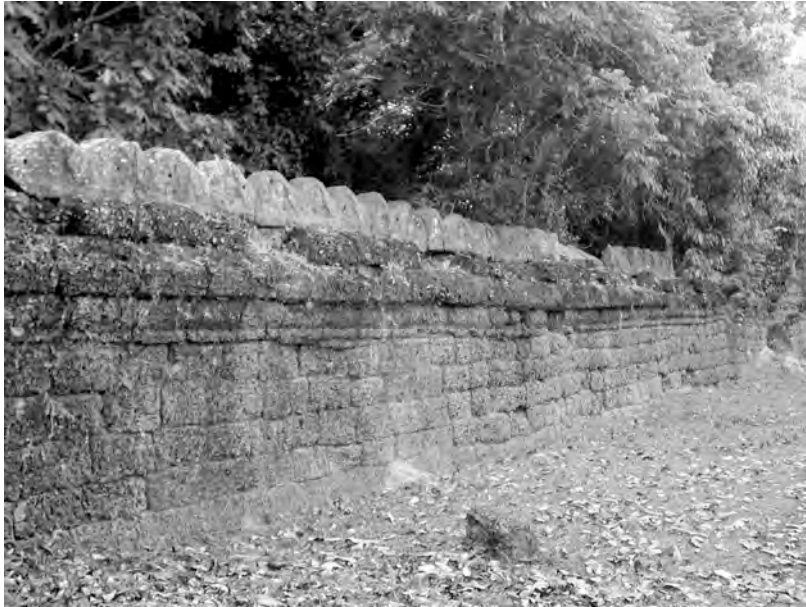
Ph. 409 : Mur de l'enceinte de domaine de Ta Som
