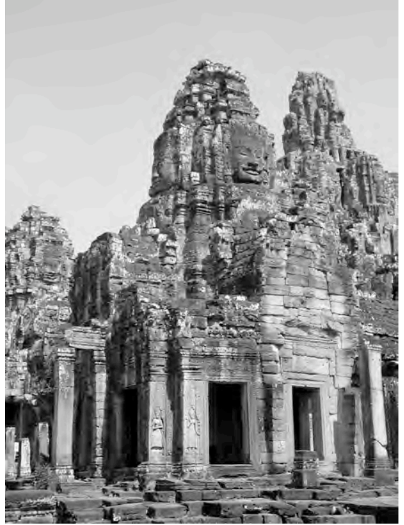
Ph. 87 : Tour d'angle Sud-Ouest n° 28 de la galerie-enceinte de la deuxième enceinte à grandes loggias d'angle
