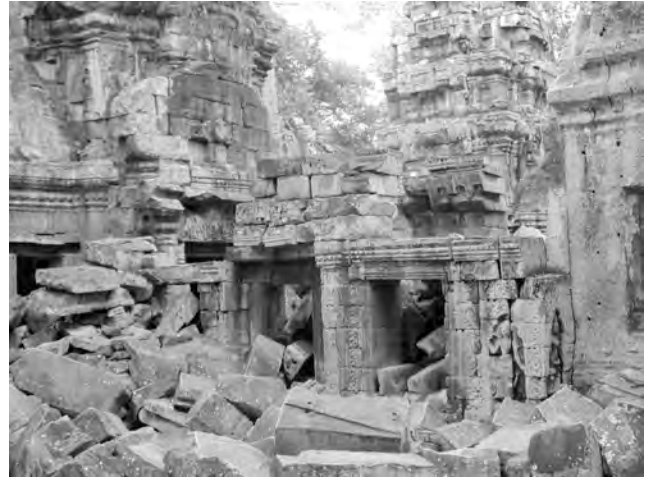
Ph. 166 : " Salle-passage " TP.5 entre le sanctuaire central TP.1 (à droite) et le pavillon d'entrée Ouest TP.17 (à gauche) de la première enceinte de Ta Prohm (vue de la face Sud)
