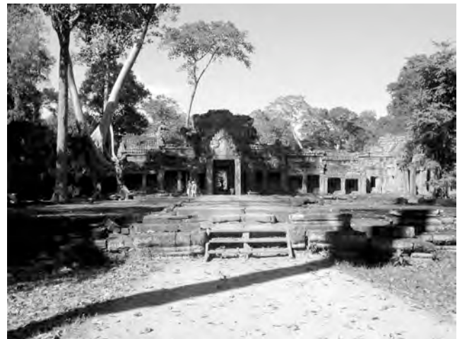
Ph. 286 : Terrasse PK.166 précédant le pavillon d'entrée oriental PK.148 de l'enceinte du temple
