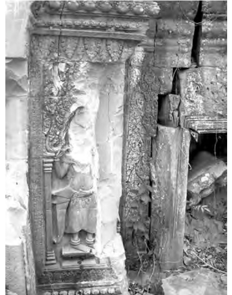
Ph. 567 : Stigmates au pavillon d'entrée Sud PKKS.10 de la première enceinte du Preah Khan de Kompong Svay résultants du pillage des devatâ
