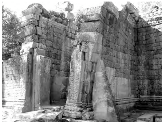
Ph. 101 : Bras oriental du pavillon d'entrée occidental TP.211 de la quatrième enceinte de Ta Prohm
