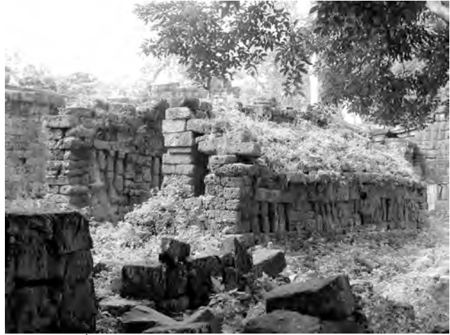
Ph. 326 : Édifice PK.141 précédant le pavillon d'angle Sud-Est PK.126 de l'enceinte du " cloître " Nord
