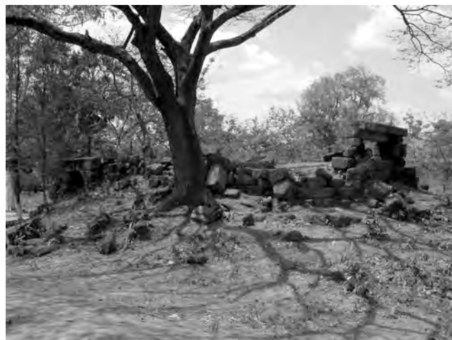
Ph. 841 : Angle Sud-Est du gîte d'étape de Ta Prohm de Bati
