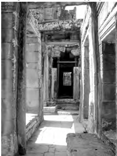
Ph. 239 : Bas-côté de la salle hypostyle BK.6 sur lequel ouvre la chapelle d'angle Nord-Est BK.5
