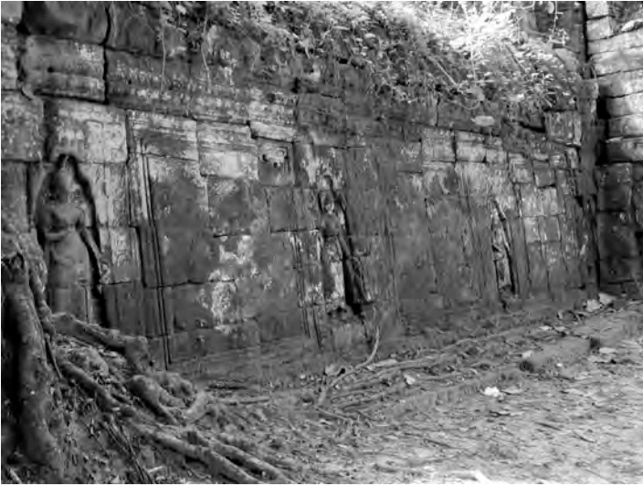
Ph.712 : Façade Nord du gîte d'étape de Ta Prohm
