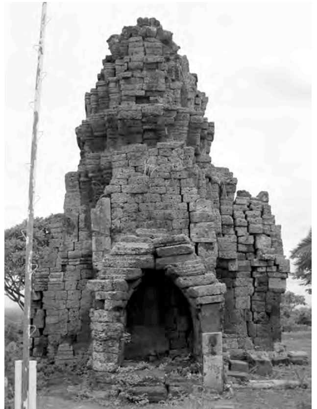
Ph. 522 : Face Nord du pavillon oriental de Vat Banon
