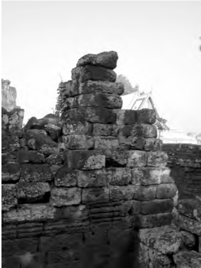
Ph. 923 : Vestiges de la superstructure du pavillon d'angle VN.22 vue du Nsud-Est
