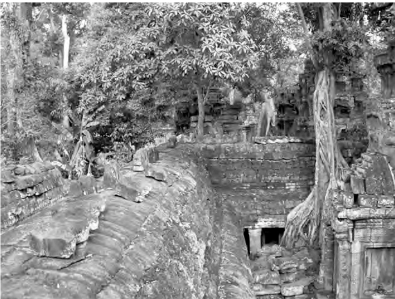
Ph. 155 : Couverture de la seconde enceinte de Ta Prohm
