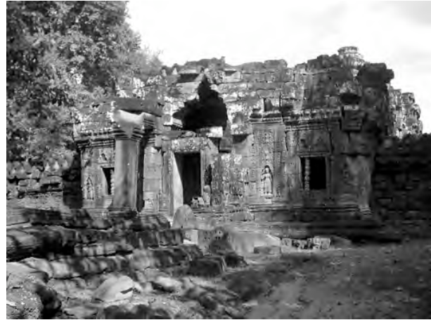
Ph. 414 : Pavillon d'entrée Ouest TS.23 de la seconde enceinte de Ta Som (vue de l'angle Sud-Ouest)
