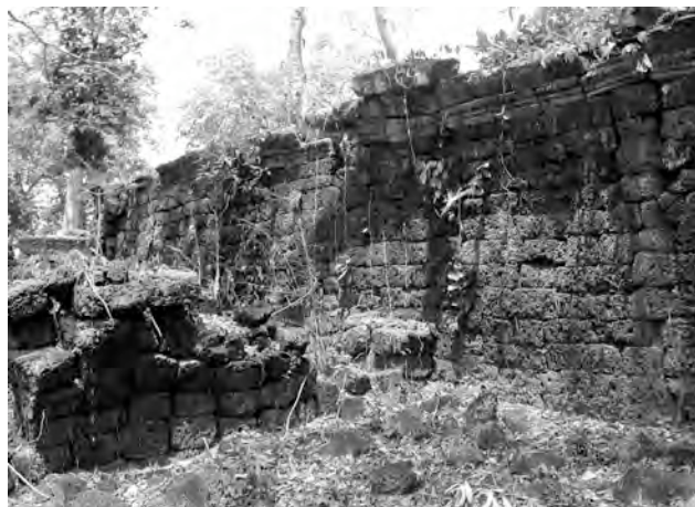
Ph. 467 : Mur de la seconde enceinte BC.86 (à droite) s'appuyant sur la galerie-enceinte du complexe Nord (à gauche)
