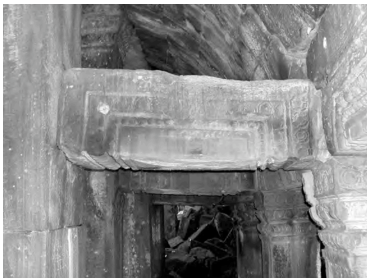
Ph. 796 : Étrésillons à la "salle aux danseuses" TP.109 de Ta Prohm
