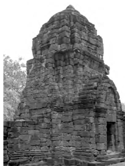
Ph. 572 : Pavillon d'entrée occidental MS.12 de la première enceinte de Muang Sing
