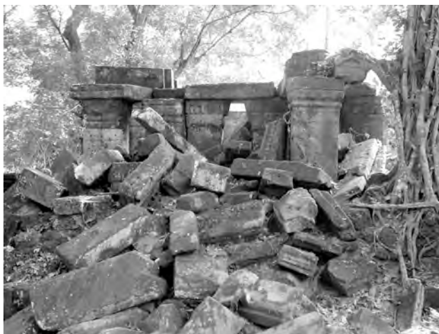
Ph. 107 : Vestiges de l'"édifice à colonnes" TP.116
