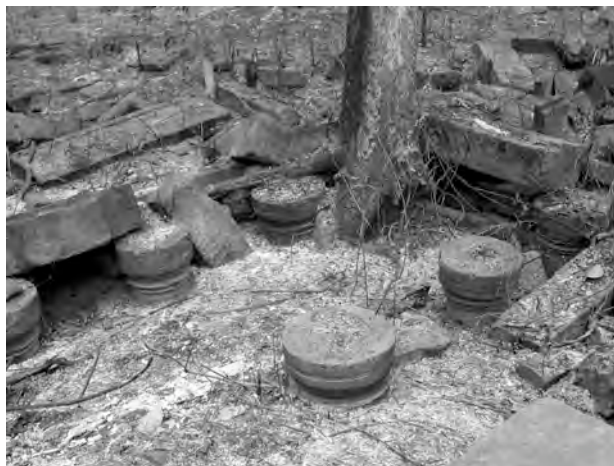
Ph. 545 : Vestiges de la chaussée sur colonnes PKKS.59
