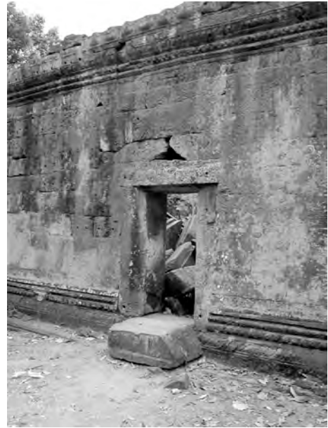
Ph. 113 : Porte du tronçon de la galerie TP.86 de la troisième enceinte de Ta Prohm
