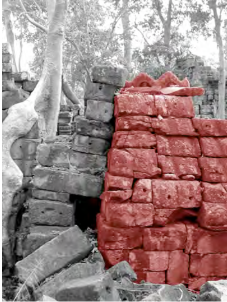
Ph. 616 : Exemple d'analyse structurelle facilitée par la ruine partielle d'édifices au complexe oriental de Banteay Chmar
