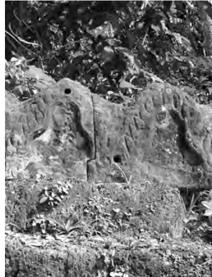
Ph. 638 : Assemblage de deux blocs de faîtage de type 4 à la deuxième enceinte de Ta Som
