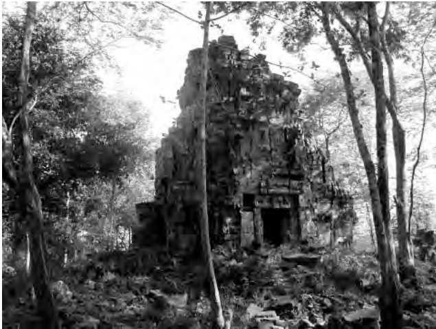
Ph. 529 : Vue générale du sanctuaire central du Preah Thkol (photo de Naoki Hatano)
