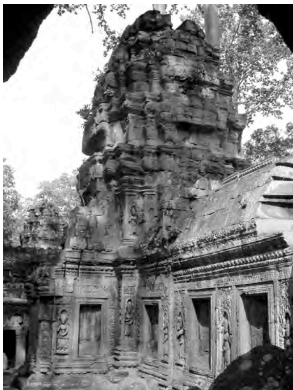
Ph. 163 : Pavillon d’angle Sud-Ouest TP.14 de la première enceinte de Ta Prohm (vue de l’angle Sud-Est)
