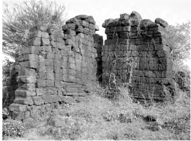
Ph. 929 : Angle Sud-Est de la porte de domaine Sud VN.46 de Vat Nokor
