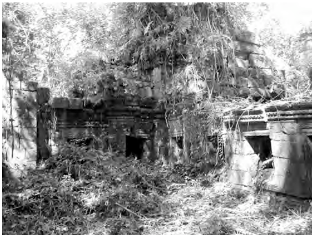
Ph. 307 : Connexion entre le bras Sud du pavillon d'entrée Sud PK.81 du “ cloître ” Sud et l'avant-corps Nord du pavillon d'entrée Sud PK.154 de l'enceinte du temple (à gauche)
