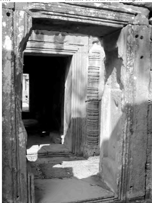
Ph. 760 : Piédroit Nord de la porte de l'avant-corps oriental du pavillon axial Est PK.140 du complexe Nord du Preah Khan d'Angkor
