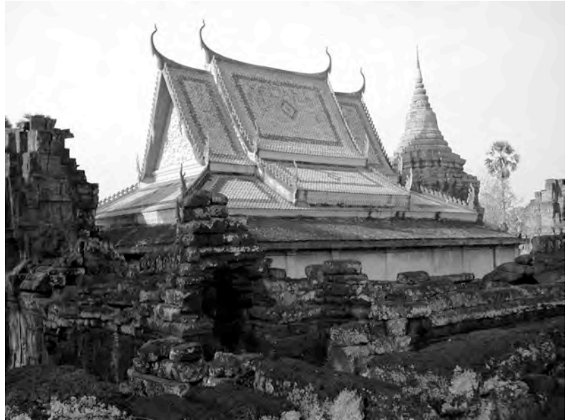
Ph. 502 : Toiture du vihara moderne entre le sanctuaire central et le pavillon d'entrée oriental de la première enceinte de Vat Nokor
