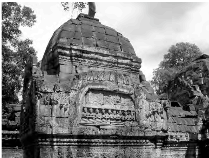
Ph. 350 : Superstructure de la chapelle Nord PK.26
