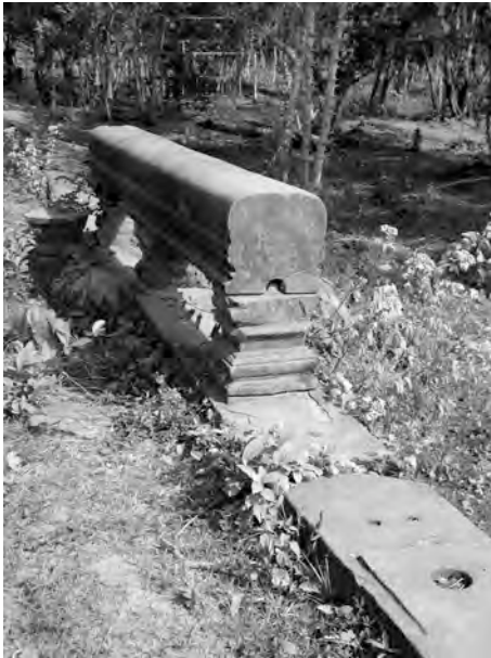
Ph. 866 : Balustrade de la chaussée de l'entrée Sud du complexe de Beng Mealea
