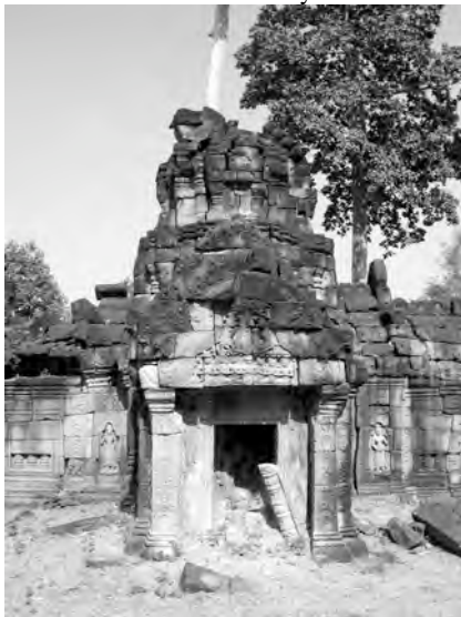
Ph. 386 : Pavillon d'entrée occidental BP.11 de la première enceinte de Banteay Kdei
