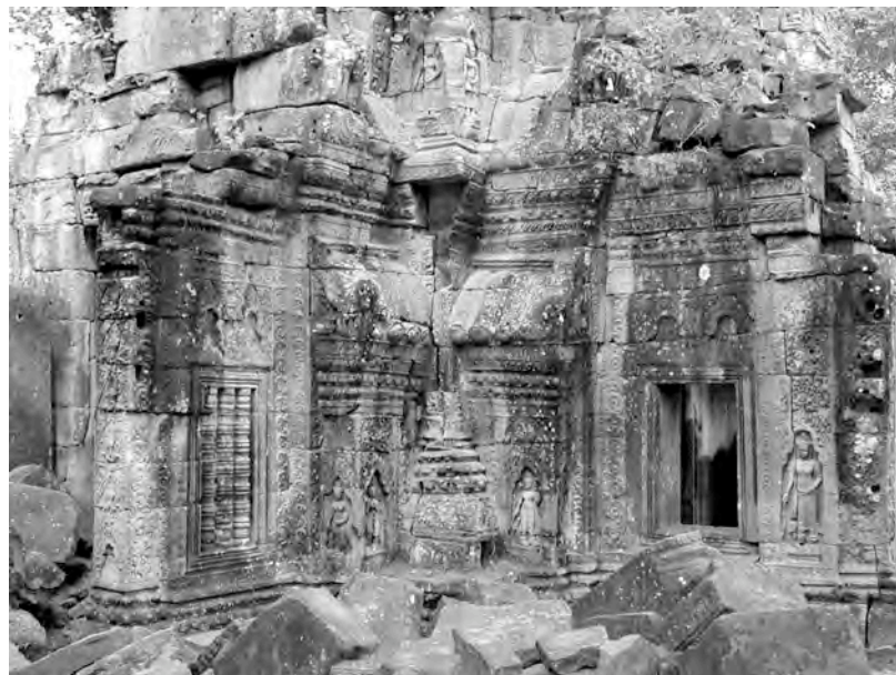
Ph. 268 : Fausses loggias de l'angle Sud-Est du sanctuaire central TN.1 de Ta Nei
