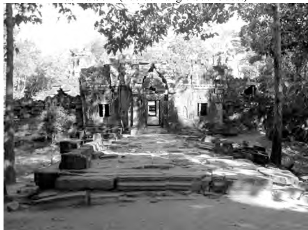
Ph. 416 : Vestiges de la terrasse cruciforme occidentale TS.26
