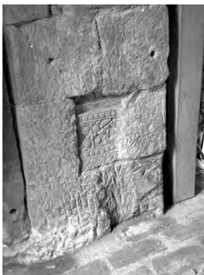
Ph. 910 : Exemple de réemploi à l'intérieur du sanctuaire central de Vat Banon
