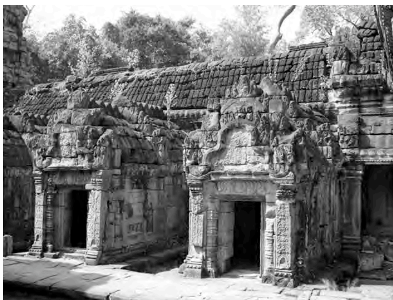
Ph. 351 : Chapelle Sud PK.16 et PK.17 (de gauche à droite) s'appuyant sur la galerie PK.44 de la première enceinte du Preah Khan d'Angkor
