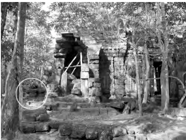
Ph. 251 : Face orientale du pavillon d'angle Sud-Est TN.7 de la première enceinte connecté aux vestiges du mur de la seconde enceinte (à gauche)
