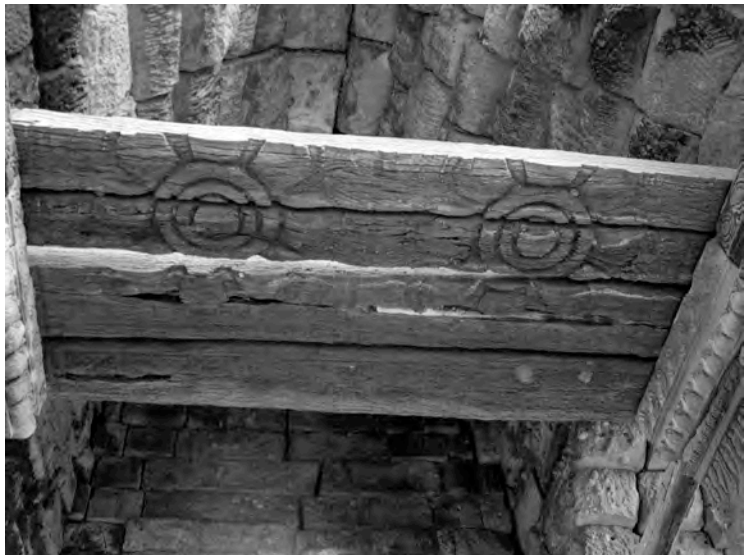
Ph. 989 : Éléments en bois de plafond à la tour occidentale de Banteay Tiep
