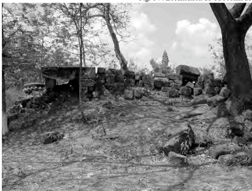
Ph. 505 : Vestige du gîte d'étape du Ta Prohm de Bati
