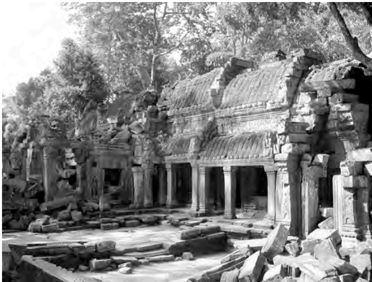
Ph. 120 : Demi-galerie courant le long de la face orientale du pavillon d'entrée orientale TP.81 et de son avant-corps Nord TP.104 de la troisième enceinte de Ta Prohm
