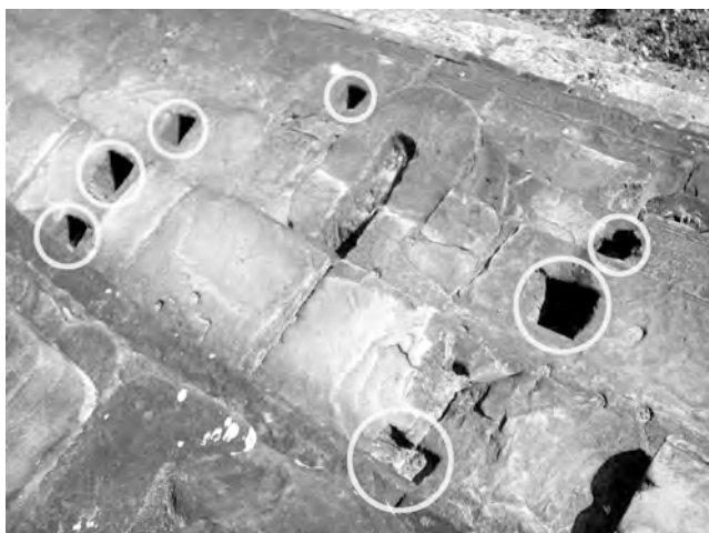
Ph. 864 : Mortaises de part et d'autre de la vasque de l'édifice du bassin secondaire Nord
