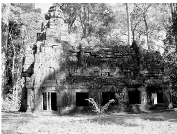
Ph. 281 : Face Sud du gîte d'étape PK.170
