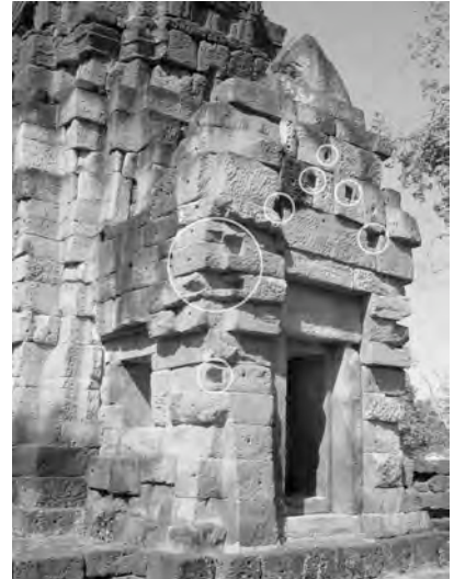
Ph. 838 : Avant-corps Est du sanctuaire de Ta Muen Toch (Thaïlande)
