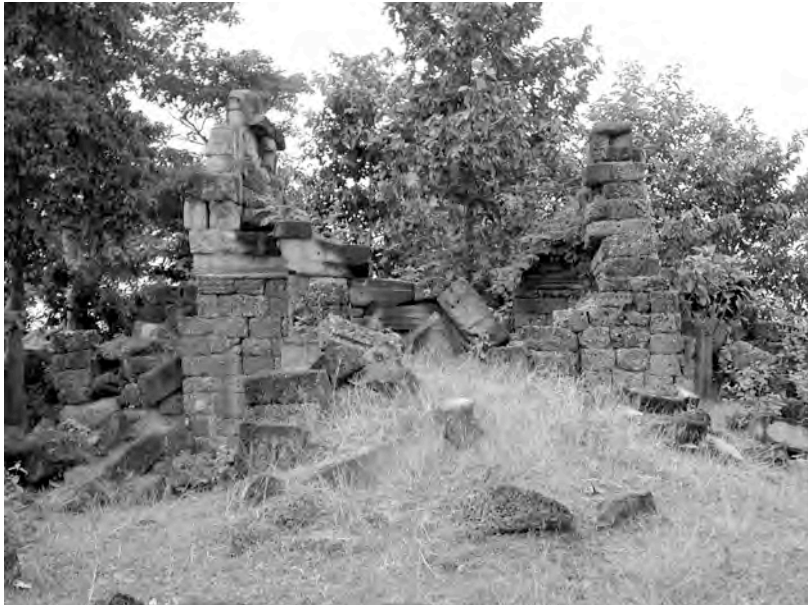
Ph. 443 : Vestiges du pavillon d'entrée oriental PPP.3 de l'enceinte de Prasat Prei Prasat
