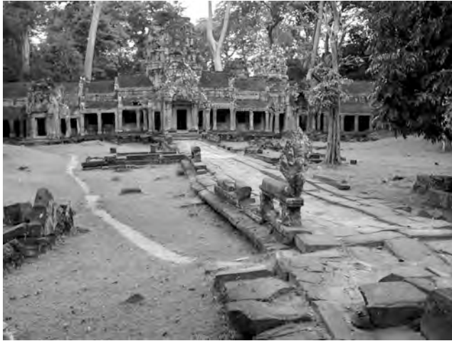
Ph. 116 : Chaussée TP.107 entre le pavillon d'entrée Ouest TP.211 de la quatrième enceinte et le pavillon Ouest TP.93 de la troisième enceinte de Ta Prohm
