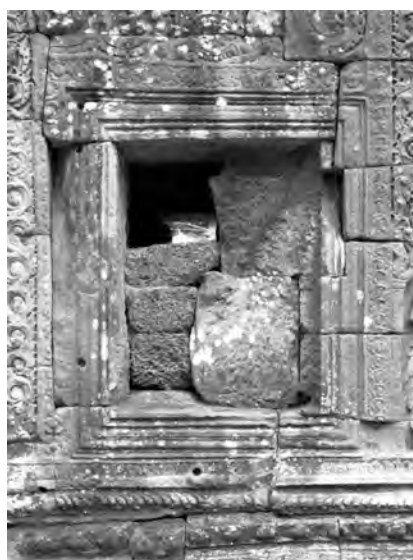
Ph. 809 : Fausse-fenêtre de l’enceinte du complexe Ouest du Preah Khan d’Angkor
