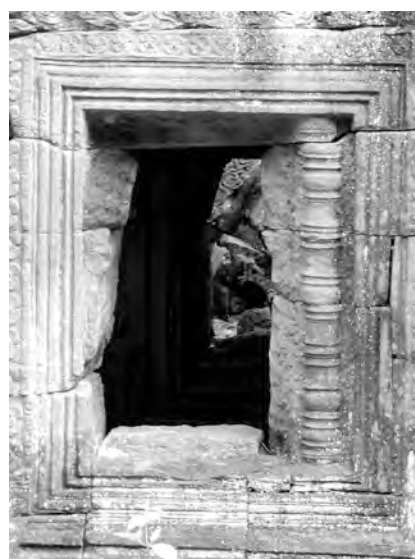
Ph. 697 : Fausse-fenêtre de type 2 du "cloître" Ouest du Preah Khan d'Angkor comportant un faux-balustre
