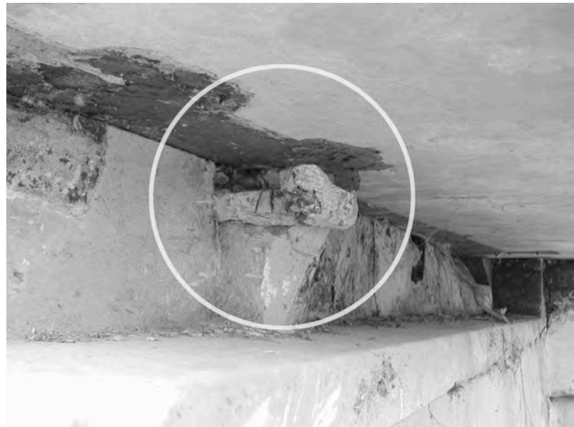
Ph. 977 : Crampon dans un vrai linteau toujours en place à l'avant-corps Nord du pavillon axial Sud PKKS.8 de la première enceinte du complexe central du Preah Khan de Kompong Svay (linteau décoratif à terre)
