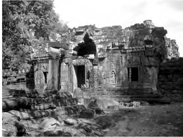
Ph. 414 : Pavillon d'entrée Ouest TS.23 de la seconde enceinte de Ta Som (vue de l'angle Sud-Ouest)
