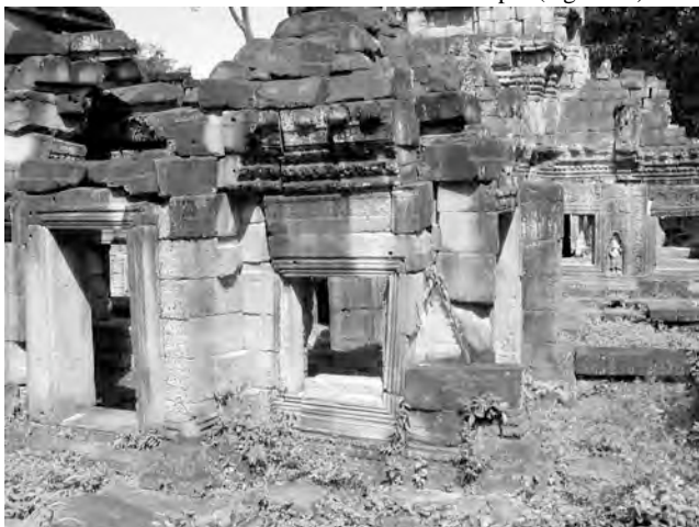
Ph. 309 : Vestiges du pavillon d'angle Sud-Est PK.126 de l'enceinte du “ cloître ” Nord
