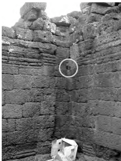
Ph. 920 : Angle Sud-Ouest du pavillon d’angle VN.22
