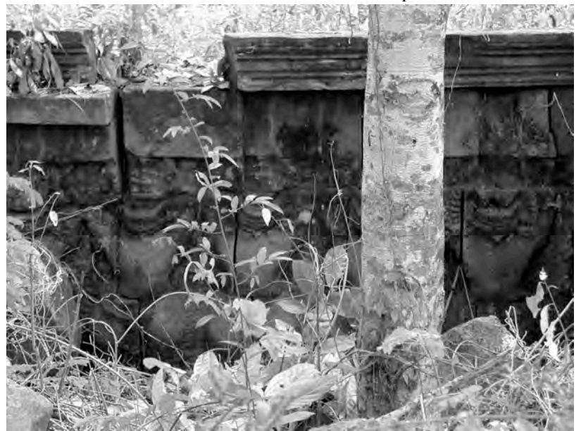
Ph. 553 : Mur de soutènement de la courette Nord-Est de la plateforme PKKS.24
