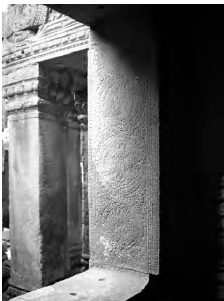
Ph. 719 : Fenêtre Sud de l'avant-corps Est de PK.36 du Preah Khan d'Angkor
