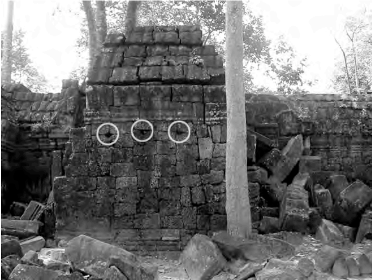
Ph. 68 : Trous d'aération dans le mur Nord de la " bibliothèque " Sud de la première enceinte de Ta Nei
