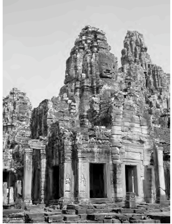
Ph. 87 : Tour d'angle Sud-Ouest n° 28 de la galerie-enceinte de la deuxième enceinte à grandes loggias d'angle
