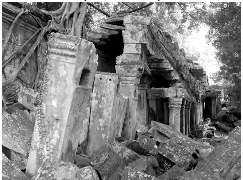
Ph. 111 : Vestiges du bas-côté de la nef centrale du tronçon de la galerie TP.88 de la troisième enceinte de Ta Prohm
