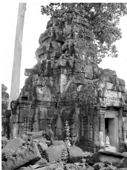
Ph. 390 : Angle Nord-Est du sanctuaire central BP.1 de Banteay Prei
