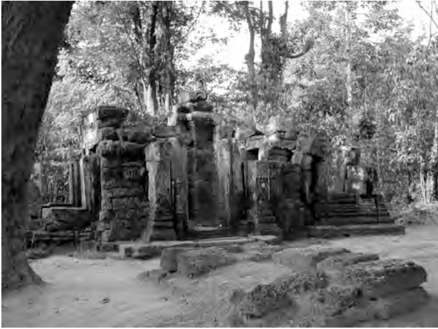
Ph. 173 : Face Sud de l'édifice Nord BK.55
