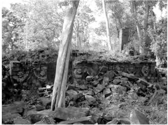
Ph. 458 : Soubassement et vestiges de la "bibliothèque" Sud BC.81
