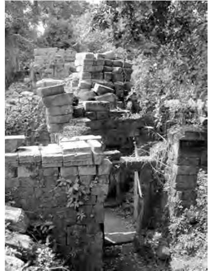
Ph. 328 : Vestiges de l'entrée Sud de la seconde enceinte PK.54
