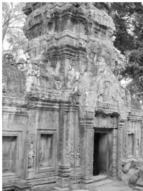
Ph. 161 : Pavillon d’entrée TP.23 de la première enceinte de Ta Prohm (Vue de l’angle Sud-Ouest)
