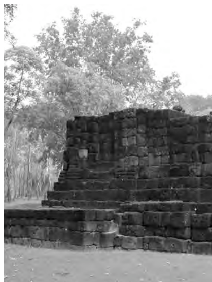
Ph. 939 : Face Sud du pavillon d'angle Sud-Ouest MS.9 de la première enceinte
