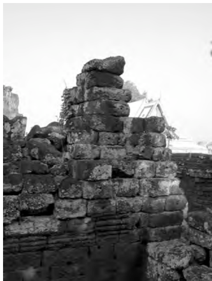
Ph. 923 : Vestiges de la superstructure du pavillon d'angle VN.22 vue du Nsud-Est
