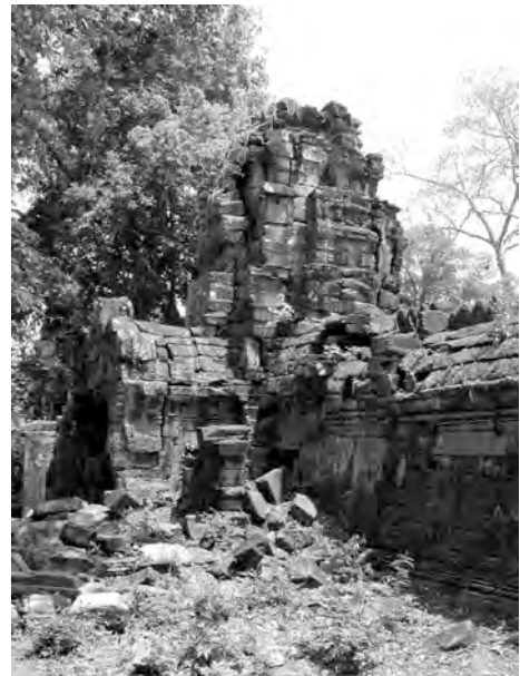
Ph. 480 : Pavillon d'entrée Nord BC.38 de la première enceinte de Banteay Chmar
