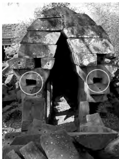
Ph. 41 : Logment de poutres en doublure à la première galerie-enceinte de Chau Srei Vibol
