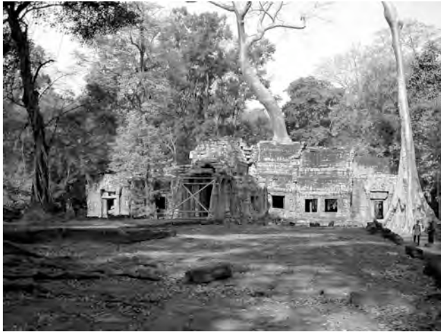
Ph. 94 : Terrasse TP.212 et pavillon d'entrée TP.210 de la quatrième enceinte de Ta Prohm
