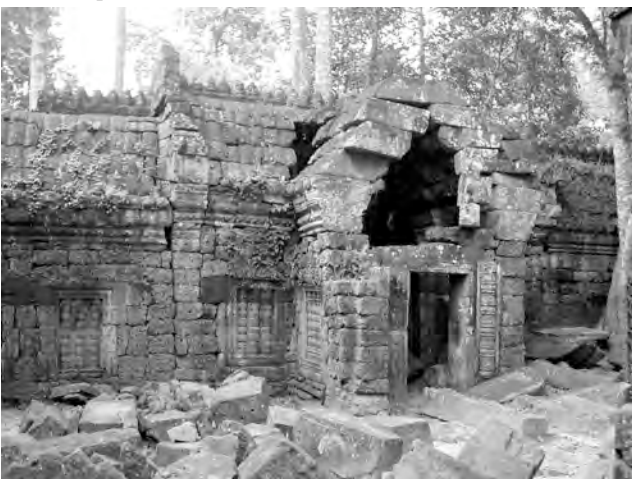
Ph. 261 : Pavillon Sud TN.9 de la première enceinte de Ta Nei
