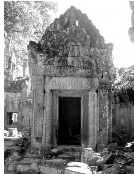
Ph. 304 : Face occidentale de la “ bibliothèque ” Sud-Est PK.122 du “ cloître ” Nord
