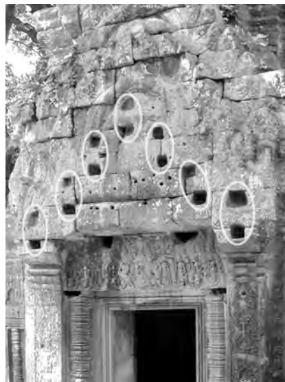
Ph. 782 : Fronton Est de la tour TP.65 présentant les traces d'une charpente à pannes doublées à Ta Prohm
