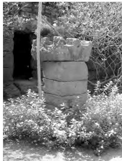
Ph. 514 : Pilier isolé Sud-Est TPB.3
