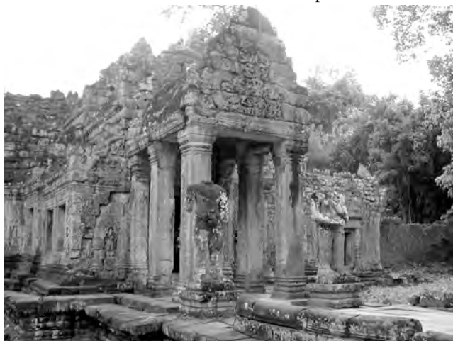
Ph. 299 : Porche de l'avant-corps Ouest du pavillon d'entrée occidental PK.157 de l'enceinte du temple
