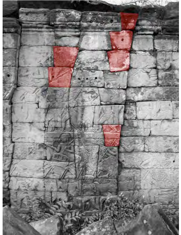
Ph. 39 : Exemple de coins de forçage (en rouge) à la même galerie de la troisième enceinte de Banteay Chmar
