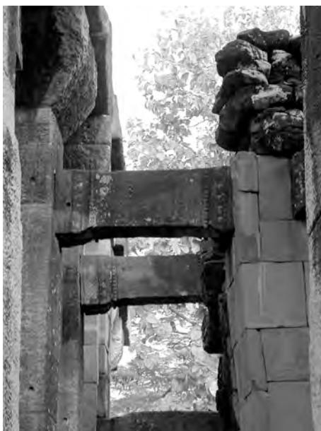
Ph. 791 : Étrésillons au pavillon axial Sud de la deuxième enceinte de Phimai
