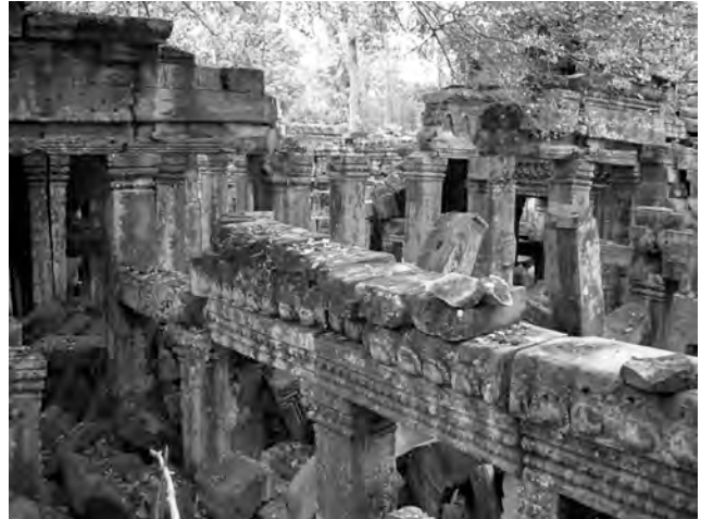
Ph. 109 : Vue intérieure de la "salle aux danseuses" TP.109
