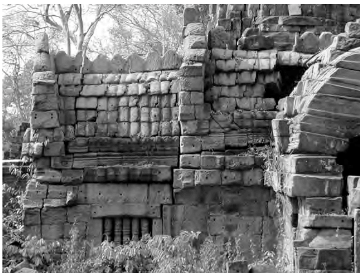
Ph. 938 : Face Sud de l'avant-corps Ouest du pavillon axial occidental PS.7 du Preah Stung
