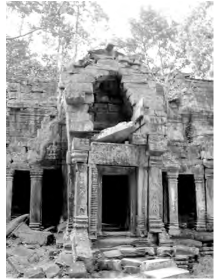
Ph. 119 : Entrée latérale Sud TP.83 du pavillon d'entrée orientale TP.81 de la troisième enceinte de Ta Prohm
