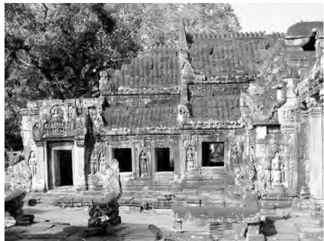
Ph. 185 : Entrée latérale et avant-corps Sud du pavillon d'entrée oriental BK.47 de l'enceinte du temple
