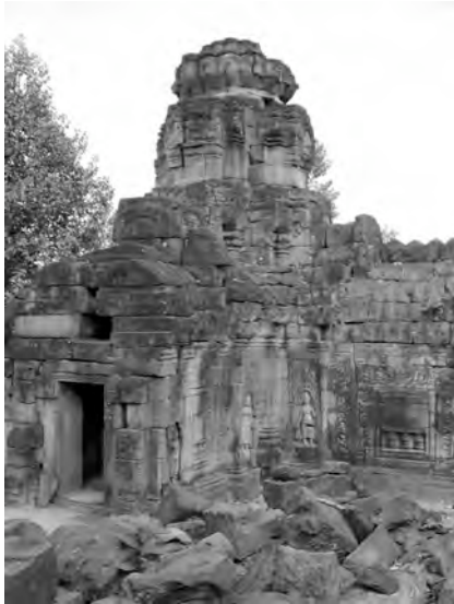
Ph. 384 : Pavillon d'entrée oriental BP.3 de la première enceinte de Banteay Kdei
