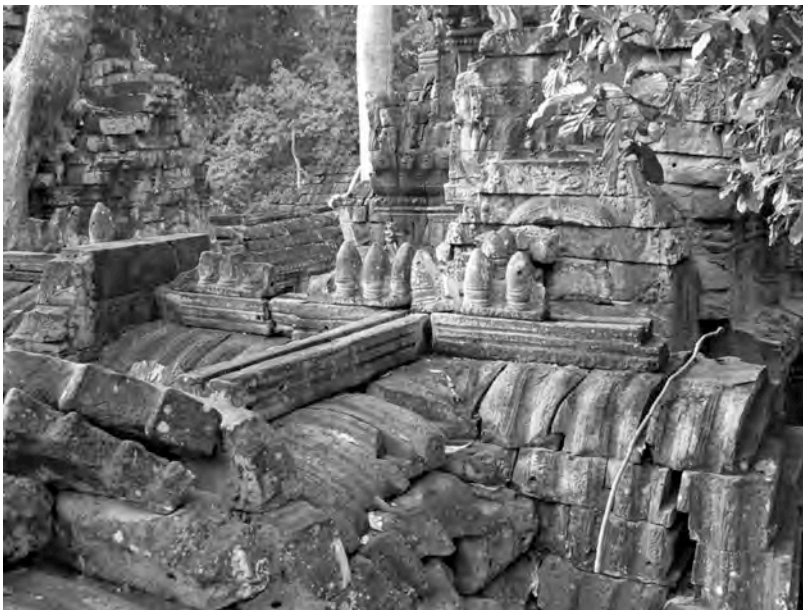
Ph. 631 : Extrados du pavillon Sud TP.75 du " cloître " Nord de Ta Prohm montrant le résultat de l'assemblage de la première variante du second modèle de faitage ( Type 2 )
