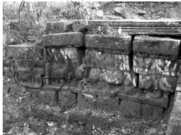
Ph. 526 : Mur de soutènement du débarcadère du Preah Stung
