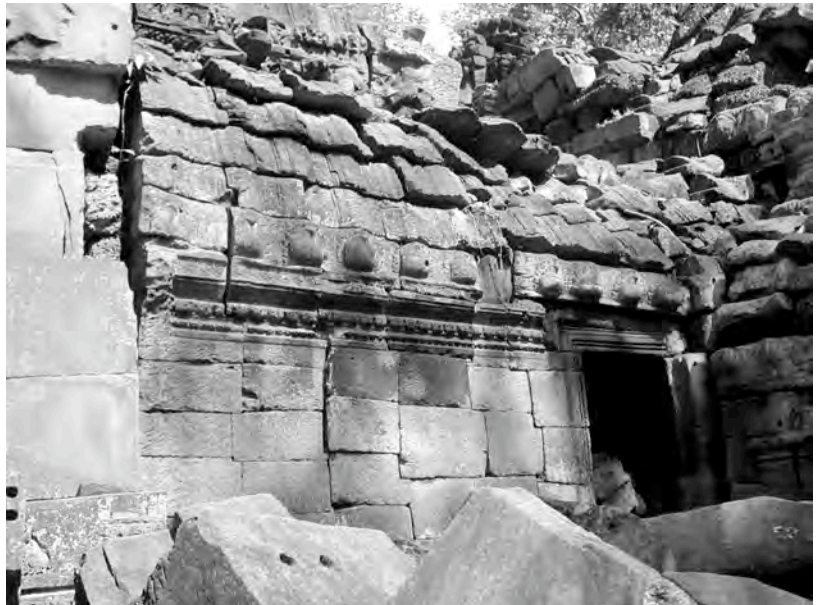
Ph. 160 : " Salle-passage " TP.34 entre le pavillon d'entrée Sud-Est TP.9 de la première enceinte (à gauche) et la seconde enceinte (à droite) de Ta Prohm
