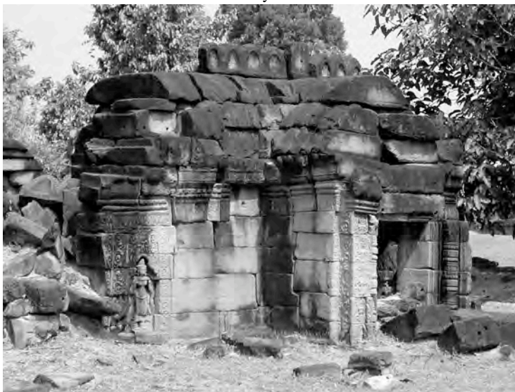
Ph. 388 : Pavillon d'angle Nord-Est BP.17 de la première enceinte de Banteay Prei
