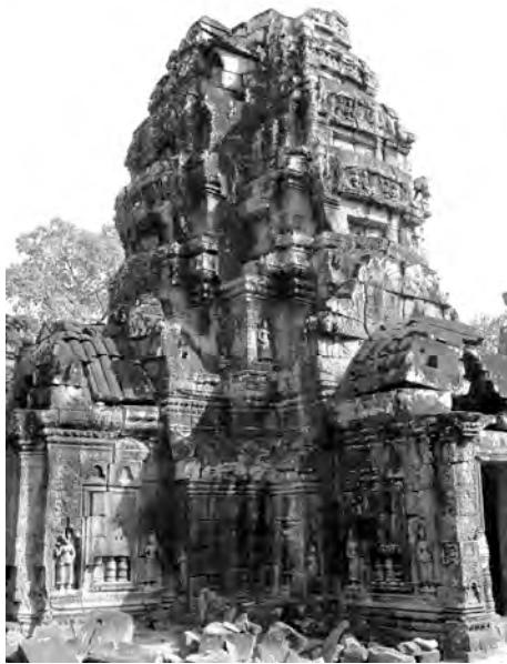
Ph. 425 : Sanctuaire central TS.1 de Ta Som (vue de l'angle Nord-Ouest)
