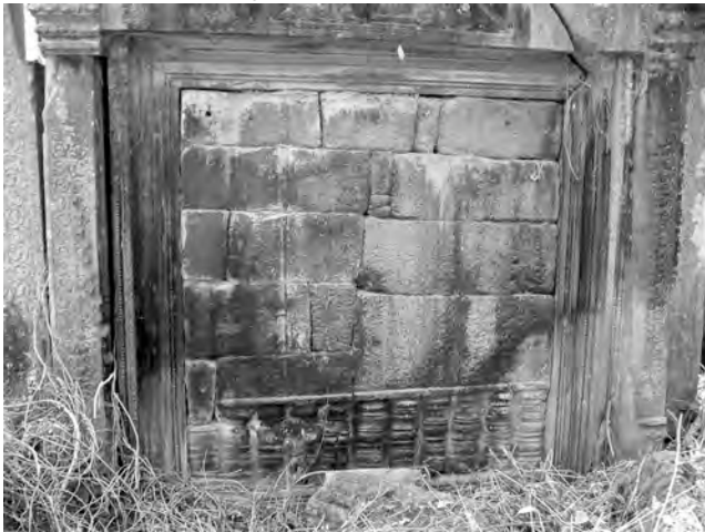
Ph. 556 : Fausse-fenêtre du pavillon PKKS.18
