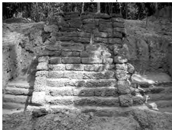
Ph. 283 : Escalier mis au jour au bassin PK.172 par le WMF
