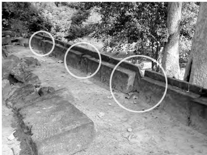
Ph. 875 : "Margelle" en grès présentant des réservations pour des piliers en bois sur le pourtour de la première plateforme du Preah Pithu X
