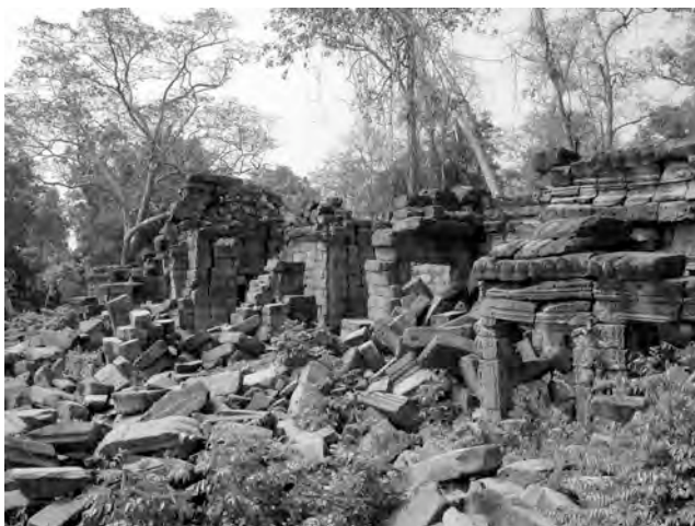
Ph. 455 : Vestiges du pavillon d'entrée oriental BC.140 de la troisième enceinte de Banteay Chmar
