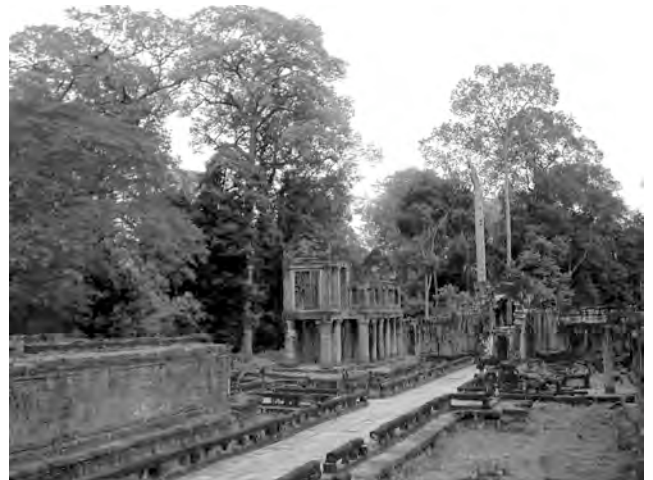
Ph. 314 : Chaussée Nord PK.147
