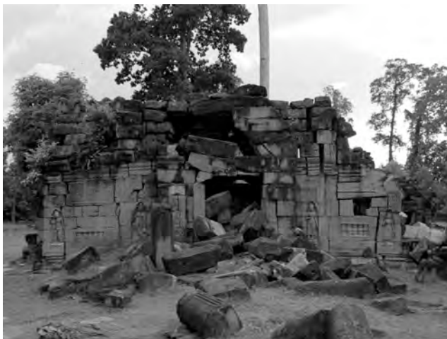
Ph. 378 : Face Est du pavillon d'entrée oriental BP.19 de la deuxième enceinte de Banteay Prei
