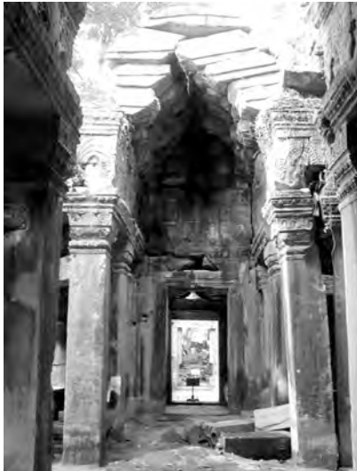
Ph. 96 : Nef centrale du pavillon d'entrée oriental TP.210 de la quatrième enceinte de Ta Prohm
