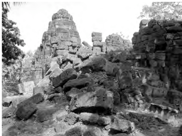
Ph. 915 : Ruine du pavillon d'angle Sud-Ouest TPB.14 de la première enceinte de Ta Prohm de Bati
