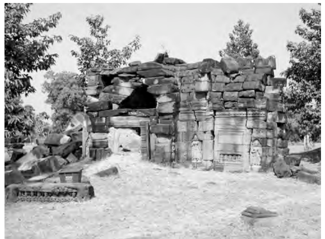
Ph. 379 : Angle Sud-Ouest du pavillon d'entrée oriental BP.19 de la seconde enceinte de Banteay Prei
