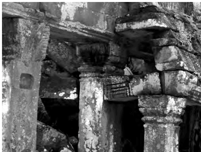
Ph. 794 : Étrésillons à la troisième enceinte de Ta Prohm
