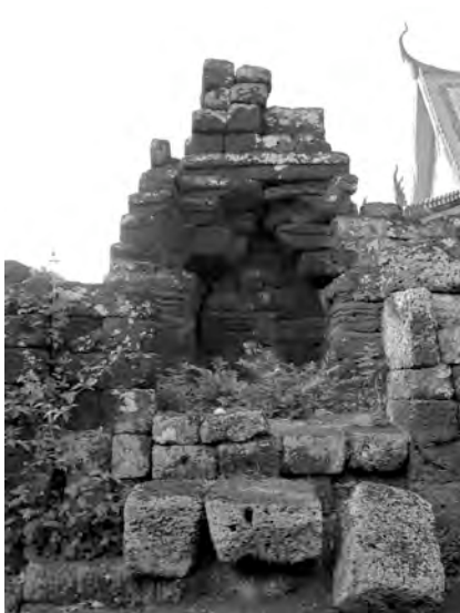
Ph. 924 : Vestiges de la superstructure du pavillon d'angle VN.22 de profil
