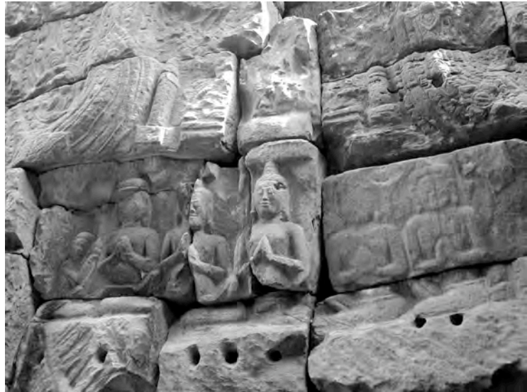
Ph. 741 : Fronton Ouest de la tour PK.62 du Preah Khan d'Angkor
