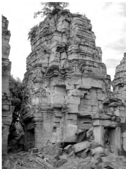
Ph. 76 : Sanctuaire central de Banteay Thom
