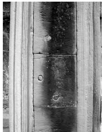
Ph. 36 : Exemple de trous de manipulation dissimulés par des bouchons en grès à Ta Kev
