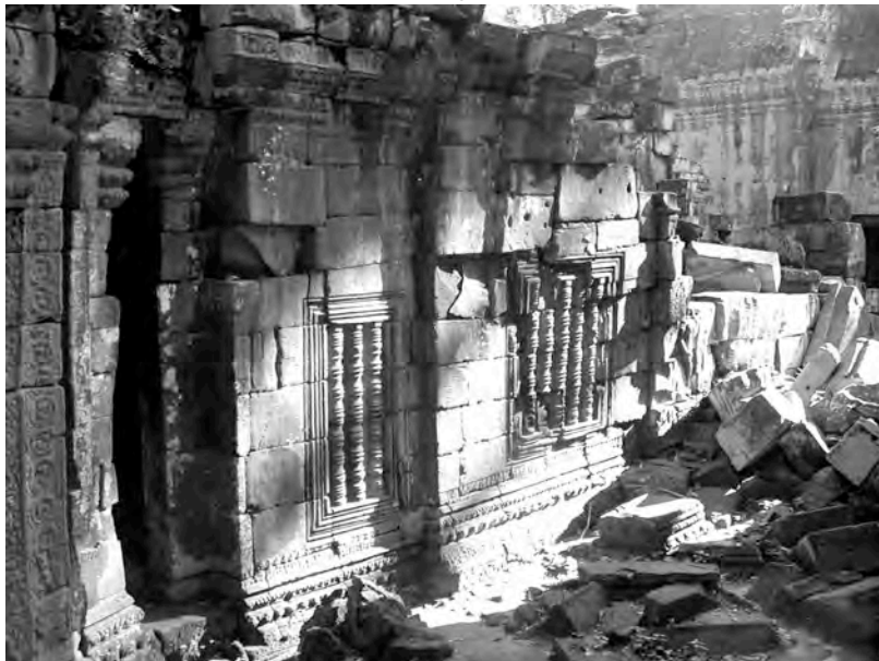
Ph. 128 : Édifice à salle longue TP.48 (face Sud)
