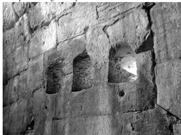
Ph. 67 : Vue intérieure des trous d'aération dans le mur Sud de la “bibliothèque” Sud de la première enceinte de Banteay Kdei
