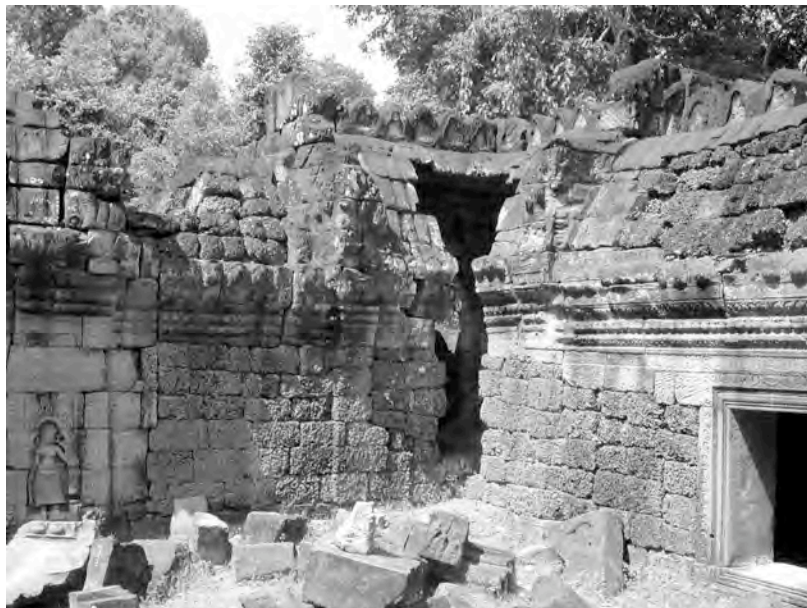
Ph. 421 : Pavillon d'angle Nord-Ouest TS.16 de la première enceinte de Ta Som (vue de l'angle Sud-Est)
