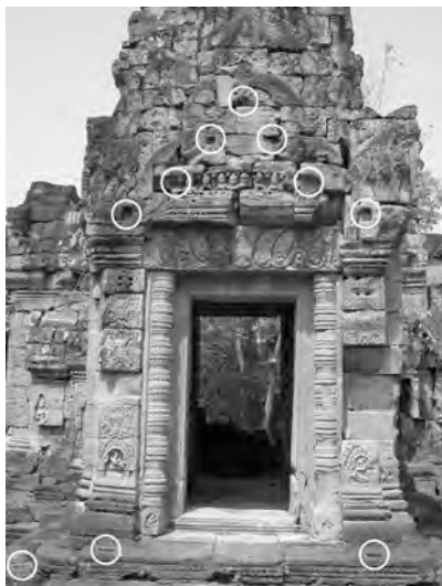
Ph. 837 : Avant-corps Est du sanctuaire de Prasat Prei
