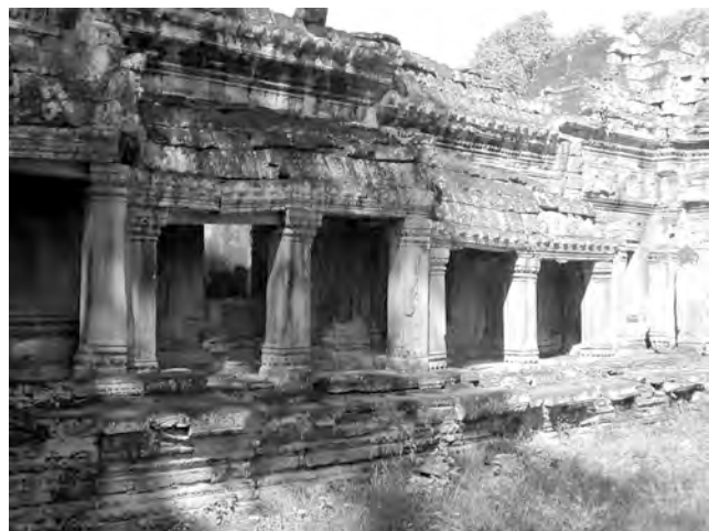
Ph. 290 : Galerie PK.165 reliant les avant-corps de pavillon central PK.148 et latéral PK.164 de l'entrée orientale de l'enceinte du temple
