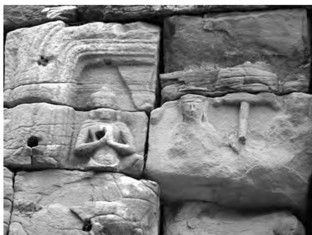
Ph. 983 : Détail du fronton de la face orientale du deuxième faux-étage de la tour occidentale de Banteay Tiep
