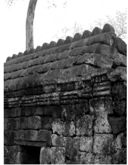
Ph. 644 : Faîtage de type 4 en latérite de la première enceinte de Muang Sing (Thaïlande)
