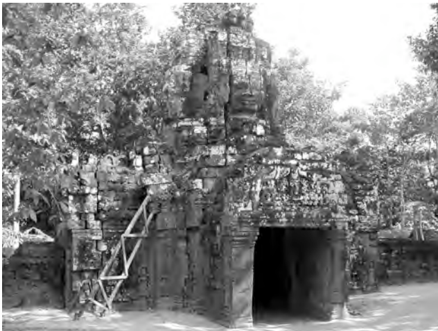
Ph. 411 : Gopura Ouest TS.32 de l'enceinte de domaine de Ta Som (vue de l'angle Nord-Ouest)
