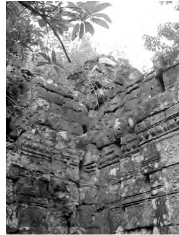
Ph. 246 : Couverture du pavillon d'entrée occidental TN.36 de la troisième enceinte de Ta Nei
