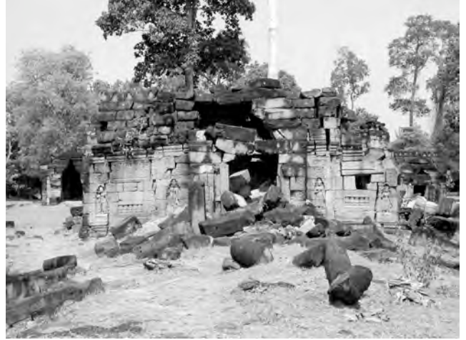
Ph. 375 : Vestiges de la terrasse cruciforme précédant le pavillon d'entrée oriental BP.19 de la seconde enceinte de Banteay Prei
