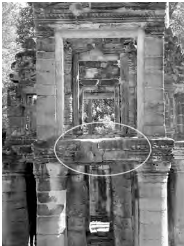
Ph. 64 : Face occidentale de l'“édifice à colonnes” du Preah Khan d'Angkor
