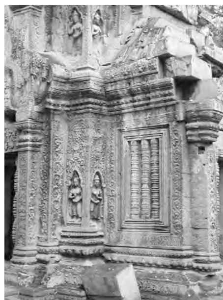
Ph. 704 : Fausse-fenêtre à faux-balustres de la face Sud de l'avant-corps Est de la tour TP.49
