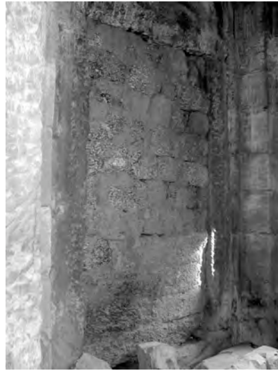
Ph. 236 : Porte Sud bouché du sanctuaire central BK.1
