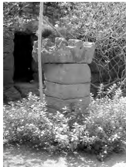
Ph. 514 : Pilier isolé Sud-Est TPB.3
