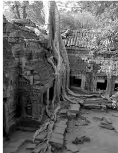
Ph. 97 : Bas-côtés de l'angle Nord-Ouest du pavillon d'entrée oriental TP.210 de la quatrième enceinte de Ta Prohm
