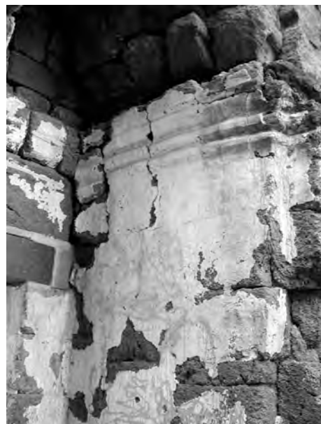
Ph. 575 : Fragment d'enduit dans le pavillon d'entrée Nord MS.16 de la première enceinte de Muang Sing
