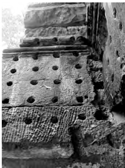
Ph. 949 : Détail de l'aspect intérieur de l'avant-corps Nord du sanctuaire central de Ta Prohm
