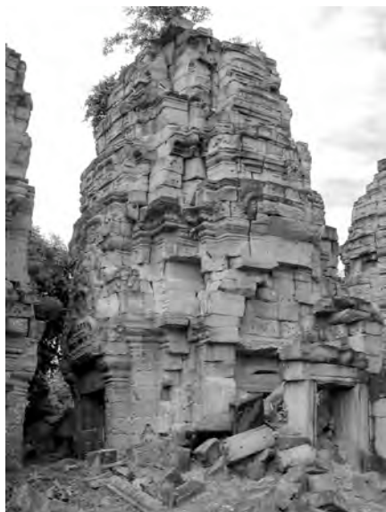
Ph. 76 : Sanctuaire central de Banteay Thom
