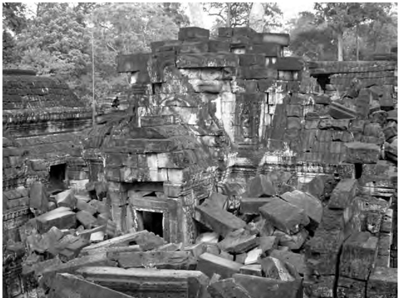
Ph. 348 : Face Sud des vestiges de la tour PK.33
