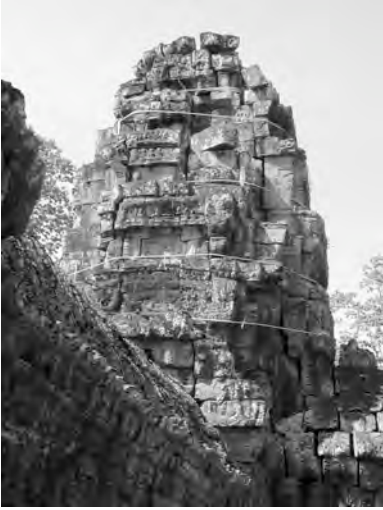
Ph. 222 : Pavillon d'entrée Nord BK.26 de la première enceinte du temple
