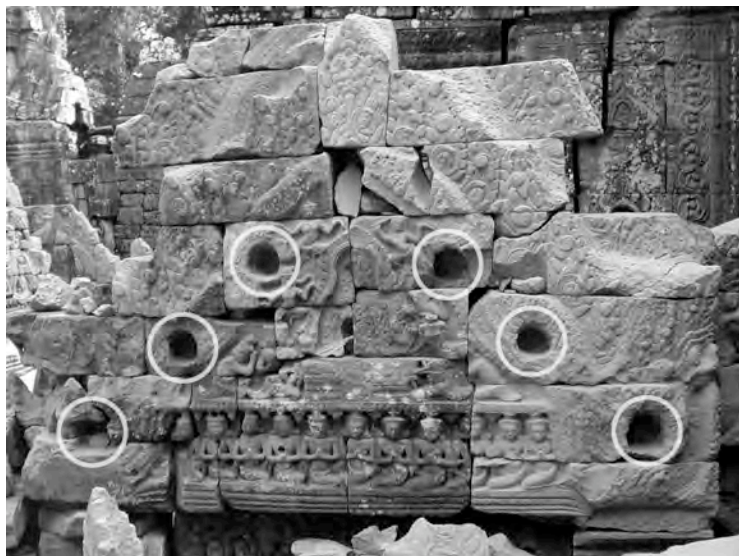
Ph. 781 : Fronton remonté présentant les traces d'une charpente à Ta Som
