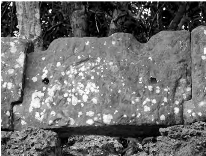
Ph. 645 : Face extérieure ébauchée des faîtages de type 4 du mur de l'enceinte de domaine de Ta Som
