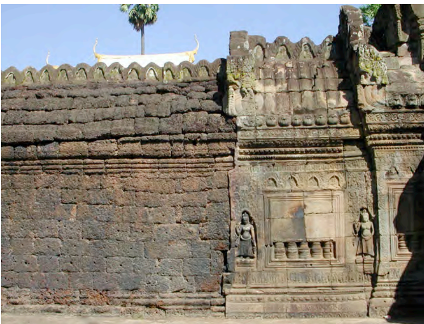
Ph. 32 : Exemple de la confrontation de la latérite avec le grès à la première enceinte de Vat Nokor, Cambodge, fin du XII e siècle
