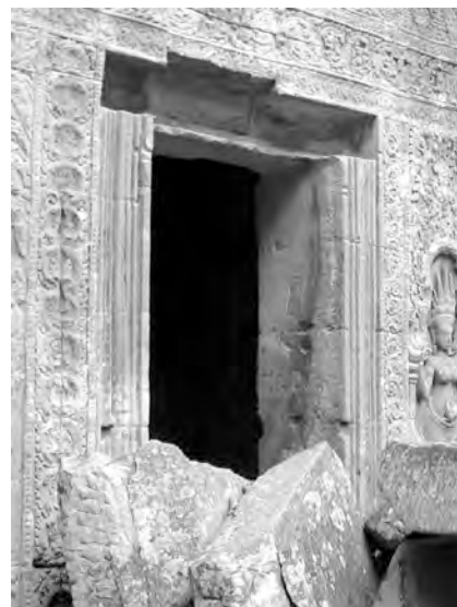
Ph. 787 : Exemple d'ouverture d'une fenêtre dans une fausse-fenêtre de la première galerie-enceinte de Ta Prohm
