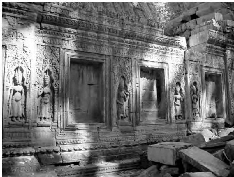
Ph. 162 : Tronçons de galerie TP.12-13 entre le pavillon d'entrée Sud TP.11 (à droite) et le pavillon d'angle Sud-Est TP.14 de la première enceinte de Ta Prohm (vue de la face Sud)
