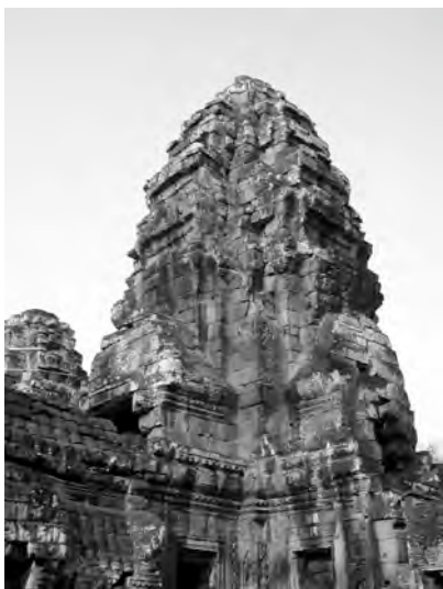
Ph. 235 : Superstructure du sanctuaire central de Banteay Kdei
