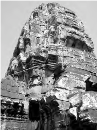
Ph. 228 : Pavillon d'angle Nord-Est BK.28 de la première enceinte du temple
