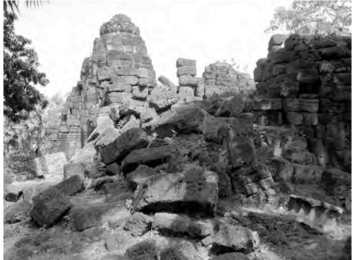
Ph. 512 : Vestiges du pavillon d'angle Sud-Est de la première enceinte de Ta Prohm de Bati
