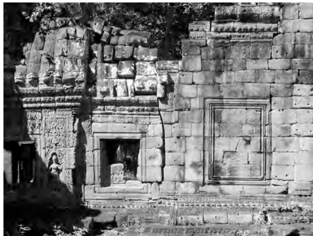
Ph. 308 : Connexion entre le bras Nord du pavillon d'entrée Nord PK.136 du “ cloître ” Nord et l'avant-corps Sud du pavillon d'entrée Nord PK.160 de l'enceinte du temple (à droite)
