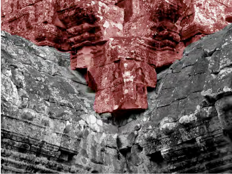
Ph. 878 : Détail de l'adjonction d'une cheminée sur une croisée de voûtes au pavillon d'angle Sud-Ouest BK.20
