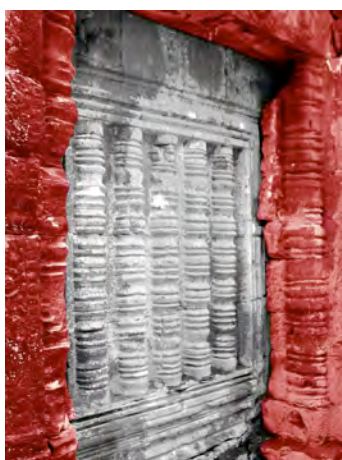
Ph. 610 : Fausse-fenêtre Nord de la "bibliothèque" Sud de Banteay Kdei (Les maçonneries ajoutées sont en rouge)
