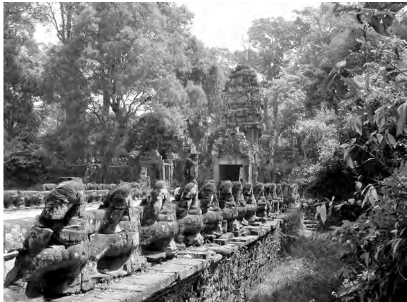
Ph. 271 : Chaussée-digue occidentale PK.189
