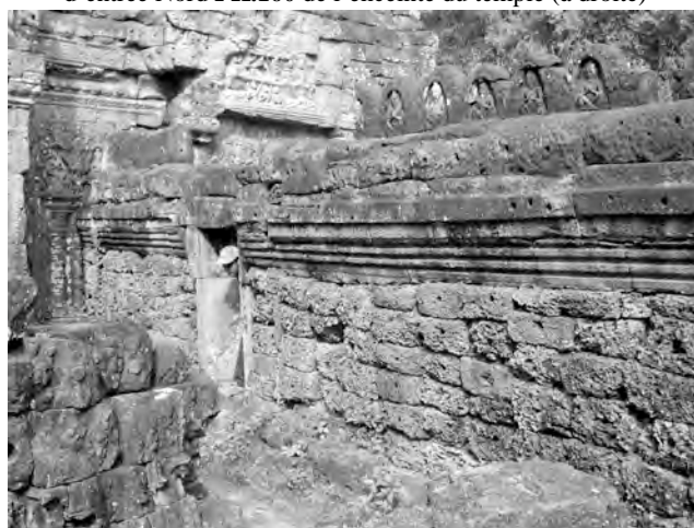
Ph. 310 : Mur Nord PK.116 entre le pavillon d'entrée Ouest PK.157 de l'enceinte du temple et le pavillon d'angle Nord-Ouest de l'enceinte du “ cloître ” occidental
