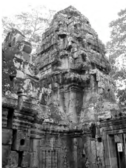
Ph. 220 : Pavillon d'entrée Sud BK.18 de la première enceinte du temple
