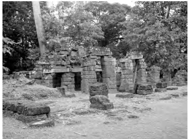
Ph. 200 : Vestiges de l’édifice BK.37 se raccordant à la seconde enceinte du monument
