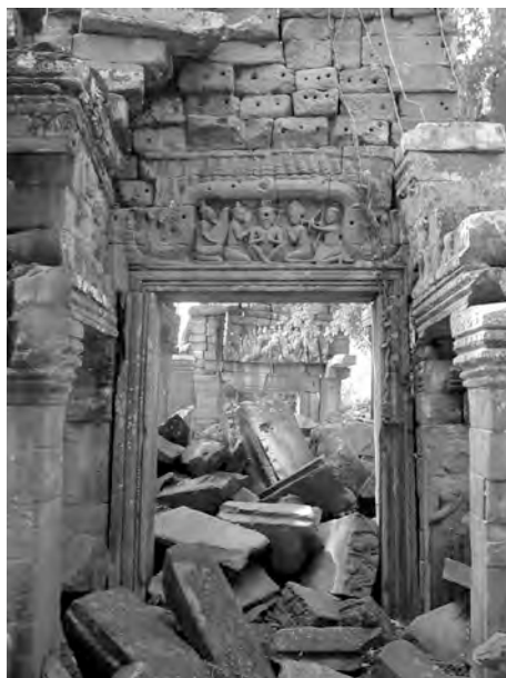
Ph. 460 : Vue intérieure des vestiges de la "salle aux danseuses" BC.80
