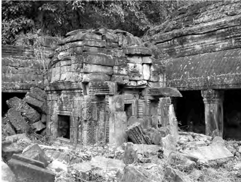
Ph. 346 : Édifice PK.5 situé à l'angle Sud-Est de la cour intérieure de la première enceinte du Preah Khan d'Angkor
