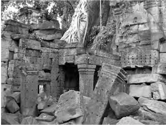
Ph. 165 : Vestiges de la salle hypostyle TP.2 entre le pavillon d'entrée TP.7 (à droite) de la première enceinte et le sanctuaire central TP.1 de Ta Prohm
