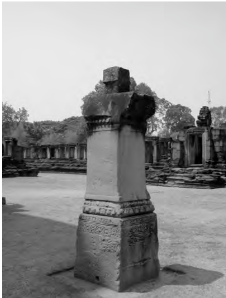
Ph. 601 : Pilier isolé Nord-Ouest (PH.5)
