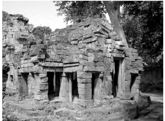
Ph. 324 : Édifice PK.140 précédant le pavillon d'entrée oriental PK.124 de l'enceinte du "cloître" Nord
