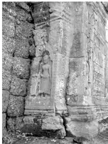
Ph. 280 : Connexion entre le mur de l'enceinte de domaine et le pavillon d'entrée latérale Nord PK.173 de la porte orientale
