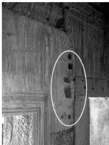
Ph. 834 : Traces de cloisonnement à la galerie PK.40 de la première enceinte du Preah Khan d’Angkor
