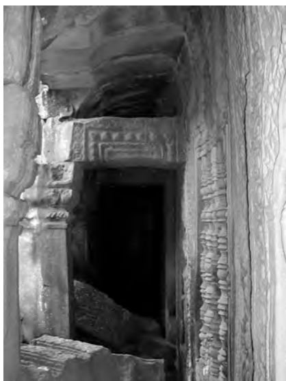
Ph. 795 : Étrésillons à la première enceinte du Preah Khan d'Angkor
