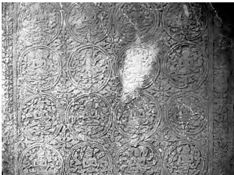
Ph. 733 : Tableau de porte à médaillons à orant à Ta Prohm
