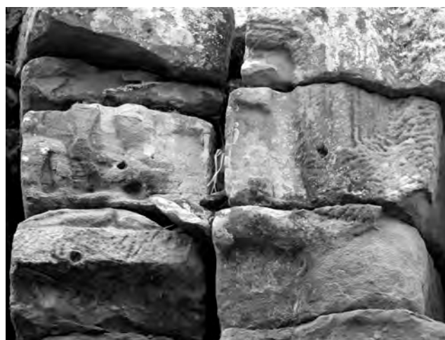
Ph. 984 : Détail du fronton de la face orientale du deuxième faux-étage de la tour occidentale de Banteay Tiep
