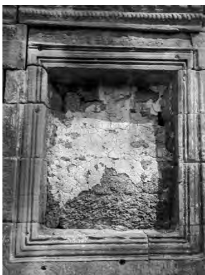
Ph. 808 : Fausse-fenêtre de la première enceinte du Banteay Kdei
