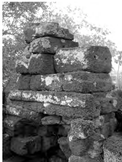
Ph. 925 : Détail des vestiges de la superstructure du pavillon d'angle VN.22
