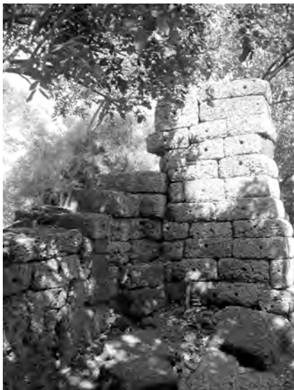
Ph. 908 : Angle Sud-Est du pavillon d'angle Nord-Ouest de la première enceinte
