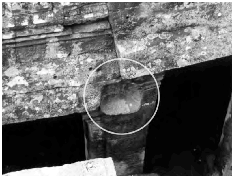
Ph. 798 : Logement d'un "étrépillon" sur un pilier de la nef centrale de la galerie du deuxième étage du Bayon
