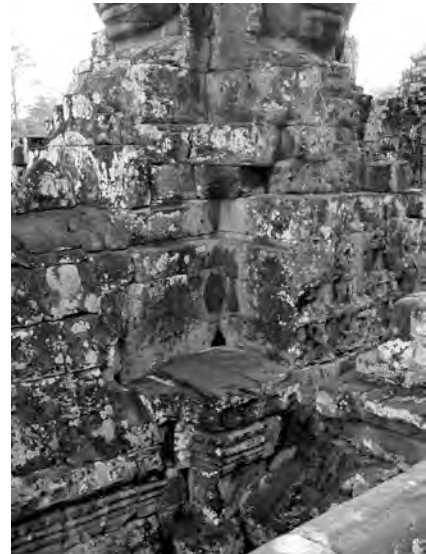
Ph. 934 : Angle Nord-Est de la tour BY.40 du second étage du Bayon
