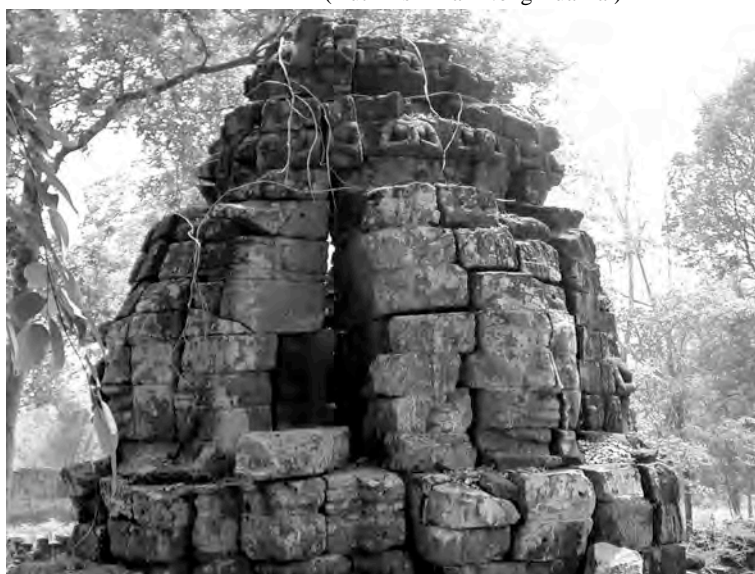
Ph. 79 : Superstructure de la tour-sanctuaire Sud-Est du complexe occidental de Banteay Chmar
