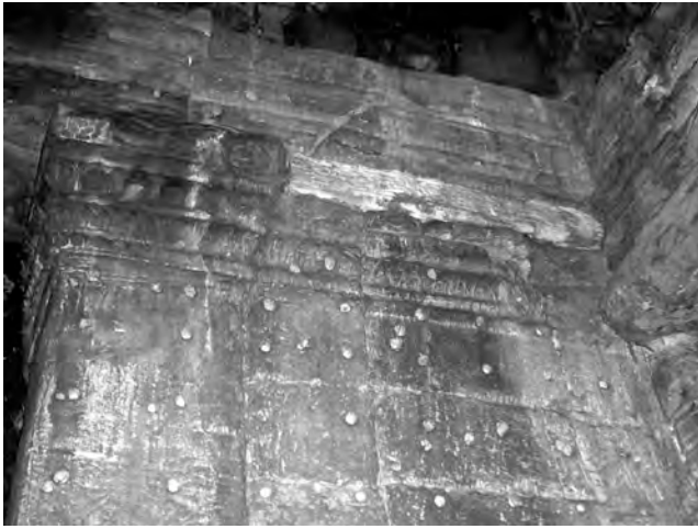
Ph. 963 : Paroi de la tour BY.2 du Bayon
