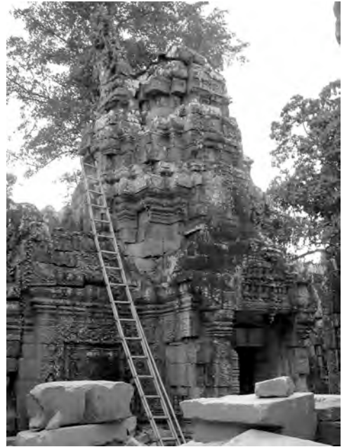
Ph. 418 : Pavillon d'entrée Sud TS.10 de la première enceinte de Ta Som (vue de l'angle Nord-Est)
