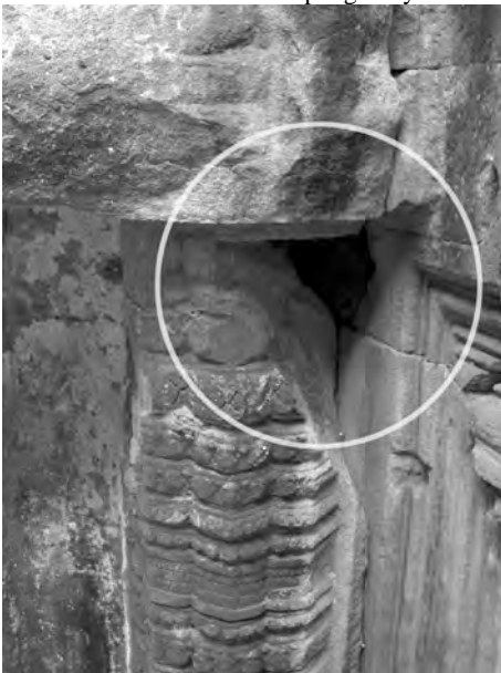
Ph. 976 : Logement de crampon pillé à l'avant-corps oriental du pavillon axial Est PKKS.5 de la première enceinte du complexe central du Preah Khan de Kompong Svay
