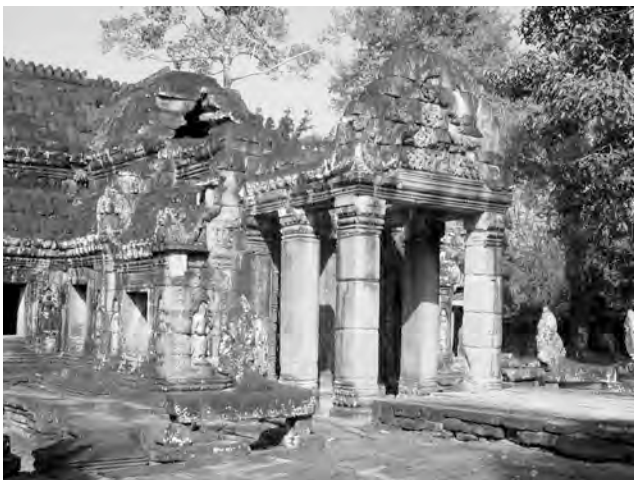
Ph. 184 : Porche Est du pavillon d'entrée oriental BK.47 de l'enceinte du temple
