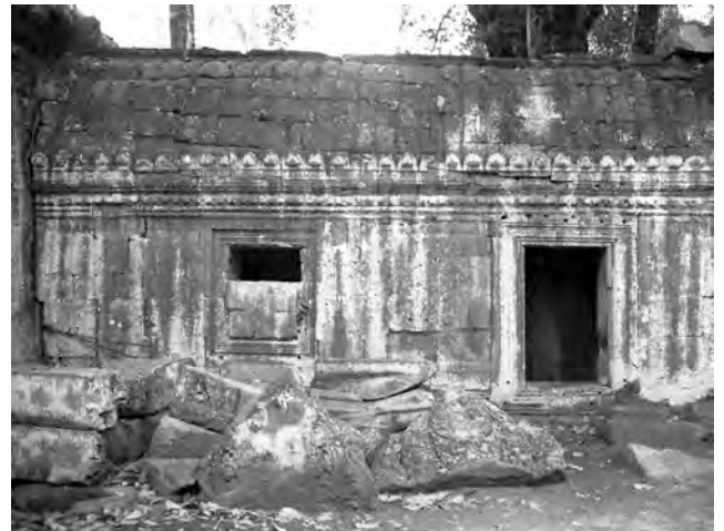
Ph. 150 : Connexion entre la galerie TP.64 du “ cloître ” Sud et le pavillon d'entrée Sud TP.87 de la troisième enceinte de Ta Prohm (à gauche)
