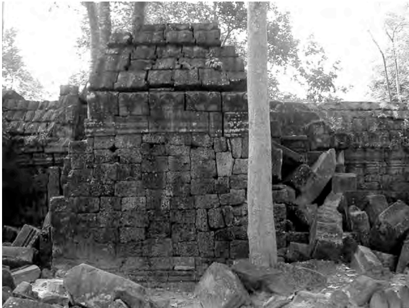
Ph. 265 : Face Nord de la “bibliothèque” Sud-Est TN.3 de Ta Nei
