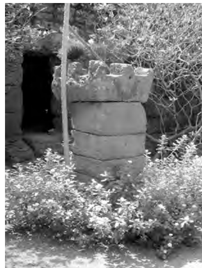
Ph. 514 : Pilier isolé Sud-Est TPB.3
