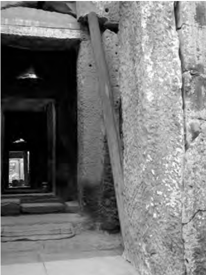
Ph. 753 : Piédroit Nord de la porte de l'avant-corps oriental du sanctuaire central BK.1 de Banteay Kdei
