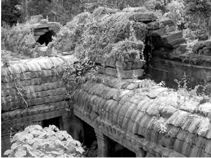
Ph. 327 : Vestiges de la superstructure de la galerie-enceinte Sud de la seconde enceinte PK.54
