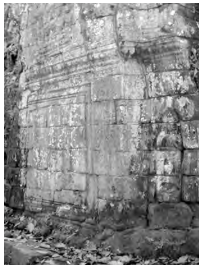
Ph. 713 : Façade Nord du gîte d'étape du Preah Khan d'Angkor
