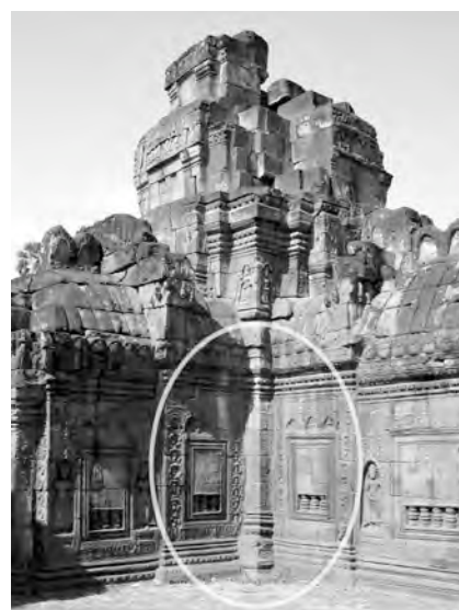
Ph. 933 : Angle Nord-Ouest du pavillon axial Nord VN.20 de la première enceinte de Vat Nokor
