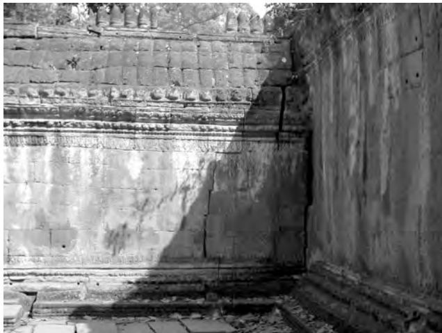
Ph. 149 : Connexion entre la galerie TP.63 du “ cloître ” Sud (à gauche) et la galerie TP.86 de la troisième enceinte de Ta Prohm (à droite)
