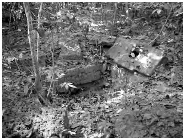
Ph. 352 : Vestiges d'une des terrasses en latérite entre les bassins non parementés
