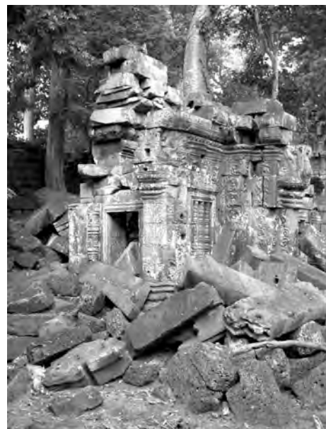
Ph. 125 : Tour PK.50 (vue du trois-quarts Nord-Est)
