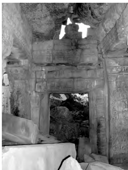
Ph. 144 : Voûte sur piliers TP.28 formant un passage couvert entre le tronçon Ouest de la galerie TP.37 du “ cloître ” oriental et le tronçon de galerie TP.26 de la première enceinte du temple
