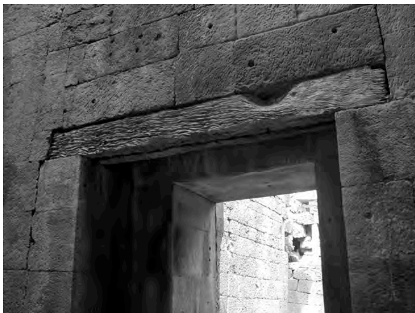
Ph. 40 : Poutre de soutien en bois faisant office de linteau au Kleang Nord à Angkor Thom
