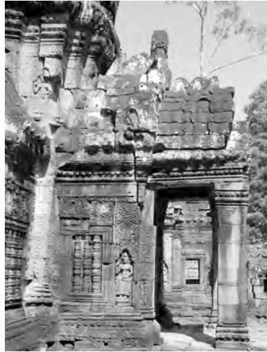
Ph. 223 : Poche du Pavillon d'entrée Est BK.14 de la première enceinte du temple
