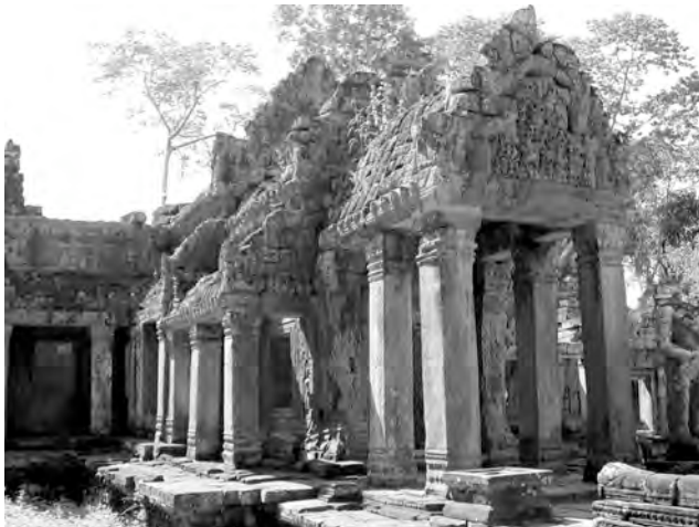
Ph. 293 : Porche précédant l'avant-corps Nord du pavillon central PK.160 de l'entrée Nord de l'enceinte du temple
