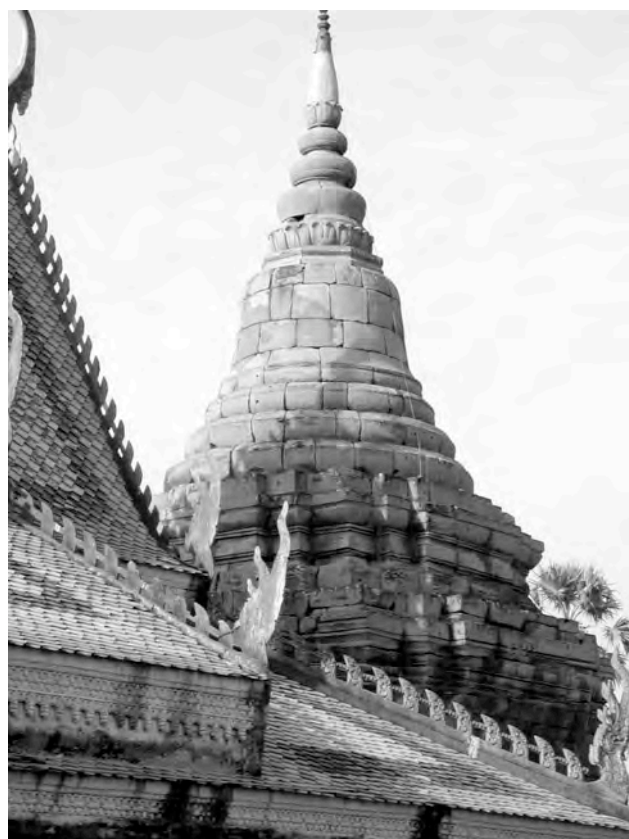
Ph. 927 : Face Nord-Est de la superstructure du sanctuaire central VN.1 de Vat Nokor
