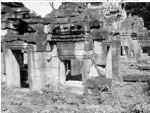
Ph. 309 : Vestiges du pavillon d'angle Sud-Est PK.126 de l'enceinte du “ cloître ” Nord
