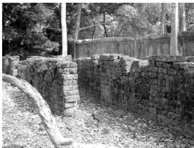
Ph. 135 : Exemple d'un des corps latéraux de l'annexe TP.52
