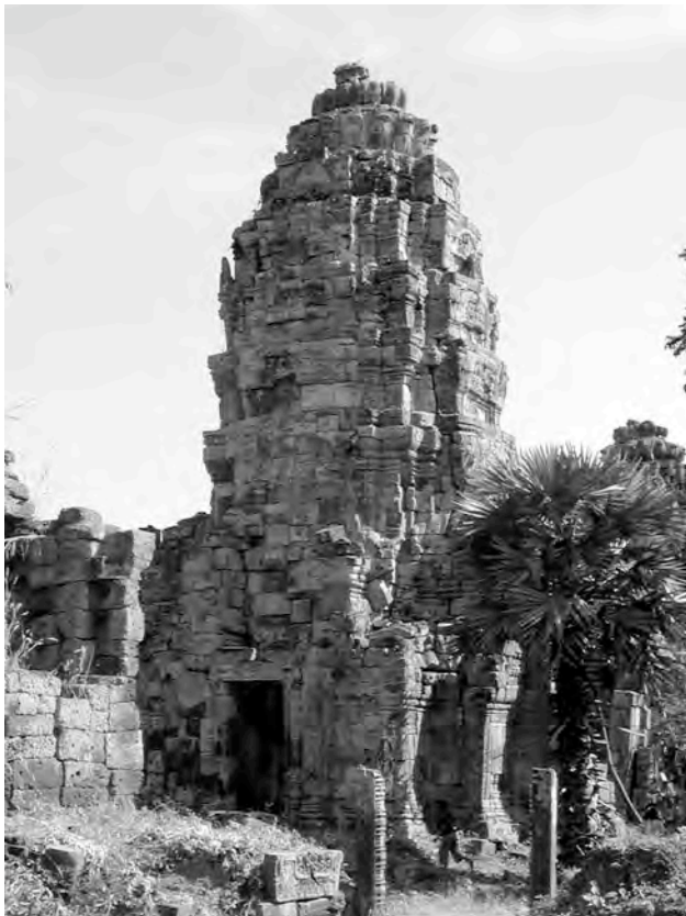
Ph. 521 : Sanctuaire central de Vat Banon, vue de l'angle Sud-Est
