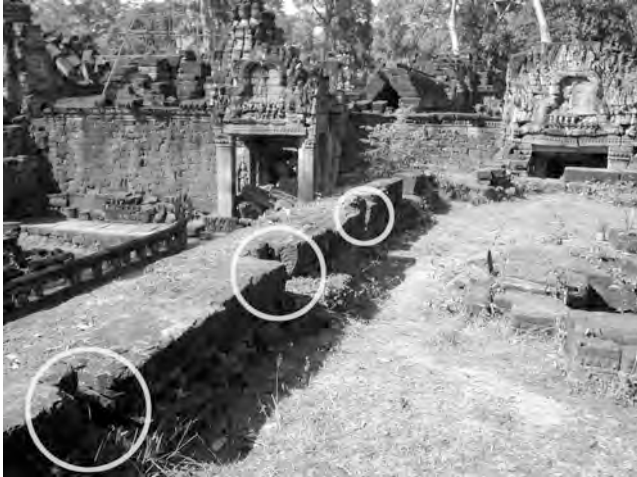
Ph. 871 : Muret Sud de l'édifice PK.44 du Preah Khan d'Angkor présentant des réservations pour des piliers en bois
