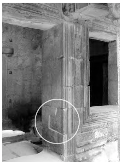
Ph. 622 : Exemple d'un piédroit d'une fenêtre transformée en porte à la troisième enceinte de Ta Prohm présentant une lacune
