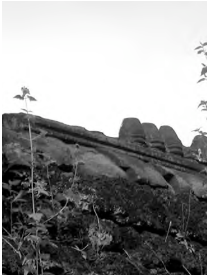
Ph. 634 : Faitage de type 3 en deux parties sans assemblage à la première enceinte du Preah Khan d'Angkor
