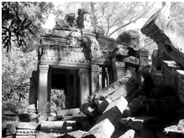
Ph. 100 : Vestiges du porche et de l'avant-corps Ouest du pavillon d'entrée occidental TP.211 de la quatrième enceinte de Ta Prohm
