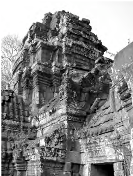
Ph. 540 : Tour à faux-étages de l'entrée axiale PKKS.80 de la porte orientale du Preah Khan de Kompong Svay
