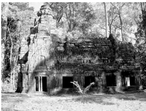
Ph. 281 : Face Sud du gîte d'étape PK.170
