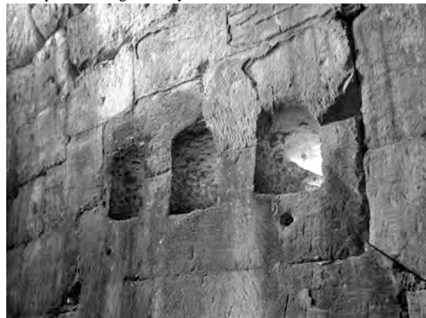
Ph. 67 : Vue intérieure des trous d'aération dans le mur Sud de la “bibliothèque” Sud de la première enceinte de Banteay Kdei
