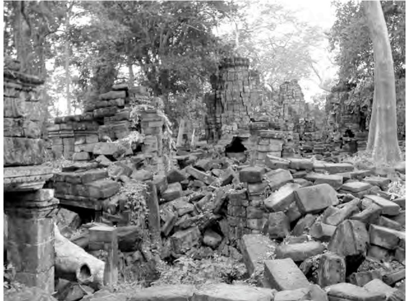
Ph. 617 : Exemple de structures illisibles au complexe oriental de Banteay Chmar
