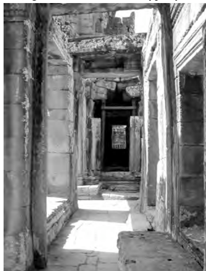
Ph. 239 : Bas-côté de la salle hypostyle BK.6 sur lequel ouvre la chapelle d'angle Nord-Est BK.5
