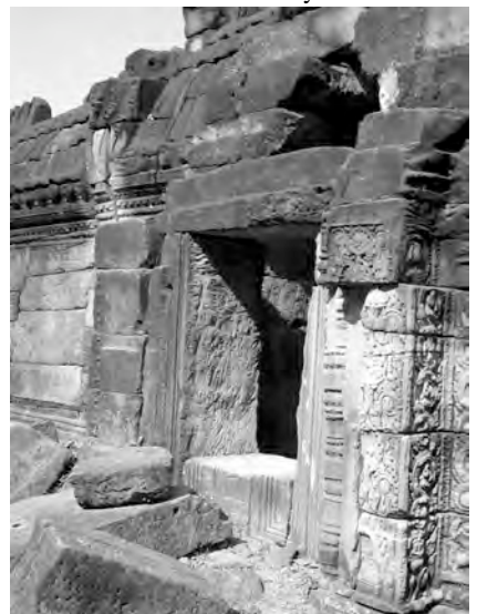
Ph. 389 : Fausse porte Ouest partiellement ouverte aujourd'hui du pavillon d'angle Sud-Ouest BP.9 de la première enceinte de Banteay Prei
