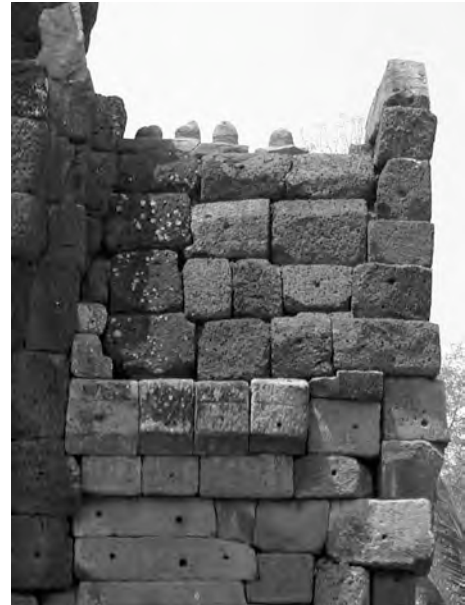
Ph. 648 : Faîtage de l’avant-corps de la chapelle de l’hôpital de Kuti Rishi Ban Nong Bua Lai (Thaïlande)
