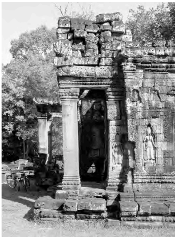
Ph. 194 : Entré Sud-Ouest de la “salle aux danseuses” BK.36 dont la toiture du porche en constitué de grès de latérite
