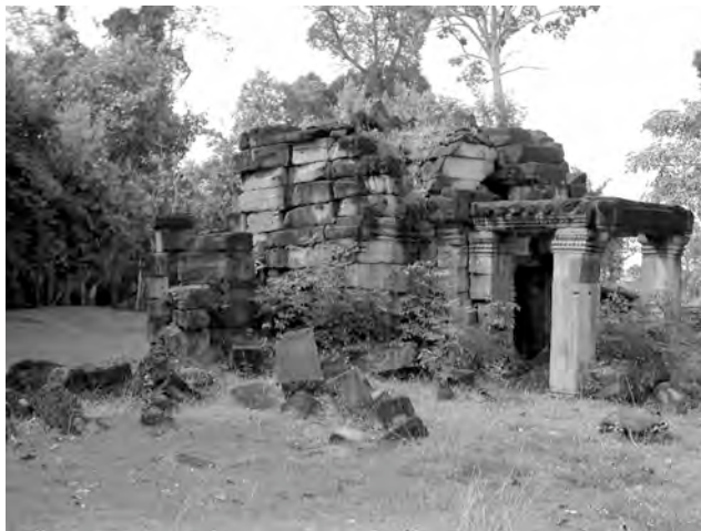
Ph. 381 : Angle Sud-Est du pavillon d'entrée occidental BP.21 de la seconde enceinte de Banteay Prei
