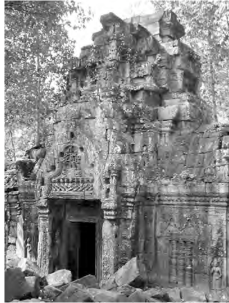
Ph. 258 : Pavillon d'entrée Ouest TN.17 de la première enceinte de Ta Nei
