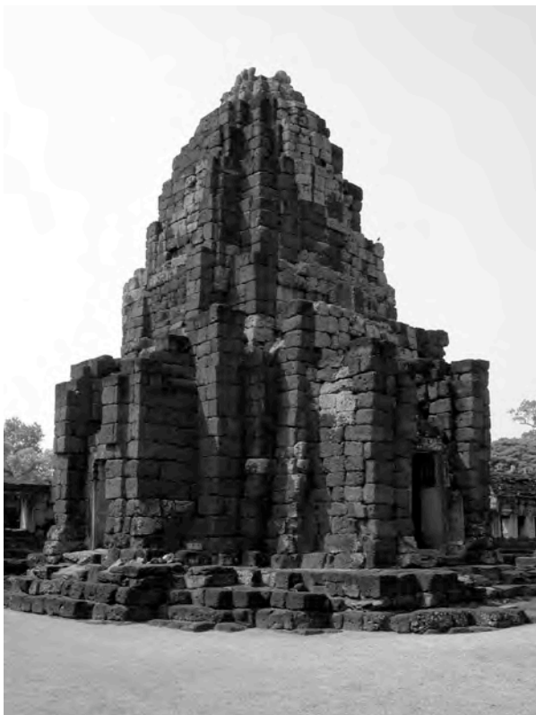
Ph. 607 : Vue Nord-Est du Prang Bhamathat
