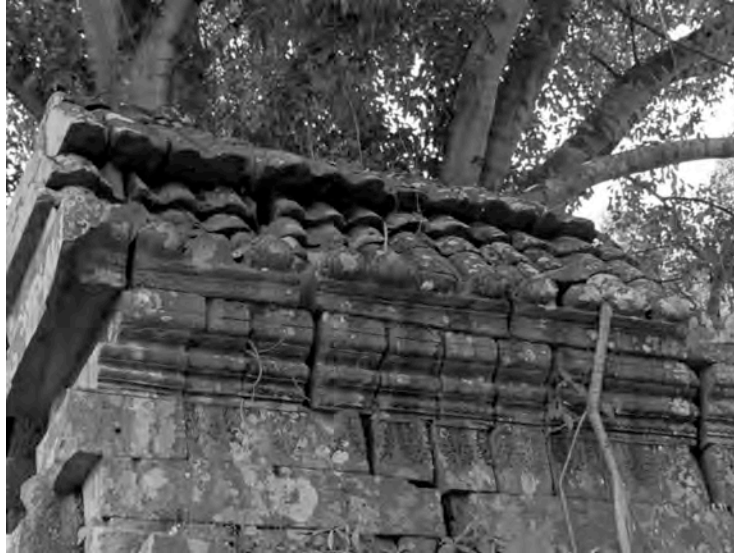
Ph. 661 : Couverture de la deuxième enceinte du Preah Khan de Kompong Svay avec antéfixes à pétales de lotus
