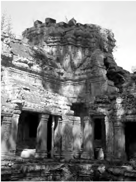
Ph. 287 : Vestiges de la superstructure du pavillon central PK.148 de l'entrée orientale de l'enceinte du temple
