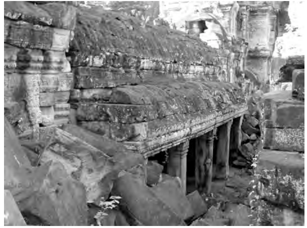
Ph. 338 : Face orientale de la galerie PK.11 entre le sanctuaire central et le pavillon d'entrée Sud PK.41 de la première enceinte
