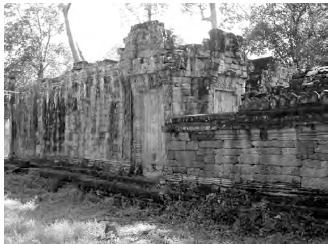
Ph. 320 : Mur Nord PK.66 reliant la seconde enceinte du Preah Khan d'Angkor avec la “salle aux danseuses”
