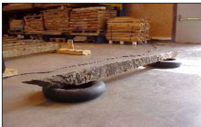
Figure 193 : Détail d'une poutre de section et de terminaison irrégulières.
