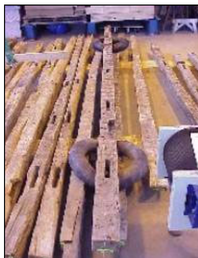
Figure 194 : Détail d'une poutre comportant des sous sections pour permettre son assemblage dans une charpente.
