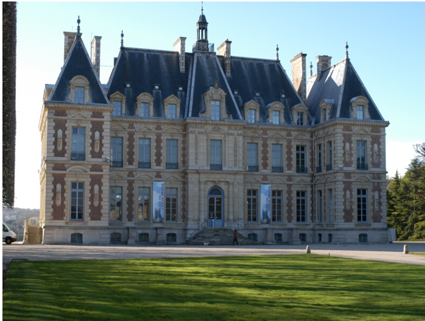
FIG. 5.3: Façade du château de Sceaux.
