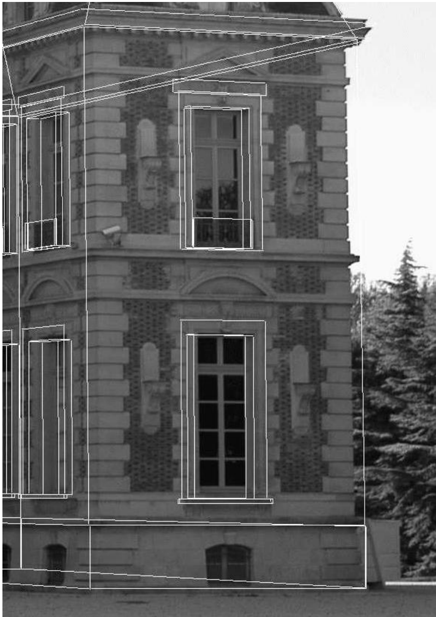
FIG. 5.13: Détail du modèle filaire reprojété. On observe que l'arête du mur vertical à droite de l'image est mal positionnée. Cette erreur est due à la définition d'un arête complètement rectiligne ne tenant pas compte des décrochements présents.
