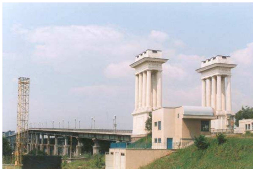
Figure 32 : Le pont enjambant le Danube entre Giurgiu et Ruse (cliché J.Cristescu, 2002)
