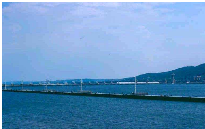
Figure 71 : Le barrage des Portes de fer (cliché J. Cristescu, 1998)
