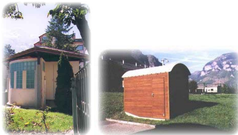
figure III-1 : Station de Chamonix (à gauche) et de Saint-Jean de Maurienne (à droite).
