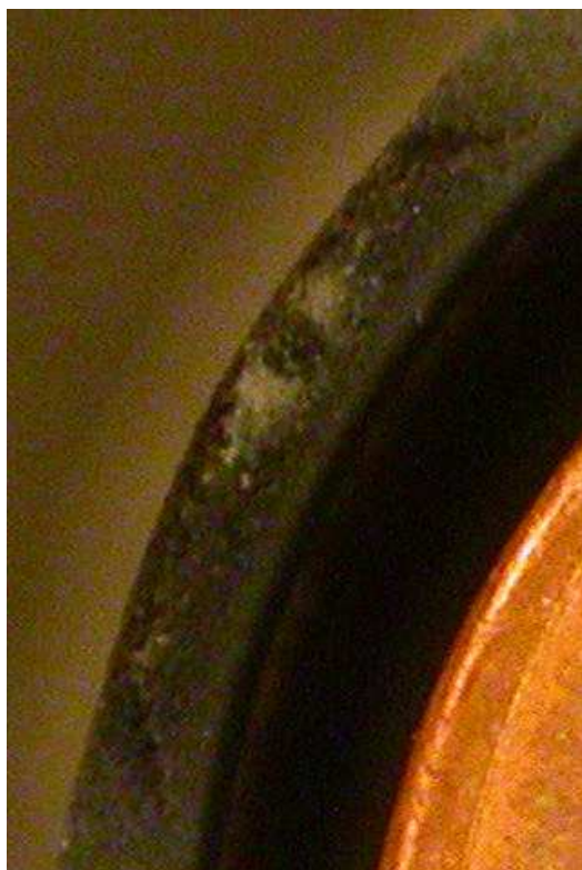
Fig 6 : agrandissement d'une zone de rupture
