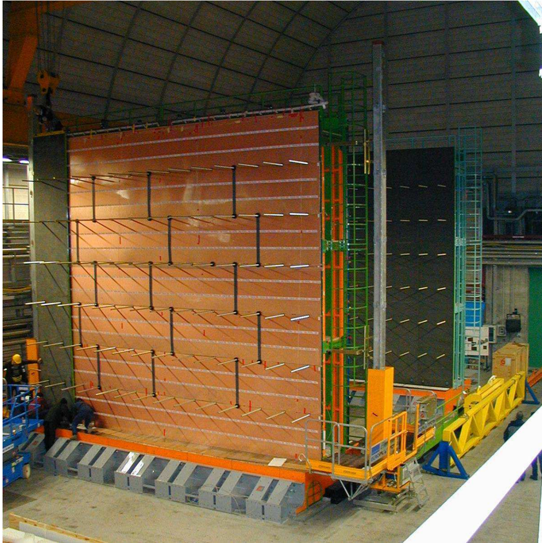
FIG. 4.26 – Photographie de l'état actuel de l'installation du détecteur OPERA dans le tunnel du Gran Sasso. La construction du premier aimant est pratiquement terminée : un plan de détecteur RPC (plus précisément les strips de lecture) est visible au premier plan et deux plans de fer (en gris) sont installés sur le côté gauche.
