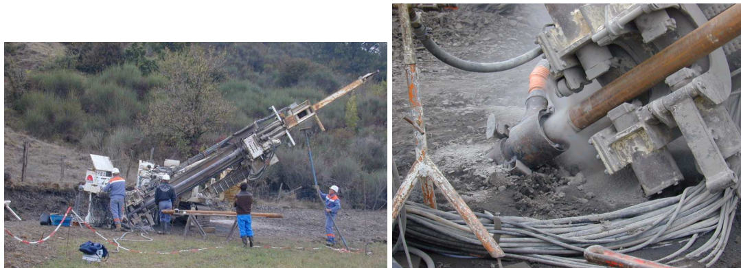
Figure 14 : Réalisation du forage à Laumiere coté est (A), tête de forage (B)
