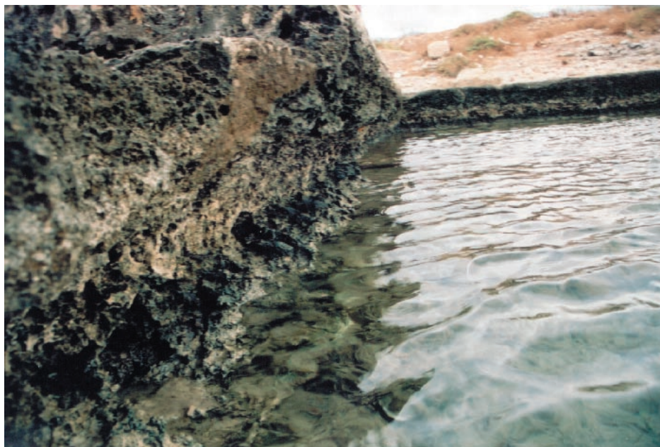
Détails du vivier : encoche dans le bassin principal
