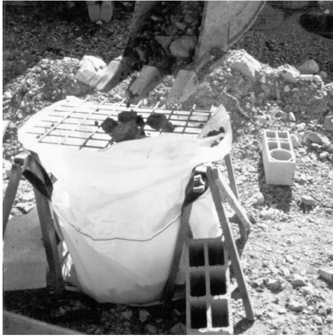
Figure 1-4. Tamisage in-situ à l'aide d'une grille à maille carrée d'ouverture 100 mm.
