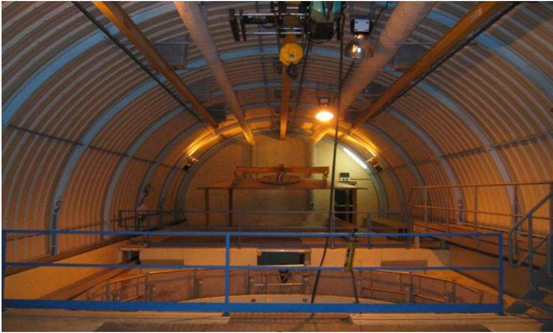
FIG. IV.15 : Photographie du laboratoire du site lointain de Double Chooz, prise en septembre 2003. Le hall d'expérience Chooz-I construit par EDF est localisé à proximité de l'ancienne centrale nucléaire souterraine Chooz A. Ce site est encore en parfait état et peut être réutilisé pour Double Chooz sans travaux de génie civil supplémentaires autres que des rénovations.
