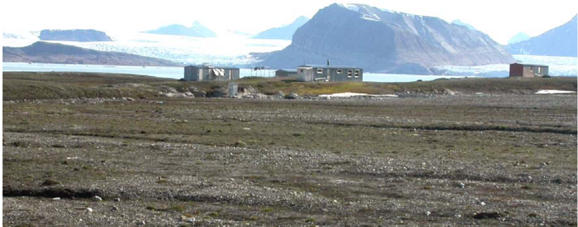
Photo 2 – Les bâtiments de la base J. Corbel, entourée par la toundra à Dryas octopetala . Prise de vue vers le nord-est, juillet 2004.
