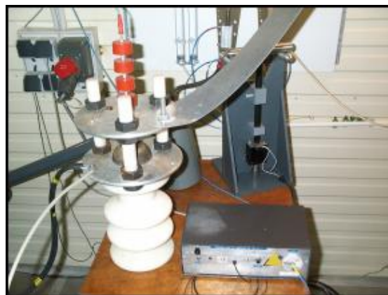
Figure II-7 : Commutateur associé à son système de déclenchement
