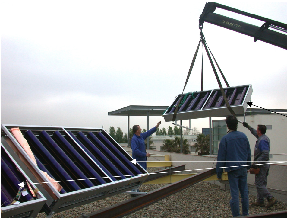
Installation des capteurs sur le toit
