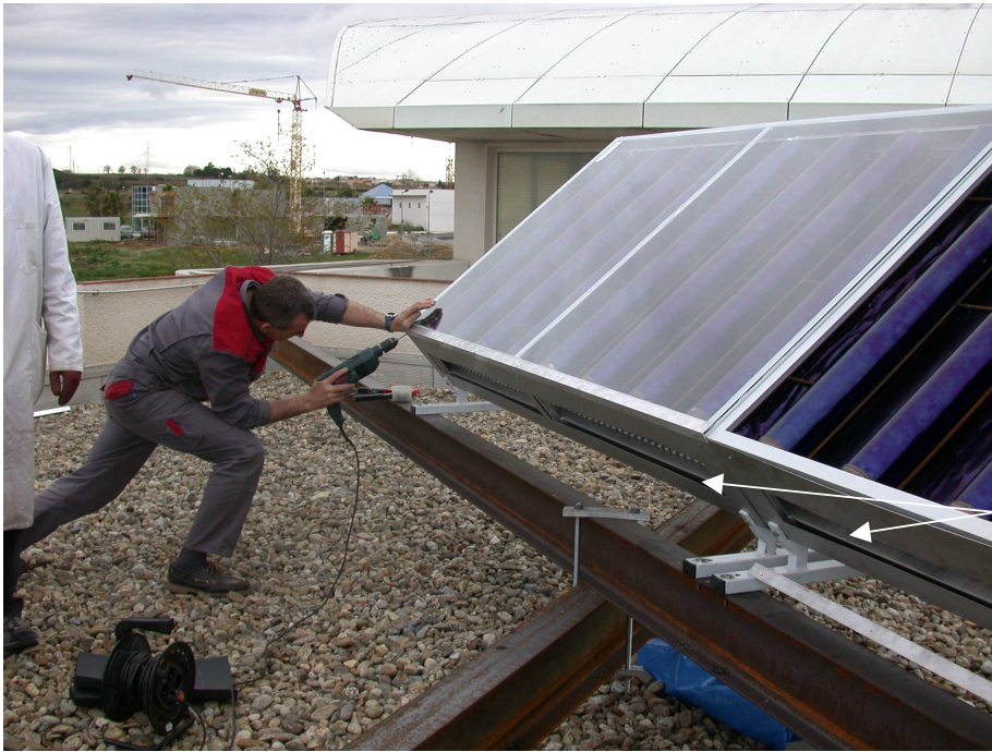
Mise en place du vitrage du capteur 2
