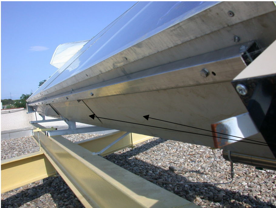
Volets mis en place pour bloquer la convection diurne
