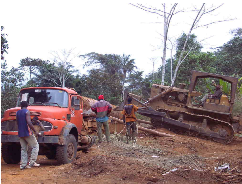
Fig. 22 : Chargement d’un grumier par bulldozer faisant glisser les grumes sur une rampe, dans la province du Bas-Congo, RDC (Photo JM Roda)
