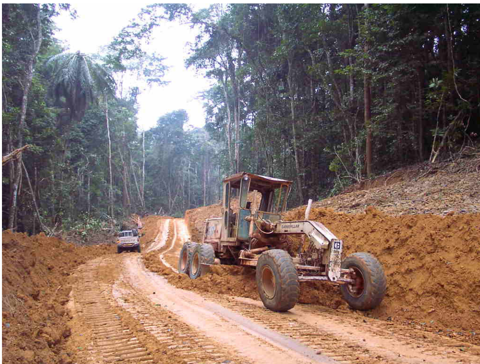
Fig. 17 : Niveleuse au travail sur une nouvelle route forestière au Gabon (Photo JM Roda)
