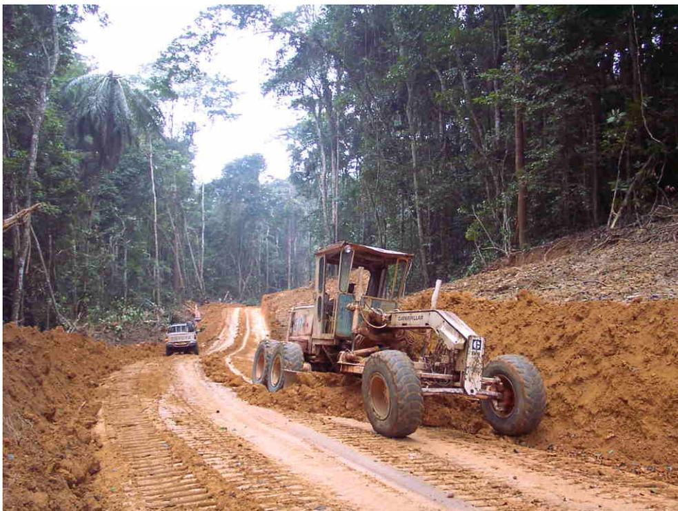
Fig. 17 : Niveleuse au travail sur une nouvelle route forestière au Gabon (Photo JM Roda)
