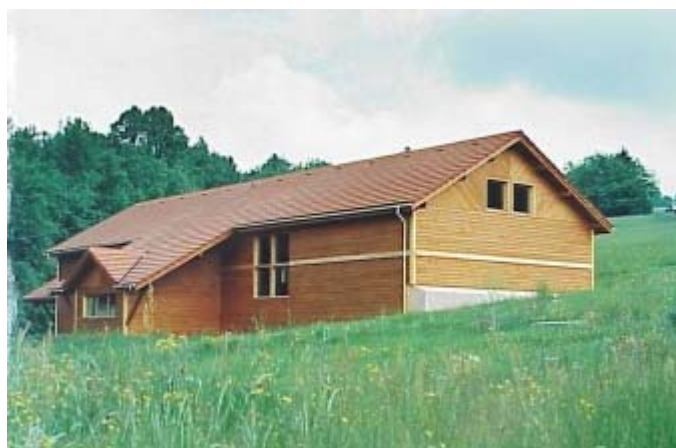
Figure 4.17 : Vue extérieure du Laboratoire de Mesure Magnétique en Champ Faible
