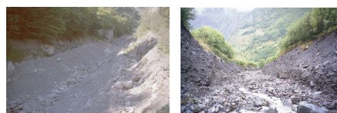
Figure 1-11 Formes caractéristiques du chenal à laves torrentielles, avec un profil en travers en "auge": représentation schématique (LeMéhauté, 2000), et exemples du chenal du Manival en aval du barrage RTM n°30 et de la baraque forestière (clichés S.V.C.)
