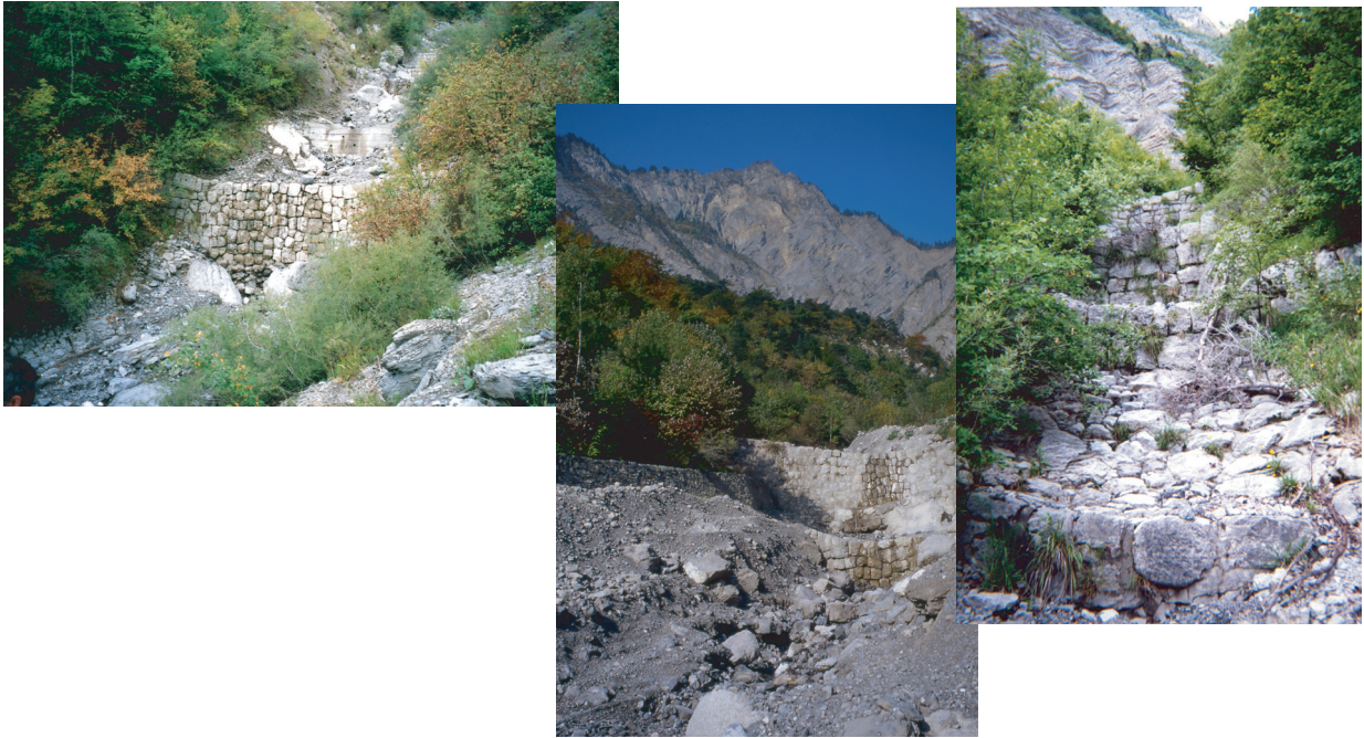
Figure 1-24 Barrages et seuils de correction torrentielle sur le chenal du Manival et ses ravins affluents (clichés S.V.-C.)
