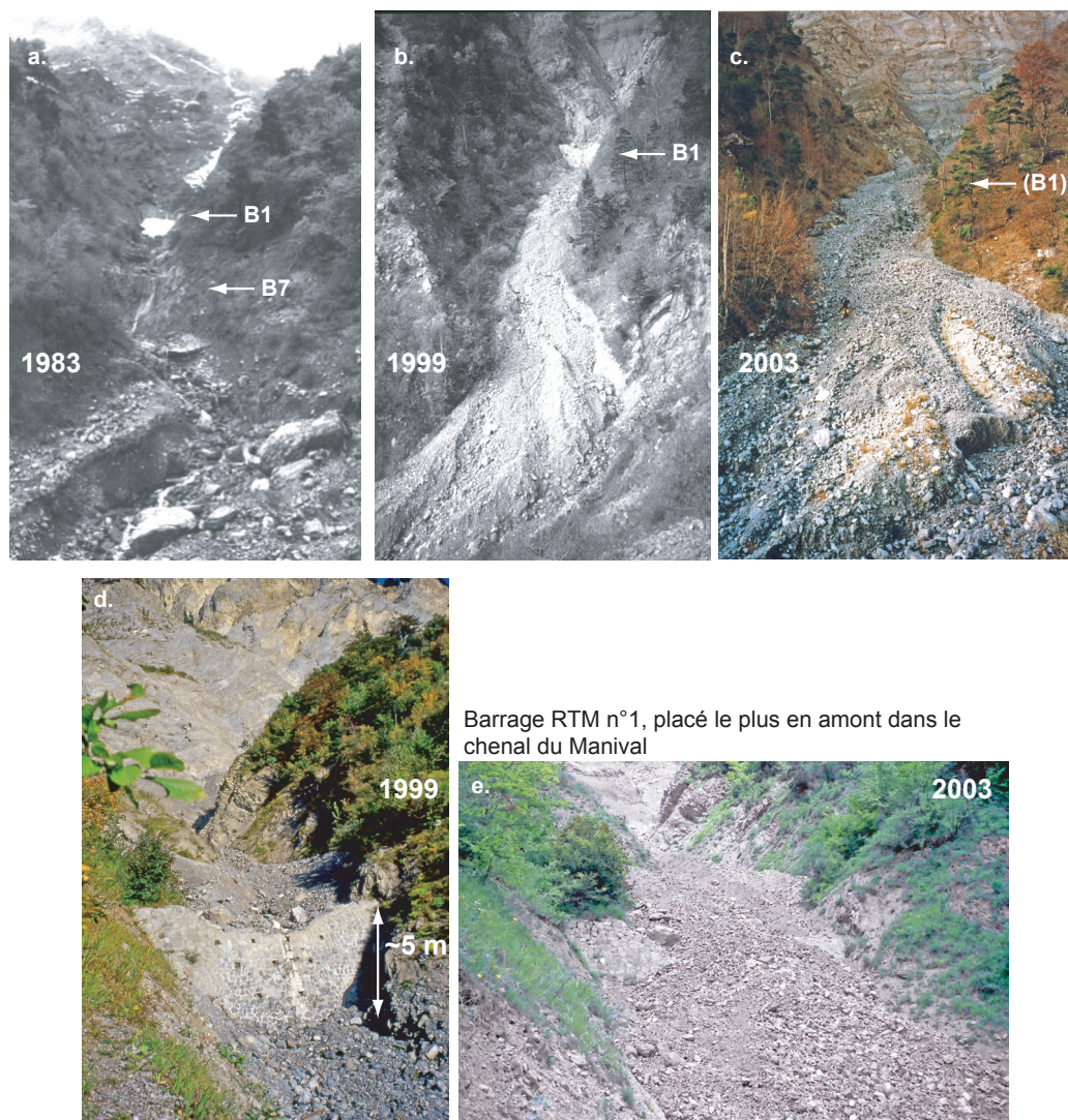
Figure 3-45 La zone de SPOTS du chenal entre le barrage RTM n°1 et 10 a une forte pente de plus de 20° mais permet pourtant une forte capacité de stockage des matériaux. Les barrages n°1 et 7 (B1 et B7) ont une hauteur totale de 7 m (Clichés RTM38 et S.V-C.)
