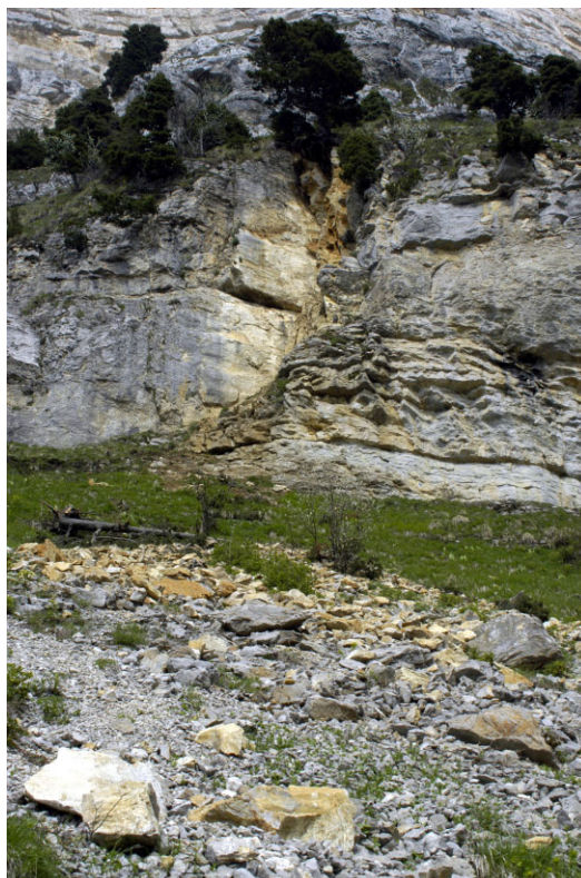
Photo 4 : Eboulement de l'escarpement secondaire du talus d'éboulis de La Plagne (printemps 2004).
