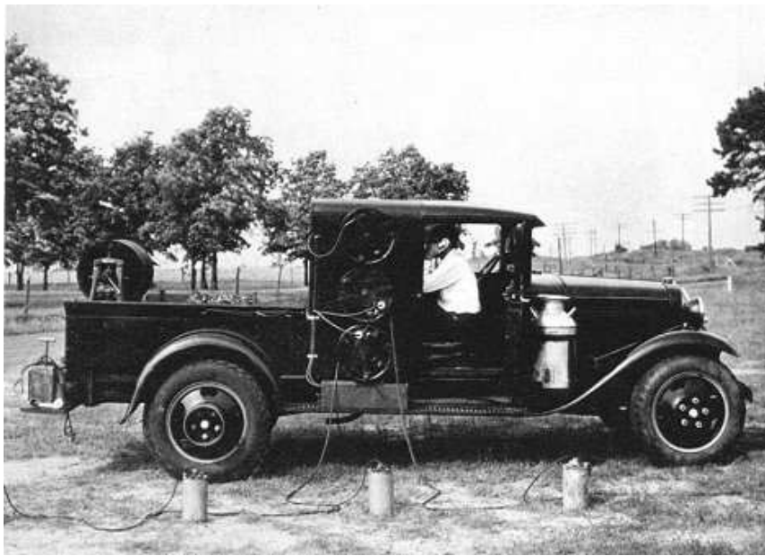
FIG. 2.1 – Campagne de sismique réflexion à Dallas en 1931. Chaque géophone (premier plan) pèse 16 kg. Une chambre noire était ammenagée dans le camion afin d'imprimer les signaux sismiques (Society of Exploration Geophysicists).
