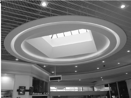
Photo 11 : Recherche de luminosité à l'aide de puits de lumière dans les centres commerciaux (Pôle Sud Basse-Goulaine, janvier 2005)
