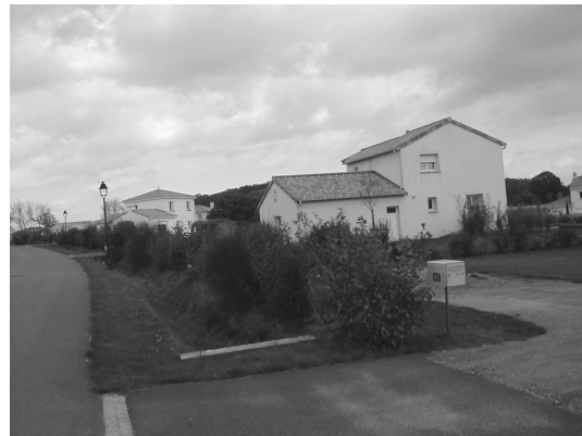
Photo 2 : Voirie volontairement basique du lotissement de la Vinalière (Le Cellier, décembre 2004)
