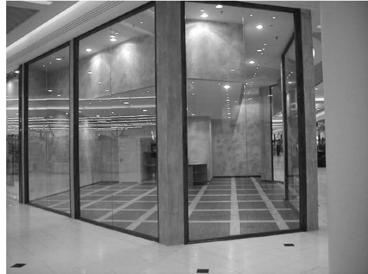
Photo 12 : Multiplication des espaces vitrés pour les boutiques des centres commerciaux (Pôle Sud Basse-Goulaine, janvier 2005)
