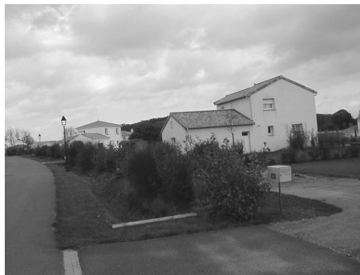
Photo 2 : Voirie volontairement basique du lotissement de la Vinalière (Le Cellier, décembre 2004)
