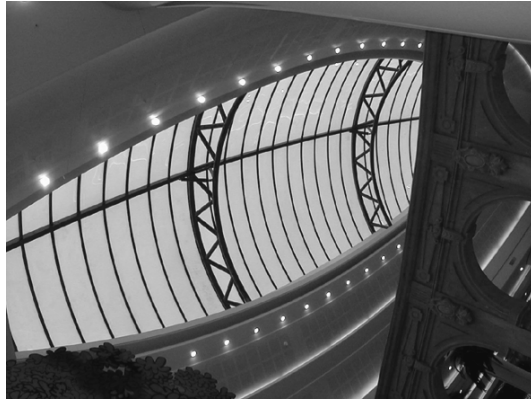
Photo 7 : Plafond de galerie marchande sur le modèle des passages du XIX e siècle (Pôle Sud Basse-Goulaine, janvier 2005)
