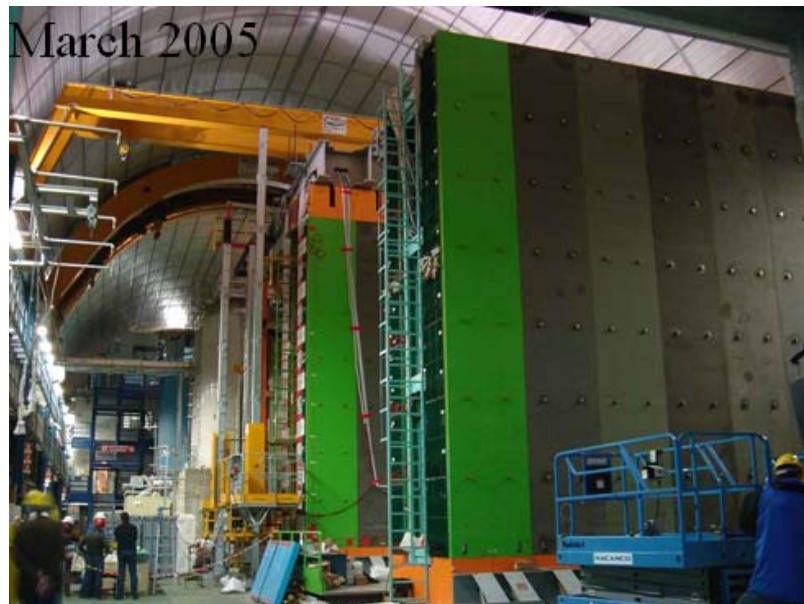
FIG. 2.23 – En mars 2005, le deuxième aimant est complètement installé.
