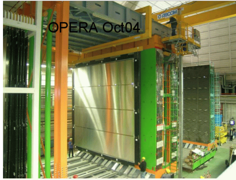
FIG. 2.22 – En octobre 2004, le premier aimant est entièrement installé et les premiers plans de Target Tracker sont mis en place et testés.
