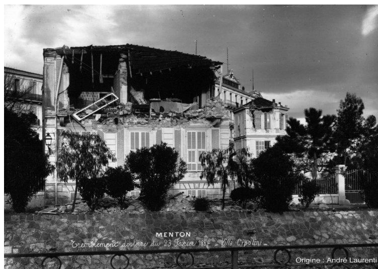
FIG. 4.1: Types de dommages causés par le séisme Ligure ( M \sim 6.2 - 6.5 , 1887), dans la ville de Menton (20 km de Nice).
