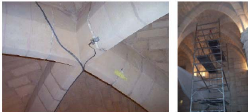
Figure 1-16 : Capteurs pour la surveillance de monuments historiques.
