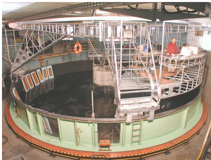
Photo de la plate-forme tournante avec sa nouvelle structure.
