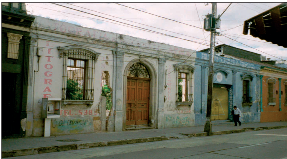
Photographie 26 - Façade d'une maison coloniale du centre de Ciudad de Guatemala, détruite lors du dernier tremblement de terre de 1976. La façade plus résistante que le corps du bâtiment a été conservée, mais dissimule un flot vide (Cliché : S. Hardy, 2002).
