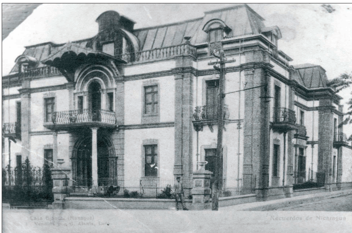
Photographie 13 - Edifice ostentatoire de Managua, construit au XIX e siècle en pierre de taille dans le centre colonial. Il était inadapté au site et s'effondra sous les oscillations du séisme du 31 mars 1931 (Cliché : Archives de l'IHNCA).
