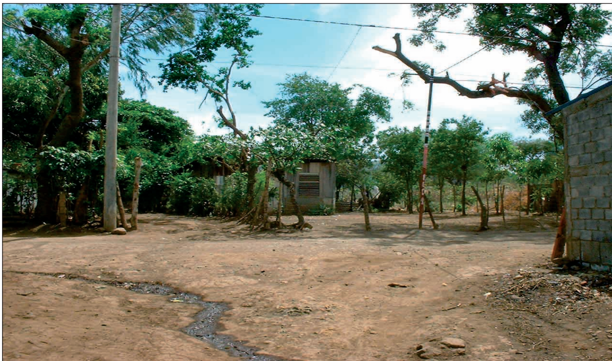
Photographie 20 - Le quartier de Germán Pomares se caractérise par l'absence de pavage des rues et d'infrastructures de drainage des eaux pluviales et des eaux résiduelles, par ses logements précaires. Mais, les habitants ont réussi à y faire circuler une ligne de bus, qui, en les reliant cahin-caha aux autres territoires urbains, leur évite la marginalisation (Cliché: S. Hardy, 2000).
