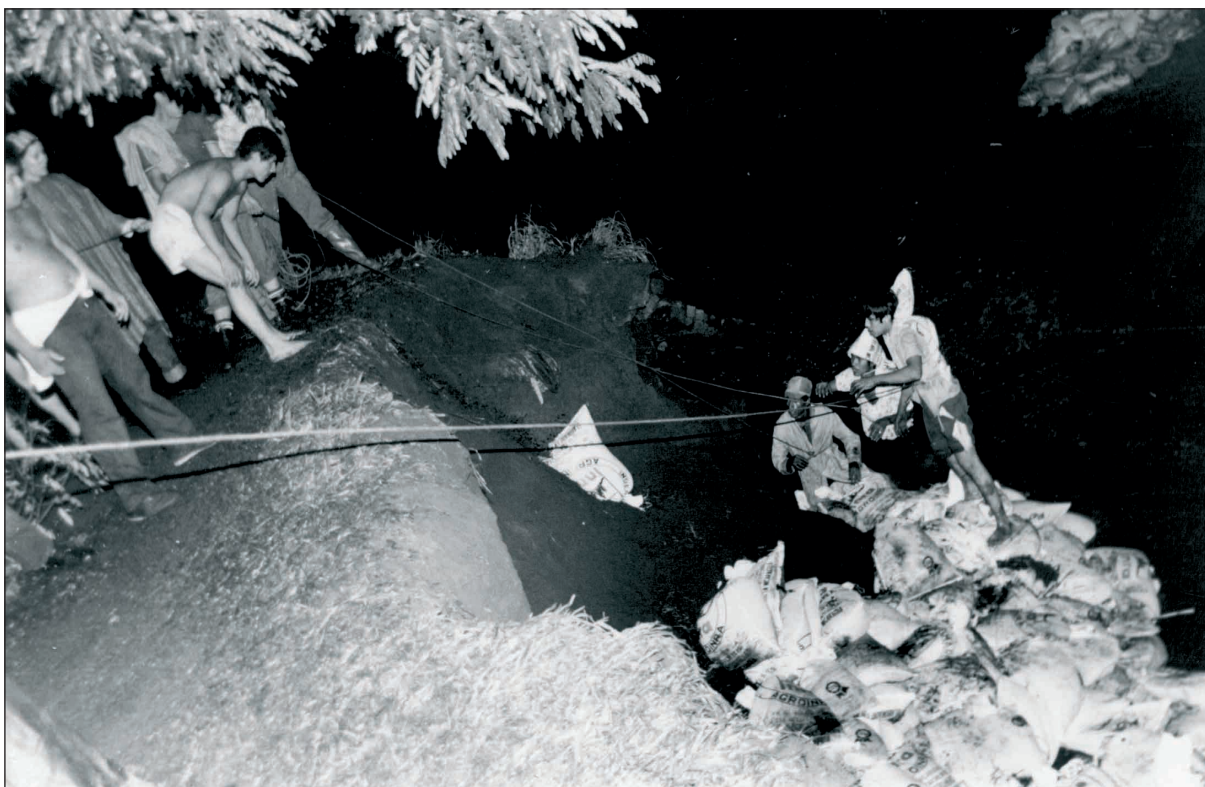
Photographie 11 - Les Sandinistes ont su mobiliser les populations autour des opérations de secours en cas de catastrophe. Avec des cordes pour assurer leur vie, les brigadiers placent des sacs de sable à la base des versants d'un cauce pour éviter que le sapement produit par la force de l'eau boueuse ne détruise la maison construite à proximité (Cliché : Archives de l'IHNCA).
