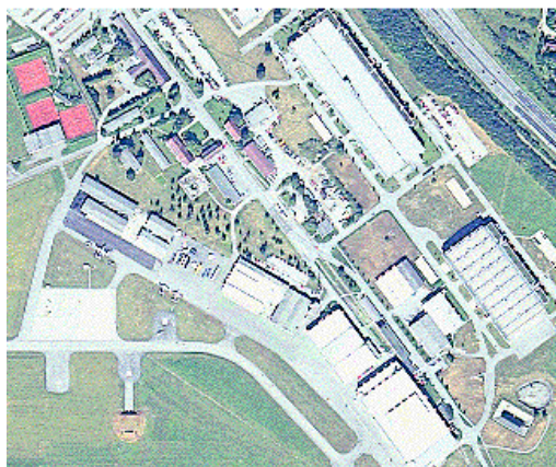
FIG. 5.22 – Image optique des bâtiments étudiés.
