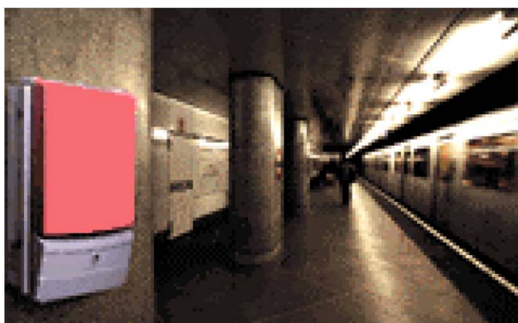
Figure 1.2 : Photographie d'une MicroBTS (petite station de base, à portée limitée) en Indoor 191
