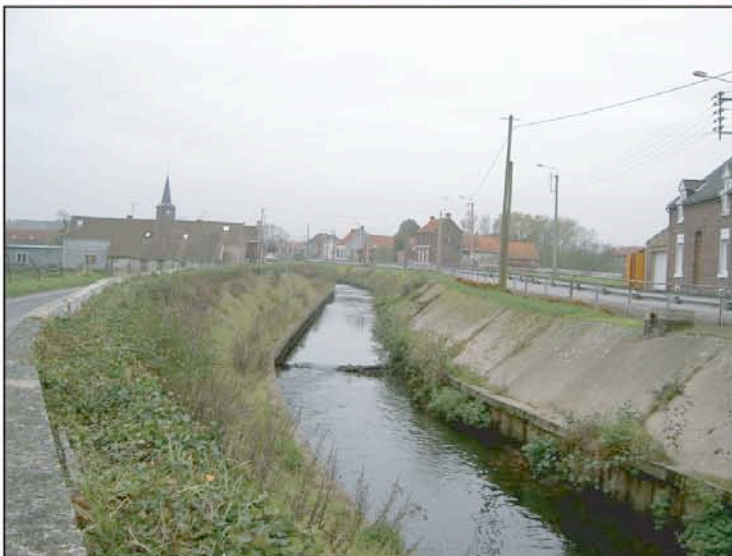
L'Hogneau à Thivencelle: le risque d'inondation lié à l'endiguement du cours d'eau est important. Vue vers le Sud
