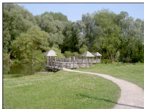
Pilotis au ras de l'eau
