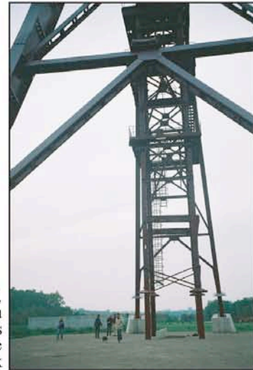
Sous le chevalement, une dalle de béton où les promeneurs peuvent lire l'histoire de la fosse Ledoux
