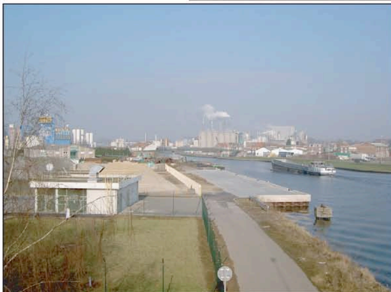
La Deûle après l'écluse de Don (amont du parc de la Deûle). Malgré l'aspect plus naturel des abords, les berges du canal sont toujours constituées de palplanches. (vue vers le N)
