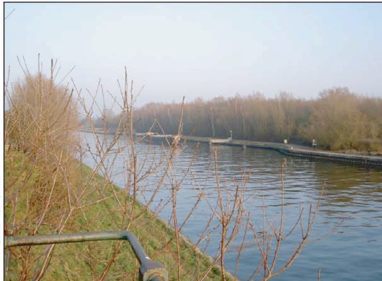
La Deûle après l'écluse de Don (amont du parc de la Deûle). Malgré l'aspect plus naturel des abords, les berges du canal sont toujours constituées de palplanches. (vue vers le N)
