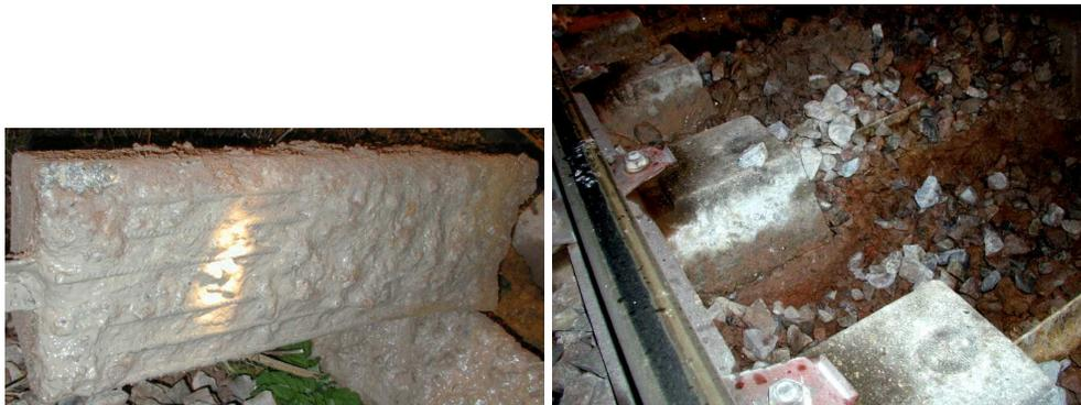
FIG. 1.16 – Surface inférieure d’une traverse et résultat de la production de fines sous la traverse en place.
