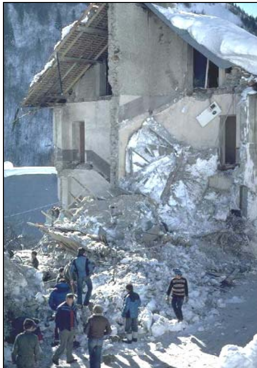
Figure 4.14 : Bâtiment partiellement détruit - St-Colomban des Villards, 1981 – Cemagref - F. Valla
