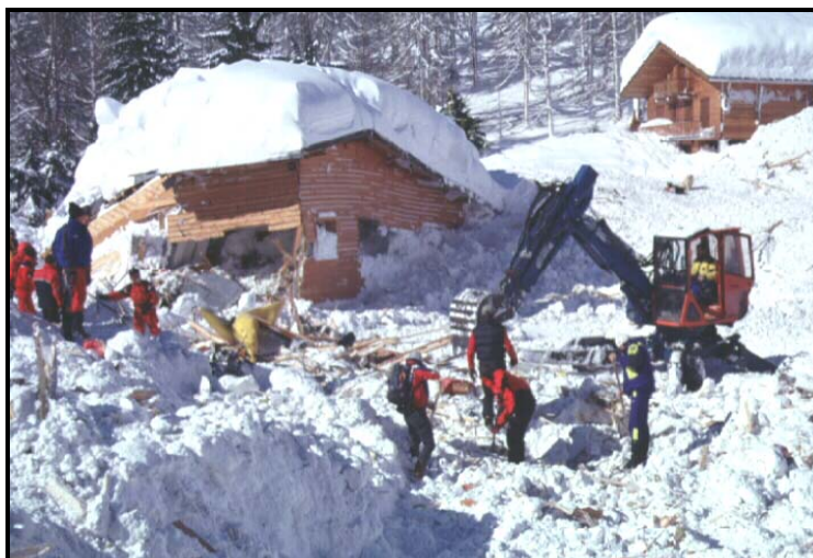
Figure 4.15 : Partie supérieure d'un chalet déplacée – Montroc, 1999 – Cemagref - F.Rapin
