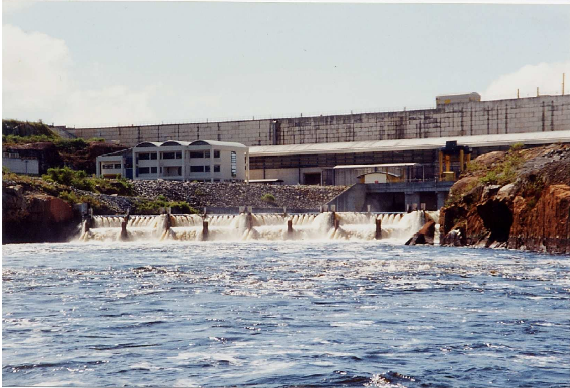
FIG. 2.4 – Le seuil aérateur situé en aval des turbines du barrage de Petit-Saut.
