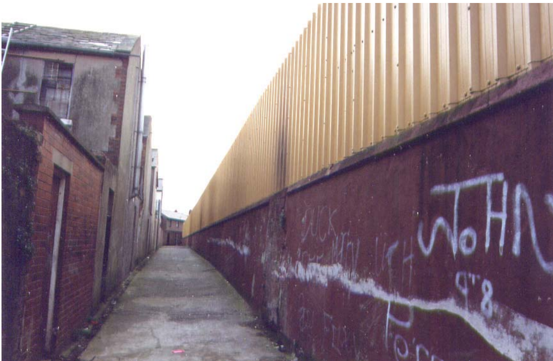
Figure 132 : Peaceline , mur de brique surmonté d'une palissade en acier, vu de l'arrière d'Oldpark Avenue (13 mars 2000)
