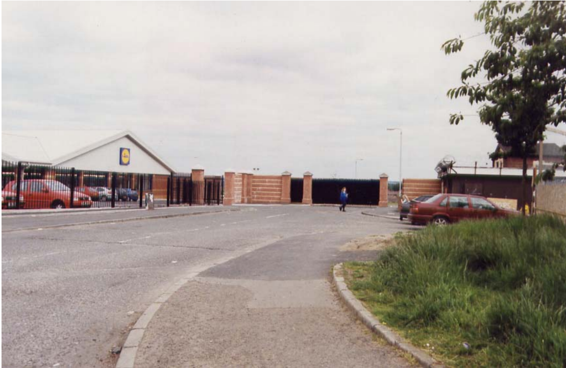
Figure 152 : Portail de sécurité rénové et supermarché Lidl , Stewartstown Road/Kells Avenue (4 juin 2001)
