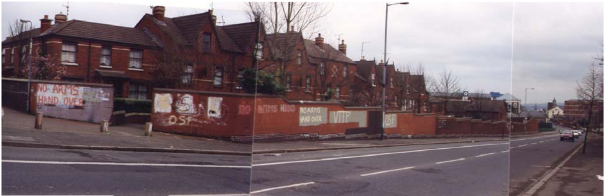
Figure 101 : Peaceline , Crumlin Road, Ardoyne, vue de la route (13 mars 2000)
