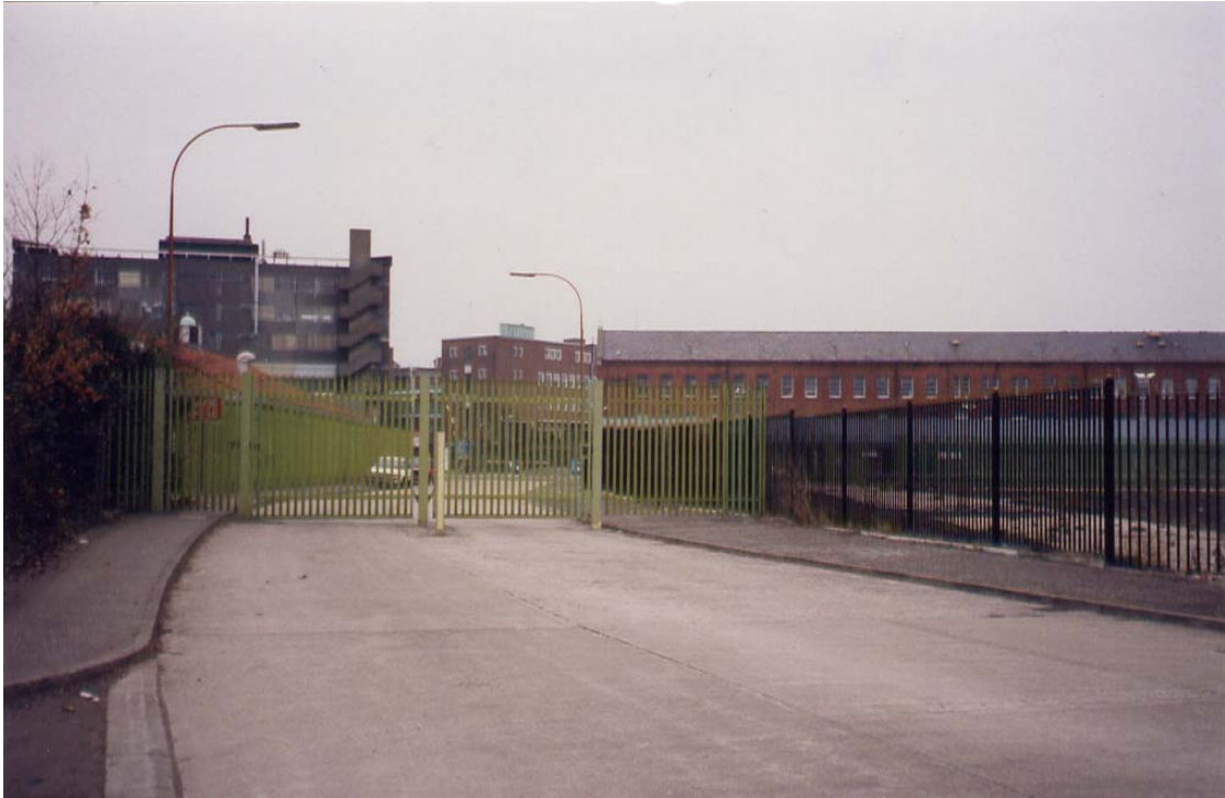
Figure 107 : Portail de sécurité privé, Mulhouse Road (22 mars 1998)
