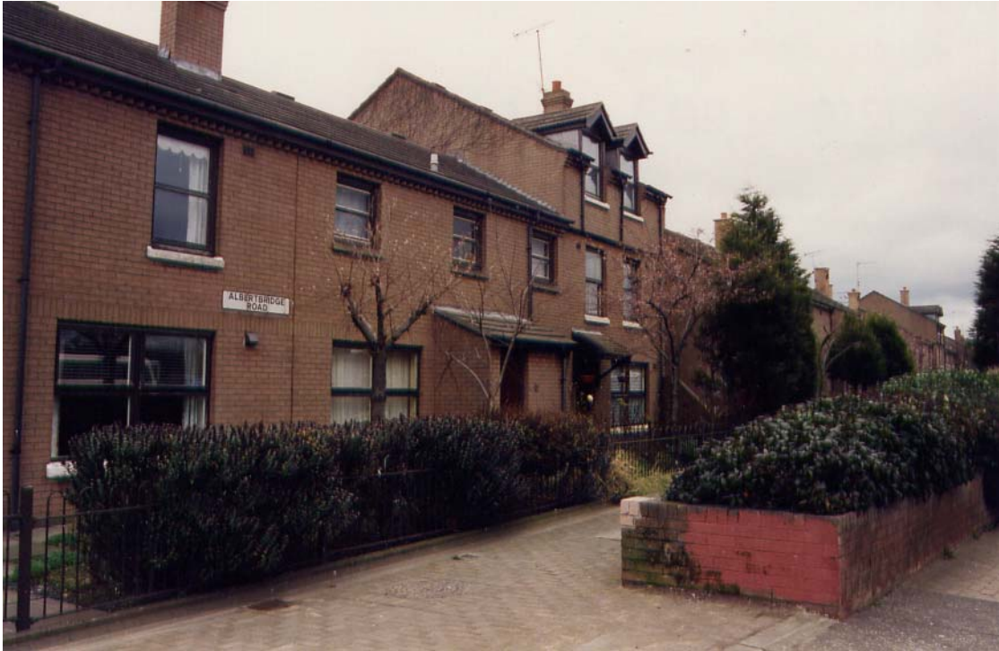
Figure 143 : Albertbridge Road, aménagement paysager (mars 2000)
