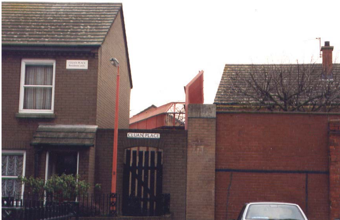
Figure 82 : Mur de sécurité, vue de Cluan Place (mars 2000)
