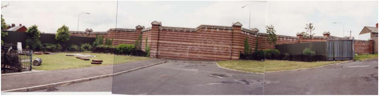
Figure 131 : Peaceline , second mur de brique, vu de Torrens Road (2 juin 2001)
