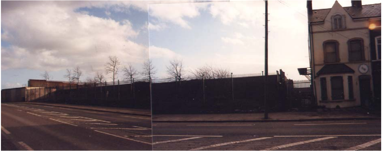
Figure 125 : Mur de sécurité, vu de Springfield Road (3 mars 2000)
