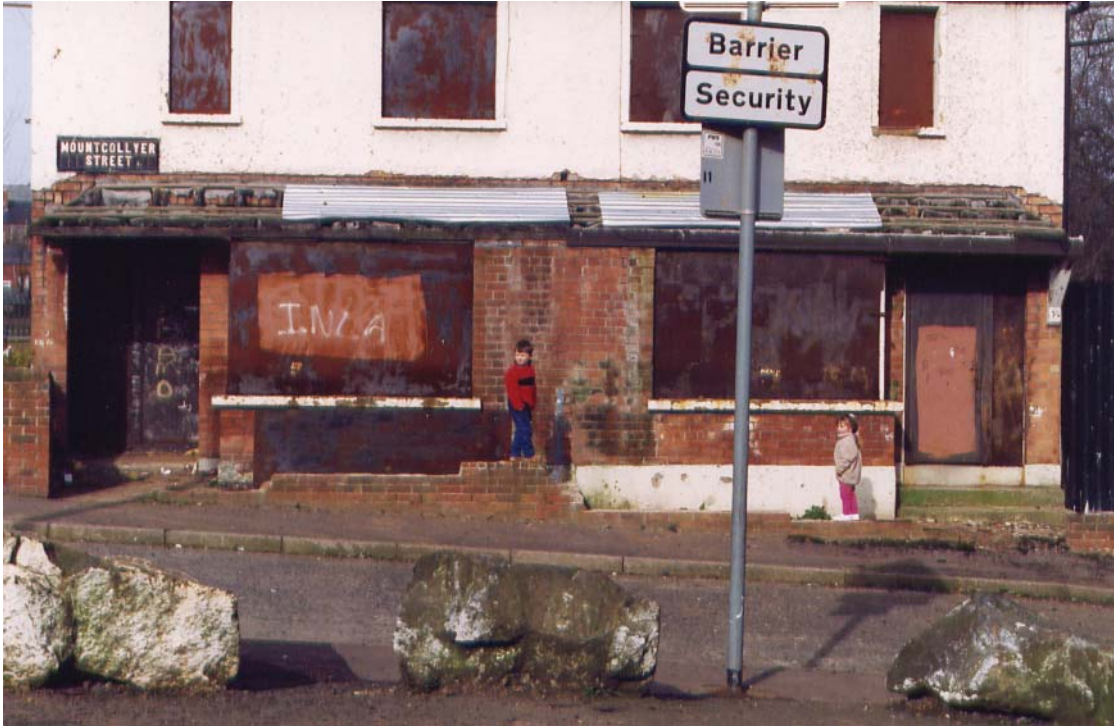
Figure 134 : Mountcollyer Street, au carrefour de Parkside Gardens, vue rapprochée, avant démolition et transformation de la peaceline (mars 1999)
