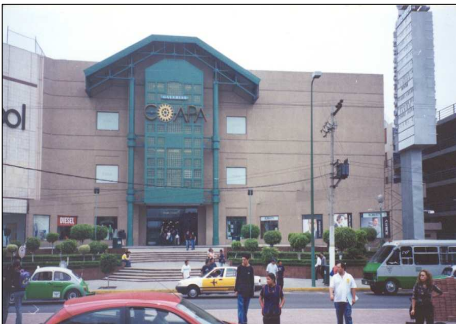
Photographie 5 : L'entrée principale avec son habillage portant le sigle de Galerías Coapa, et l'aménagement des espaces tampon y conduisant
