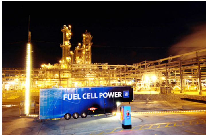
Figure 1.12 : Début de l'installation d'une pile à combustible de 35 MW dans la société Dow (Texas, USA [Gem]).
