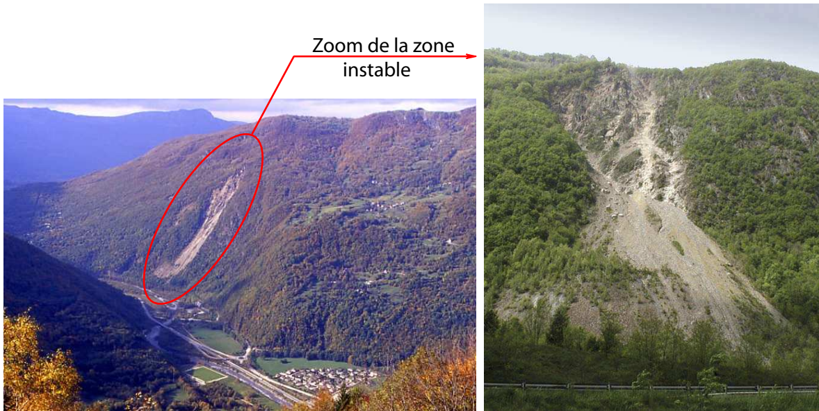
FIG. 1.1 – Glissement de terrains des ruines de Séchilienne en Isère
