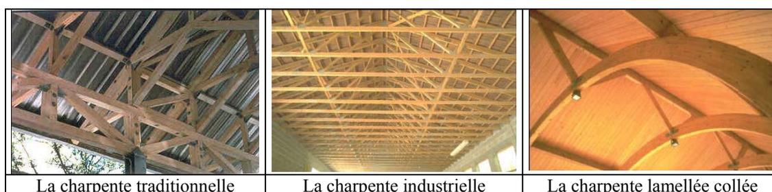
Figure 7– Les divers types des charpentes en bois
