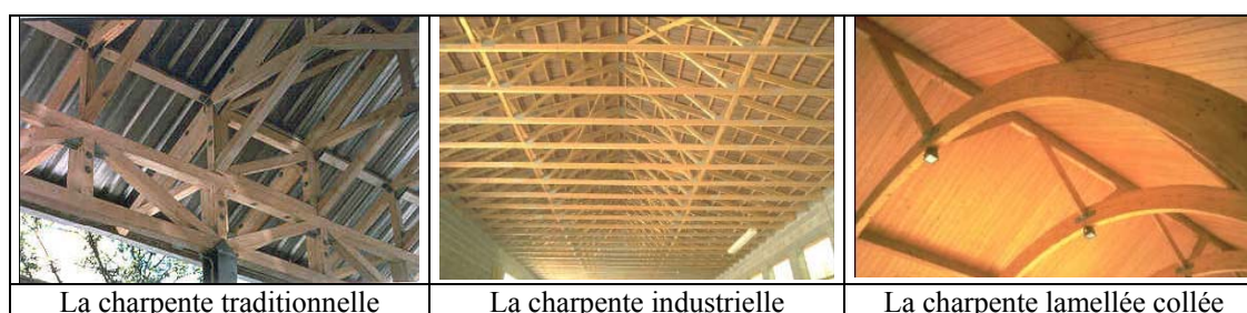
Figure 7– Les divers types des charpentes en bois
