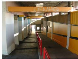
F Descente de galerie 150
