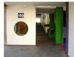
G Entrée de Galerie 150
