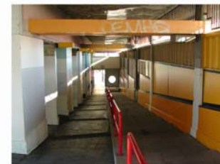
F Descente de galerie 150
