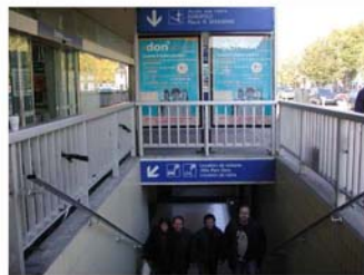
Ⓔ Descente du passage souterrain
