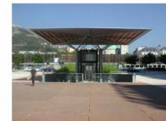
(H) Ascenseur et Escaliers
