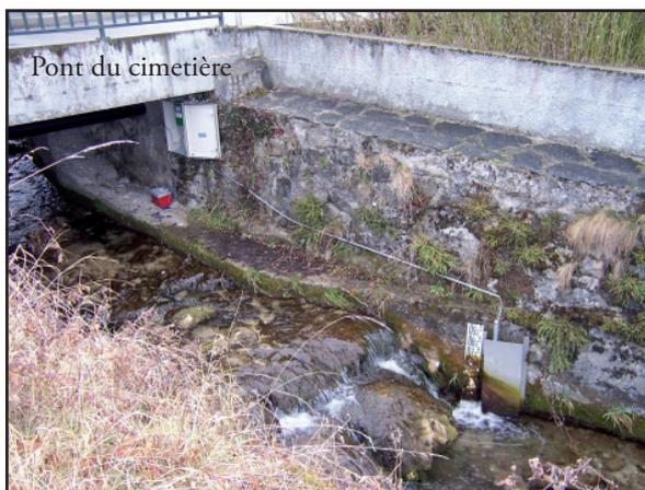
**Photo n°III.2 :** Station de mesure des hauteurs d'eau de Maxilly – Bassin versant de Copsy
