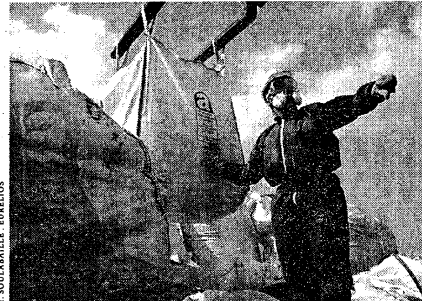
Un silo de stockage de sac d'amiante.
